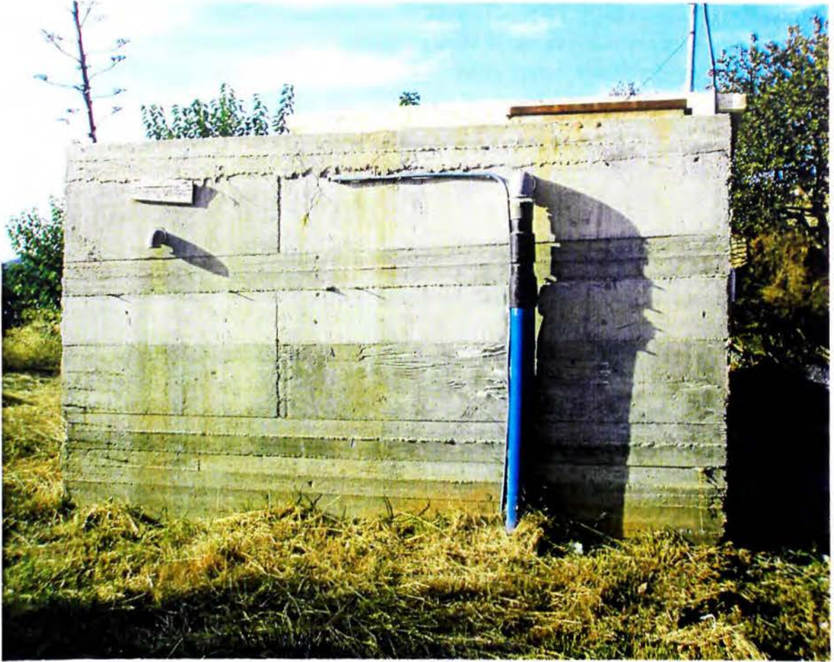
Δεξαμενή συγκέντρωσης πόσιμου νερού
