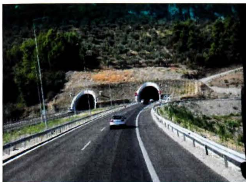
Εικ. 2.6 Σήραγγα Νεοχωρίου (χλμ. 138 από Αθήνα)
