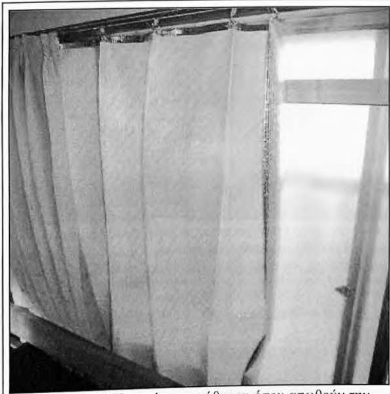
Εικόνα 1.96: Κουρτίνες παράθυρου όπου απωθούν την ηλιακή (θερμική) ακτινοβολία και διατηρούν την θερμοκρασία του χώρου που είναι εγκατεστημένες.
