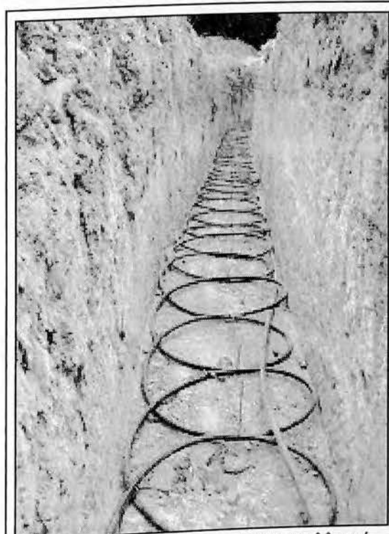
Εικόνα 1.104: Σπειροειδείς μεταλλικοί αγωγοί ενός γεωθερμικού συστήματος κατά την τοποθέτησή τους στο έδαφος.
