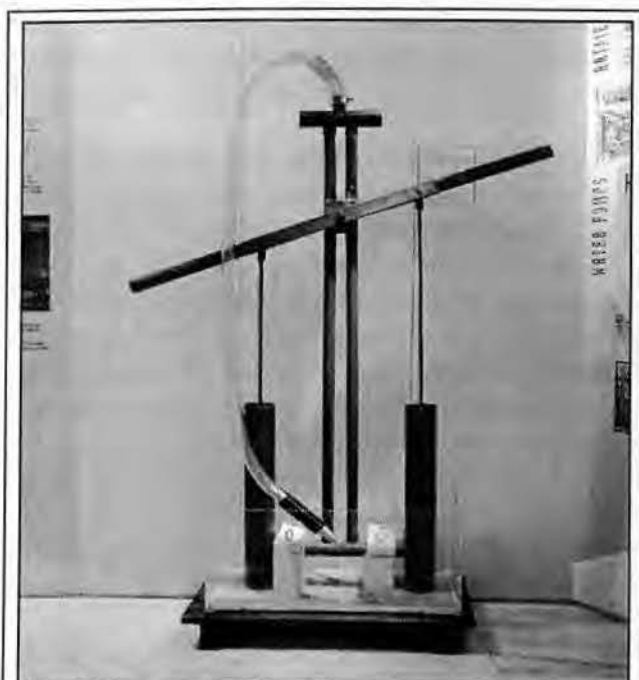
Εικόνα 1.8: Πιστό αντίγραφο της πυροσβεστικής αντλίας του Κτησίβιου που βελτίωσε ο Ήρων.
