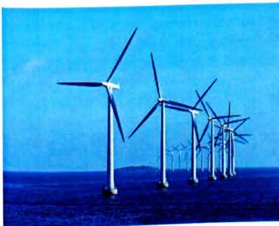
Εικόνα 37: Ανεμογεννήτρια τύπου Vestas 1500W εγκατεστημένες στη θάλασσα .
