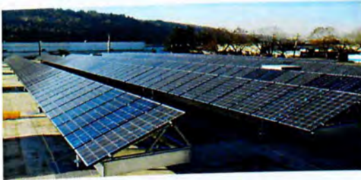
Εικόνα 25: σταθερό σύστημα σε επίπεδη οροφή κτιρίου.
