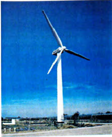
Εικόνα 36: Ανεμογεννήτρια wind master ισχύος 150KW .
