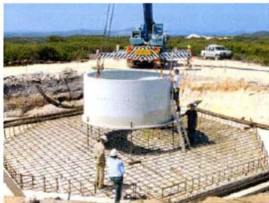
Σχήμα 36: Τοποθέτηση κεντρικής βάσης
