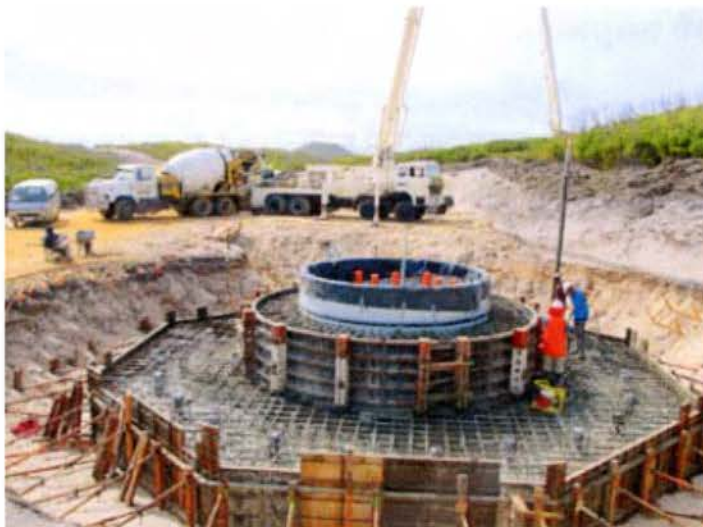
Σχήμα 37: Τοποθέτηση κεντρικής βάσης
