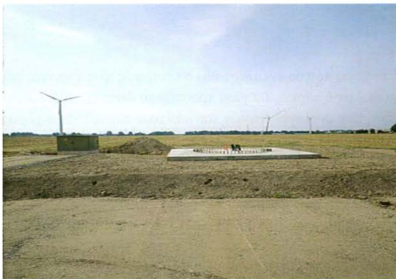
Σχήμα 32: Κατασκευή βάσεων στήριξης
