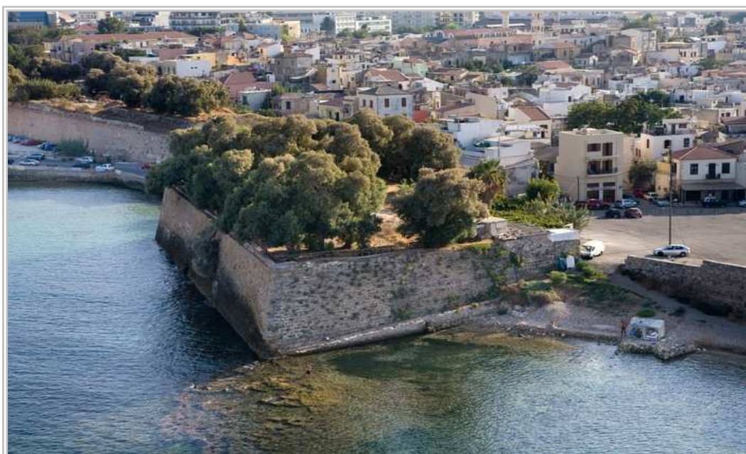
Άποψη του προμαχώνα Martinego.
