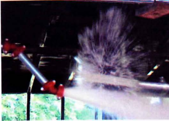
Εικόνα 2.4: Σύστημα αυτόματων καταιωνητήρων.
