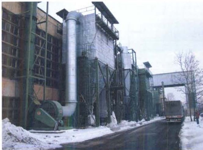
Σχήμα 3.3.2-2: Ολοκληρωμένο σύστημα αποκονίωσης εργοστασίου
