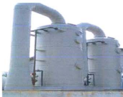
Σχήμα 3.3.3.4-1: Σύστημα αποκονίωσης με πύργους υγρής μεθόδου
