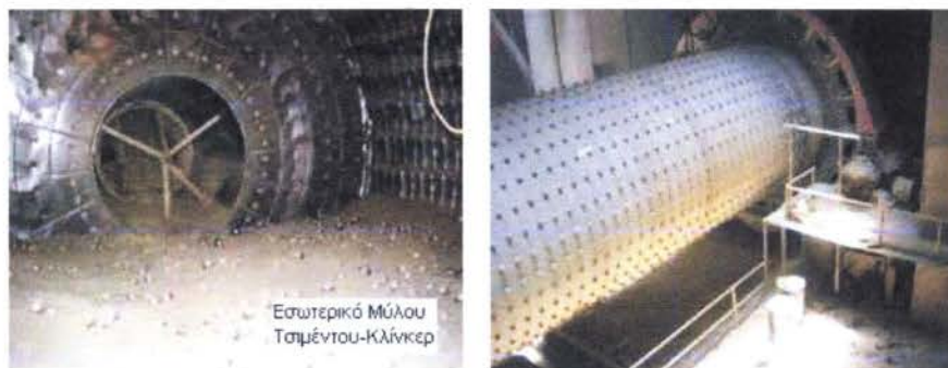
Σχήμα 4.1.5-2: Εσωτερικό μύλου τσιμέντου – πρώτη όψη κλίνκερ
