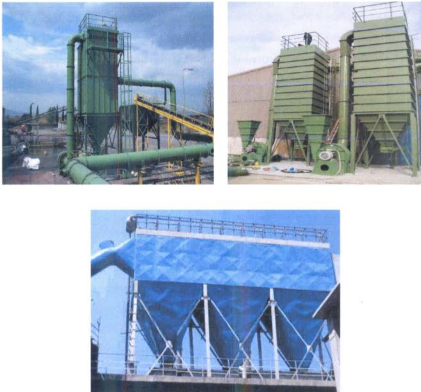
Σχήμα 3.3.3.5-1: Συστήματα αποκονίωσης – Σακκόφιλτρα διαφόρων τύπων
