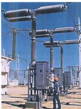
Σχήμα 2.2.2-1: Διακόπτης εξαφθοριούχου θείου ( SF_6 )
