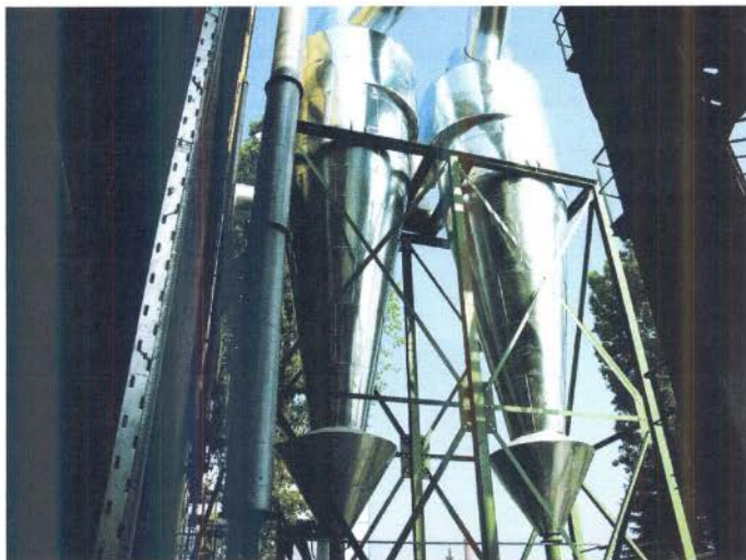
Σχήμα 3.3.3.2-2: Κυκλώνες υψηλής απόδοσης
