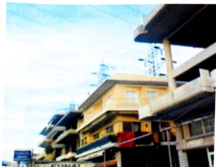
Σχήμα 3. Συστοιχία τριών πυλώνων από γραμμές μεταφοράς υψηλής ισχύος σε απόσταση αναπνοής από κατοικίες στην περιοχή του Αιγάλεω ( http://eprints.teikoz.gr/139/1/H7_2009.pdf )
