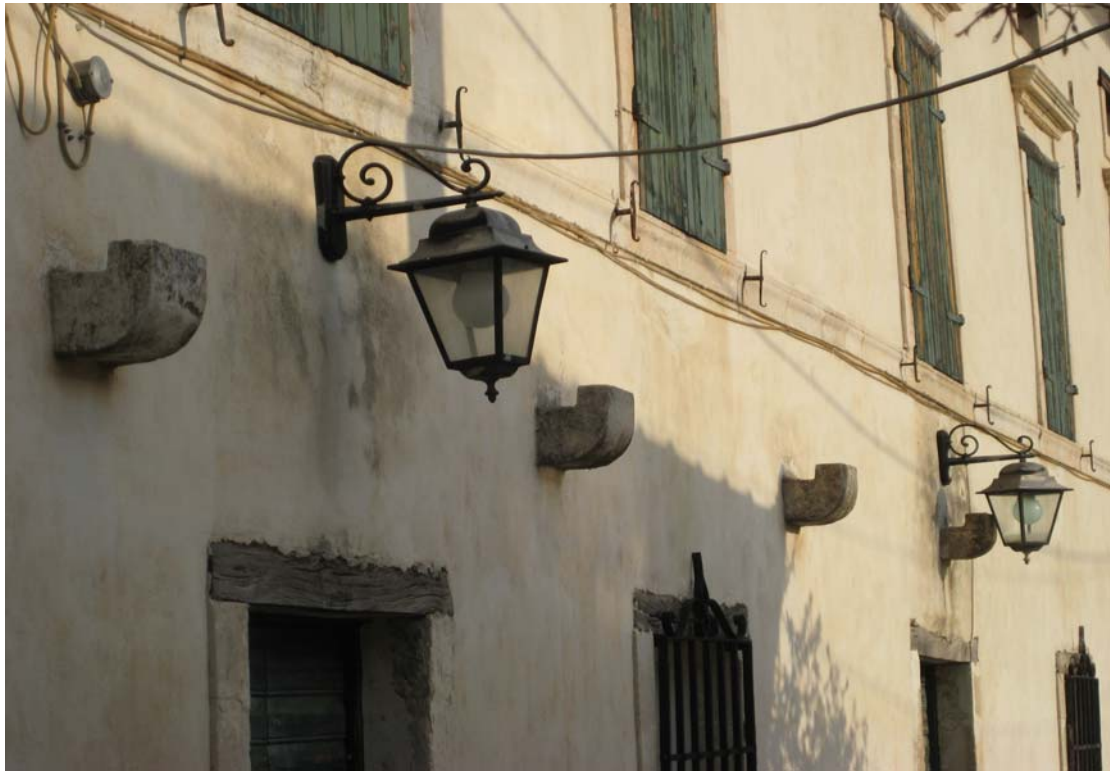
Εικόνα [36] Εξωτερική πλευρά με στηρίγματα για σκέπαστρο .
