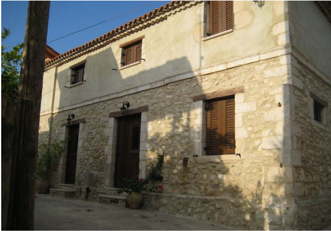
Εικόνα [20] Κατοικημένο κτίσμα παρόμοιας αρχιτεκτονικής .
