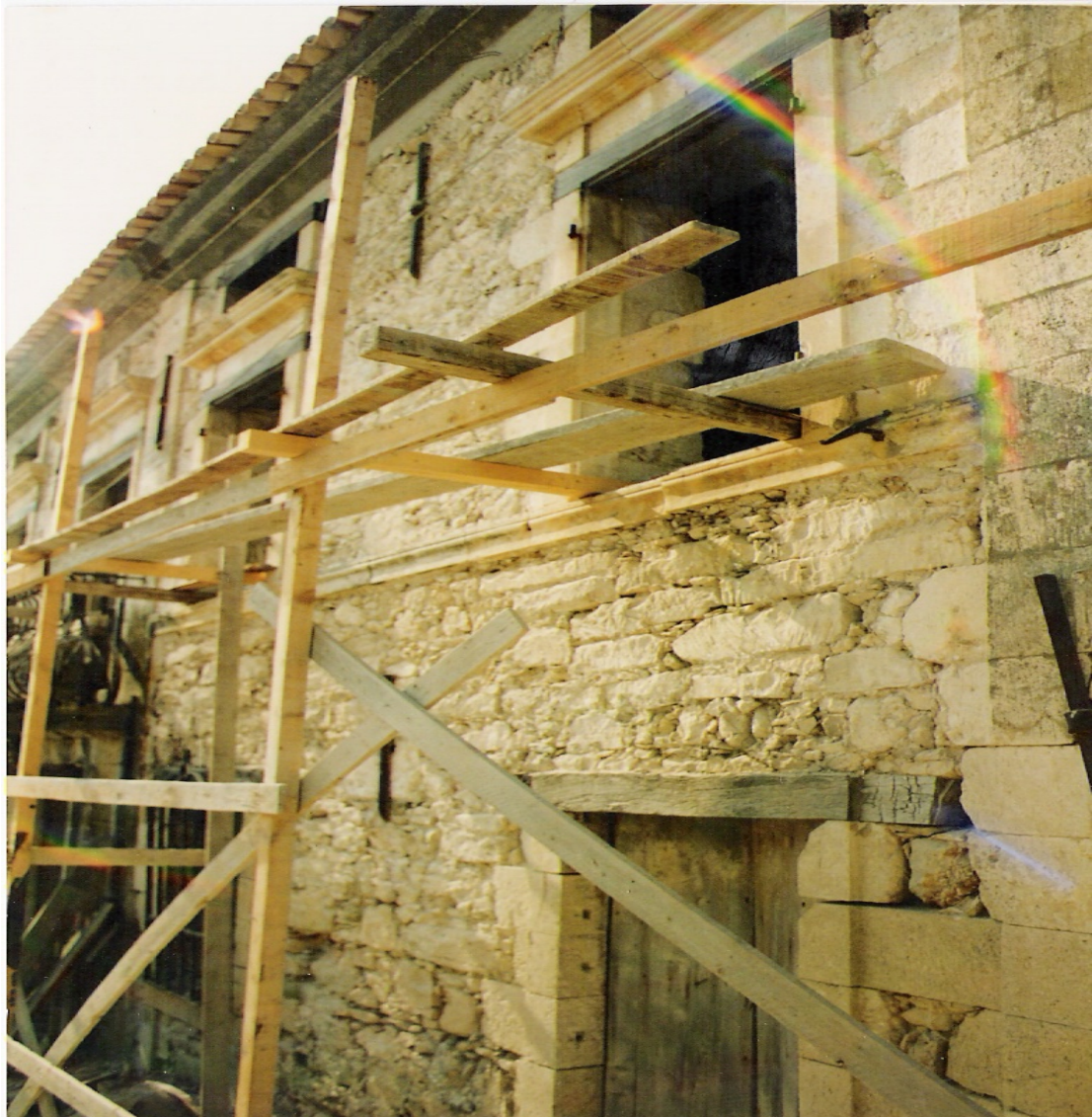
Εικόνα [45] Εξωτερικές επεμβάσεις – ξύλινα ικρίωματα .
