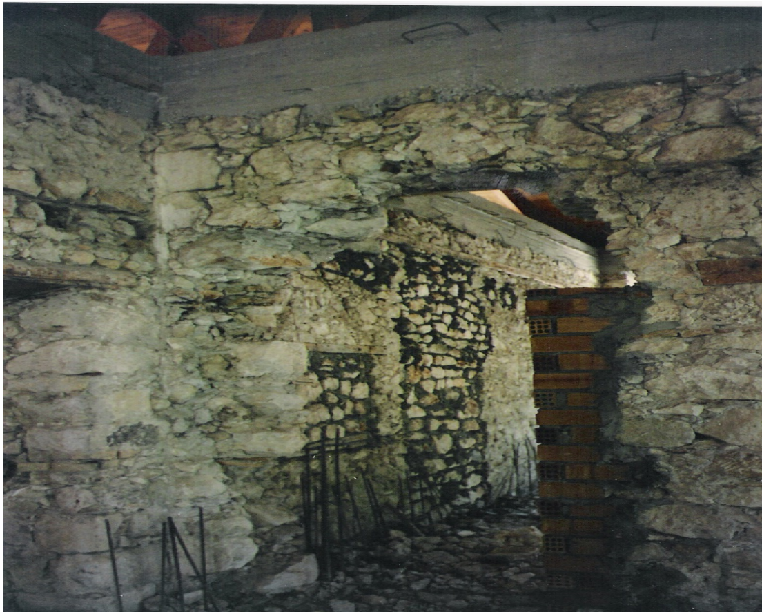
Εικόνα [42] Τμηματική αποκατάσταση και ενίσχυση .
