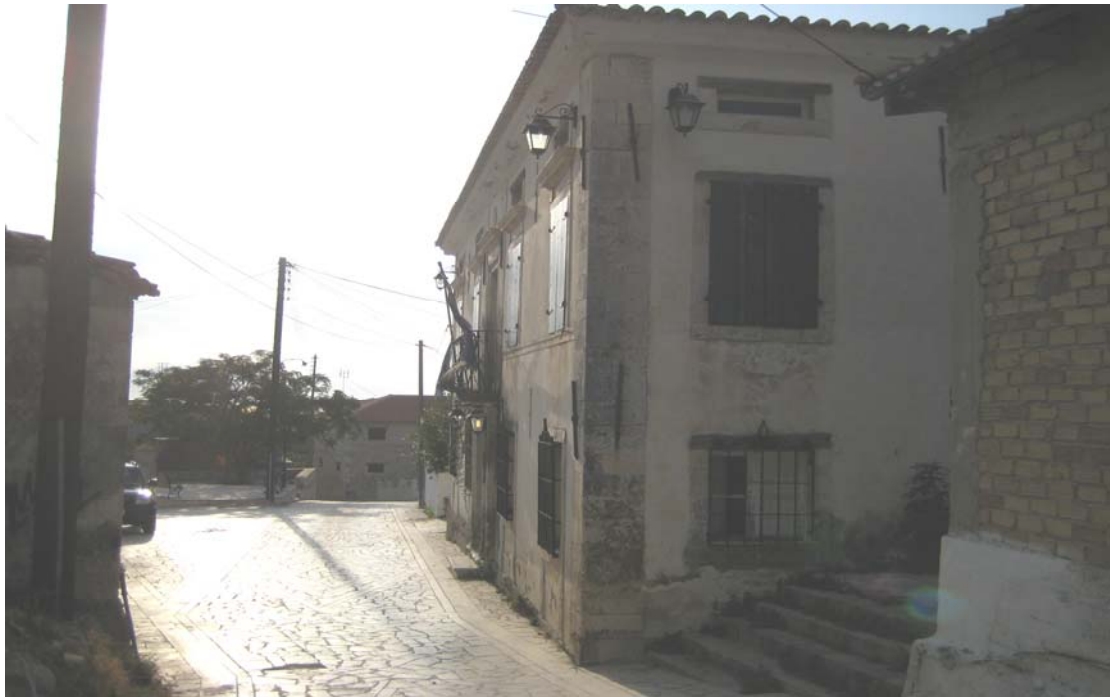
Εικόνα [80] Άποψη του κτιρίου .
