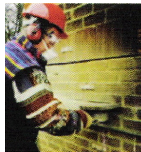
Εικόνες [51] και [52] Απομάκρυνση κονιάματος εκατέρωθεν της ρωγμής με τροχό
