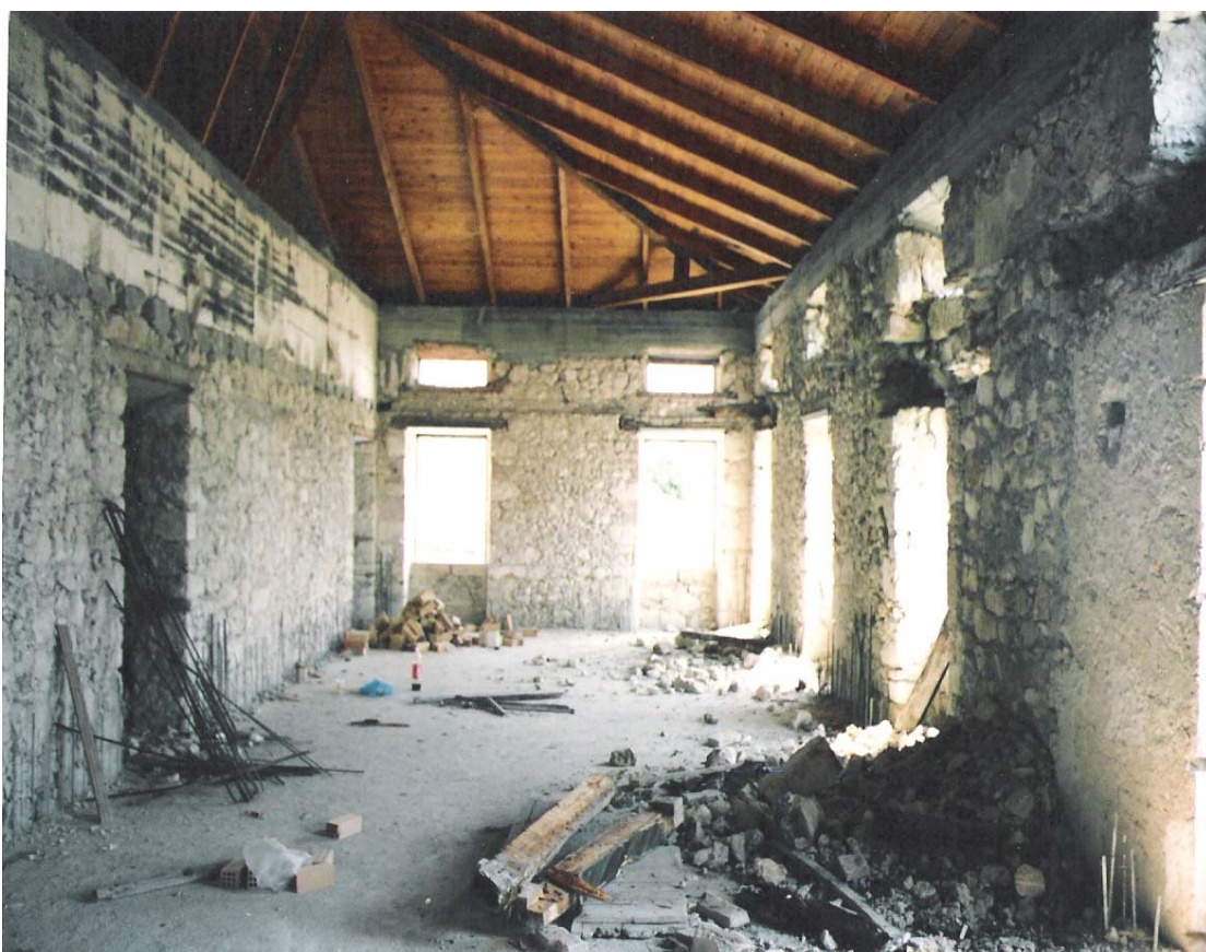
Εικόνα [79] Εμφανής στέγη με ξύλινα δοκάρια 8x16 και ταβανοπάτωμα .
