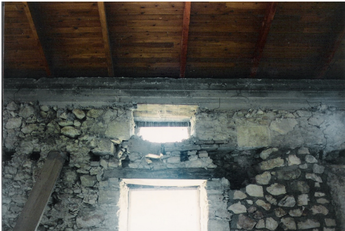
Εικόνα [29] Υποδοχές (παλιών) πατωματόξυλων σοφίτας (τωρινές φωλιές) .
