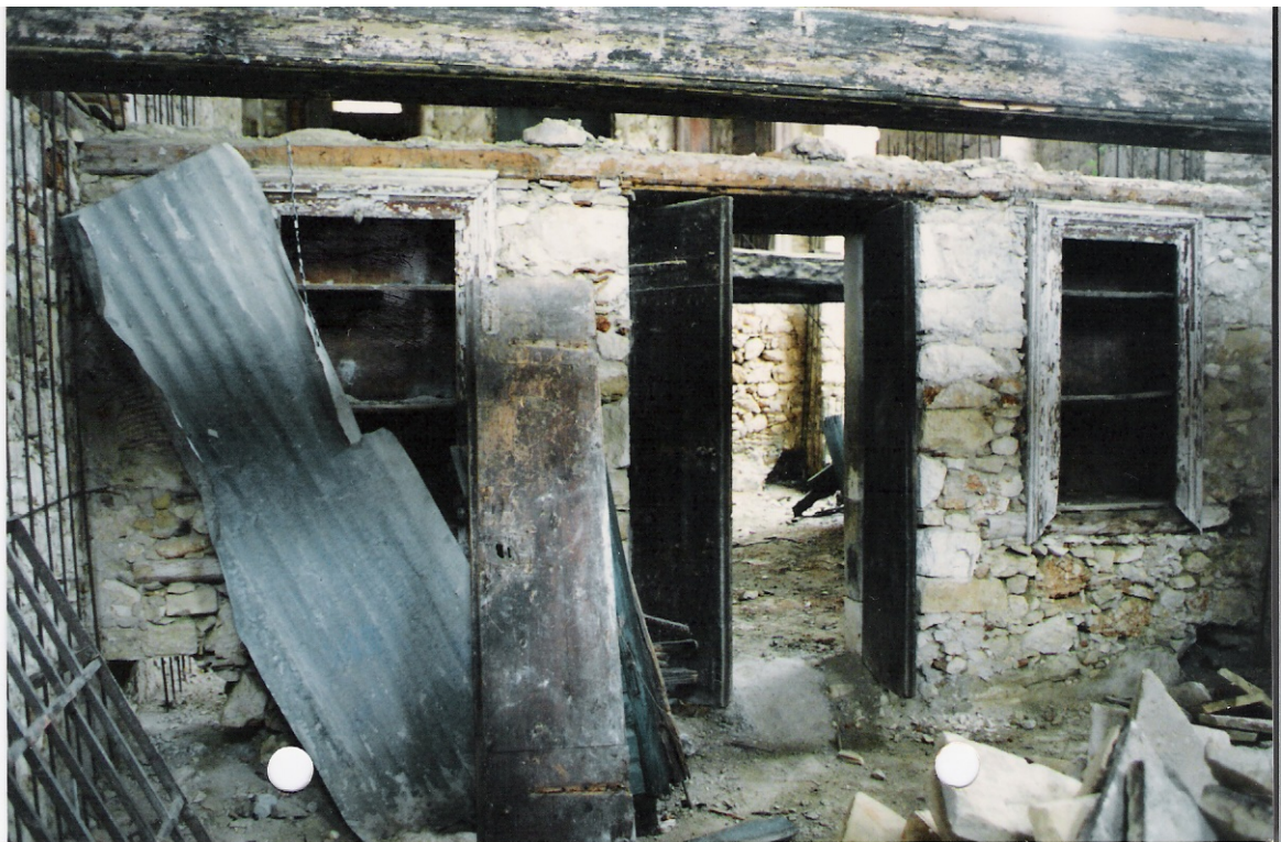
Εικόνα [40] Ενσωματωμένα ντουλάπια και δεσιές – ελκυστήρες .
