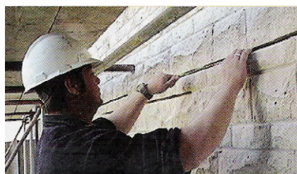
Εικόνα [62] Εισαγωγή ράβδου σε λιθοδομή
