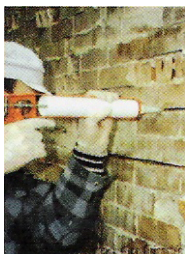
Εικόνα [61] Εισαγωγή ενέματος
