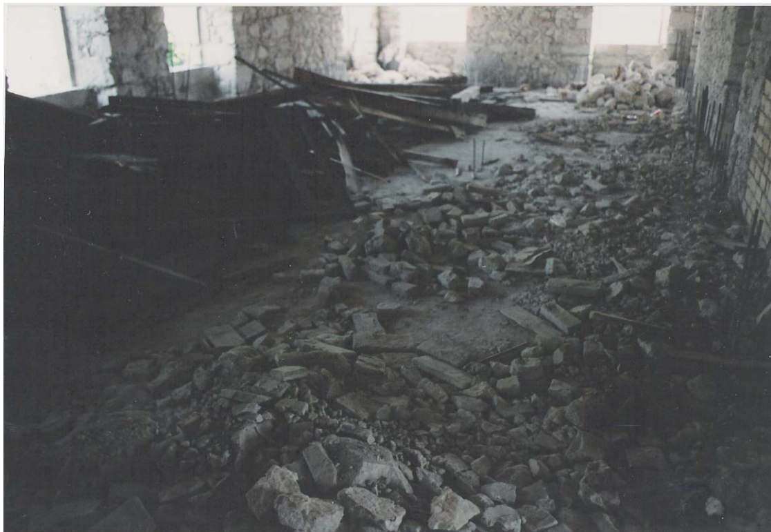
Εικόνα [39] Εσωτερική κατάσταση πριν την επέμβαση το 1989 .
