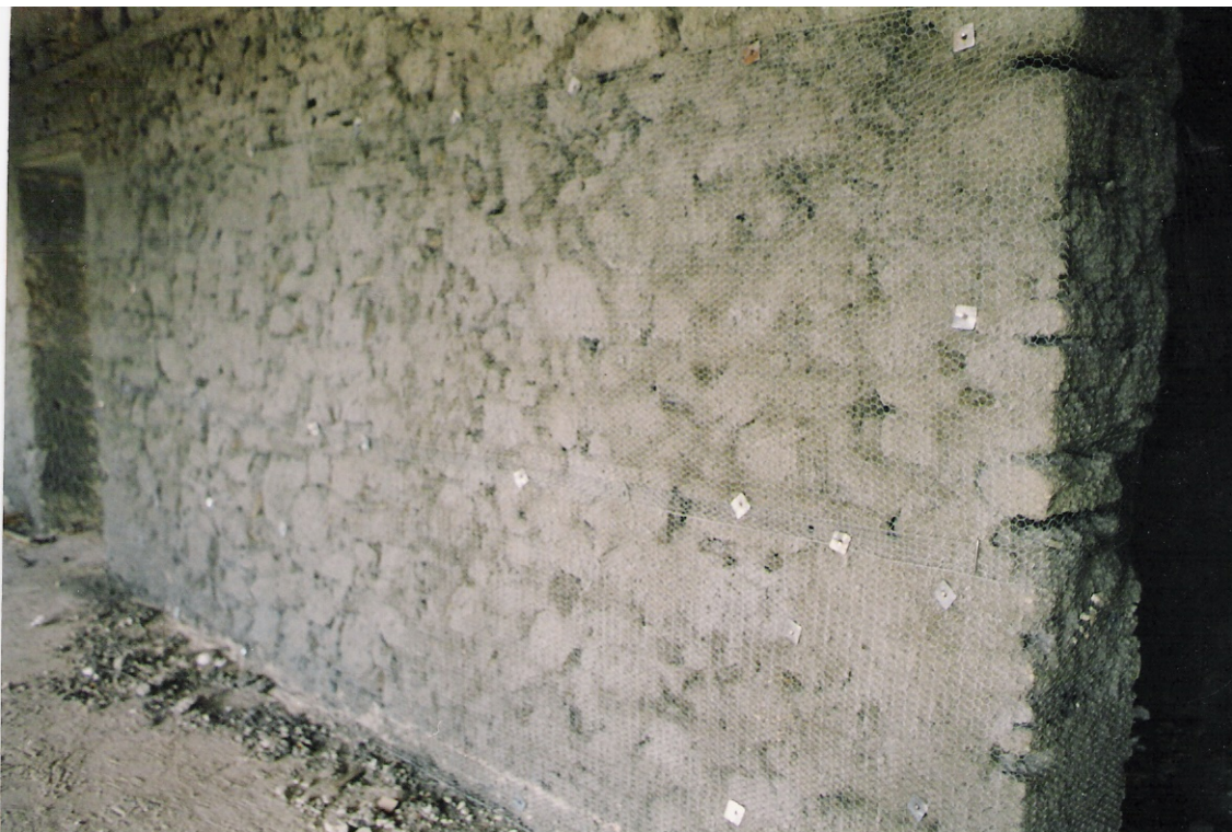
Εικόνα [43] Κοτετσόσυρμα ενίσχυσης εσωτερικών παρειών .
