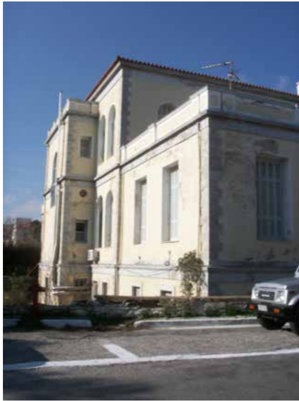
Εικ. 73 Πίσω όψη του κτιρίου.
