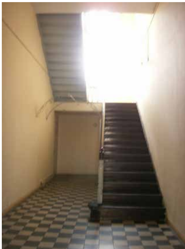
Εικ. 92 Σκάλα που οδηγεί στον όροφο.
