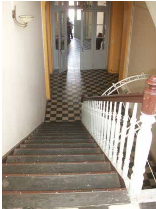
Εικ. 93 Ξύλινη σκάλα με κουπαστή.
