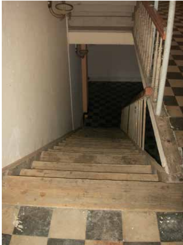
Εικ. 91 Σκάλα που οδηγεί στο ημιυπόγειο.
