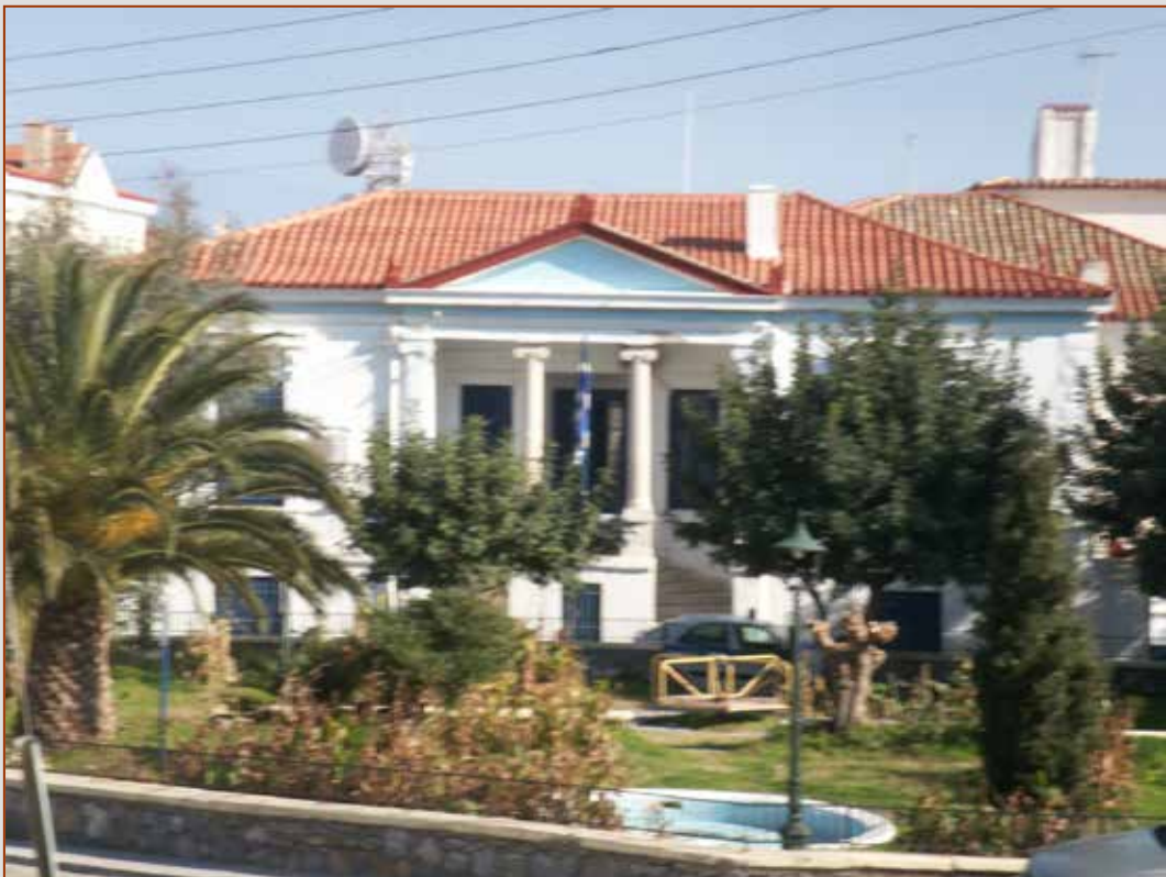
Εικ. 7 Κτίριο αστυνομικού τμήματος.
