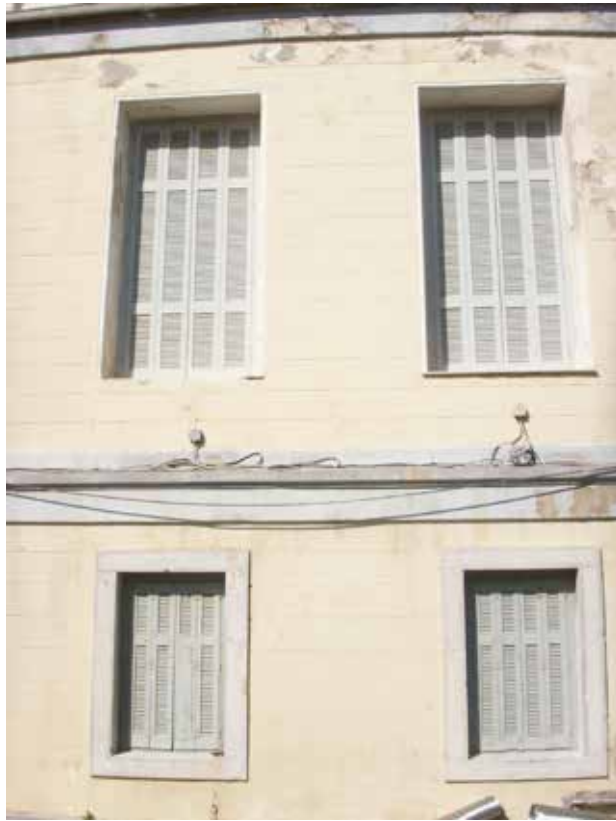
Εικ. 77 Παράθυρα ισογείου και ημιυπόγειου στην πίσω όψη του κτιρίου.
