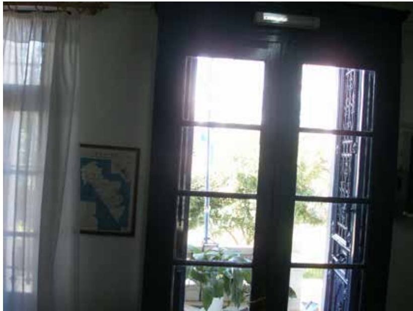
Εικ. 56 Κεντρική είσοδος κτιρίου.
