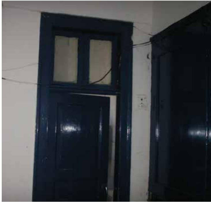
Εικ. 65 W.C που χρησιμοποιείται από τους εργαζόμενους του αστυνομικού τμήματος.
