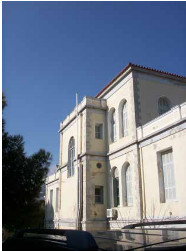
Εικ. 75 Πίσω όψη του κτιρίου.
