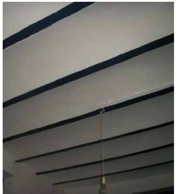
Εικ. 67 Οροφή ημιυπογείου.
