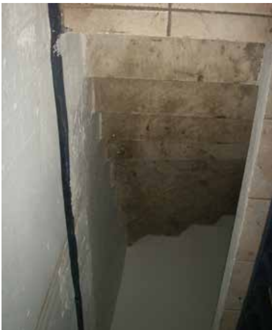
Εικ. 66 Σκάλα που οδηγεί στο ημιυπόγειο.
