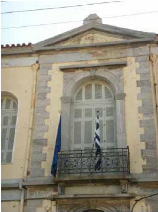
Εικ. 70 Μπαλκονόπορτα ορόφου
