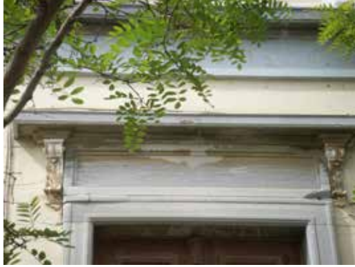
Εικ. 36 και 37 Φθορές στην ανατολική όψη.
