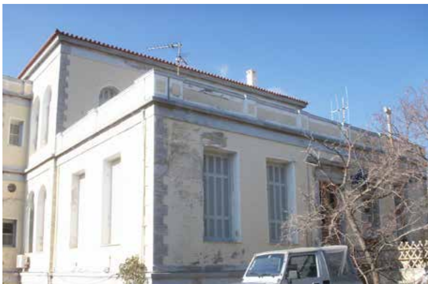
Εικ. 79 Ανατολική όψη του κτιρίου.
