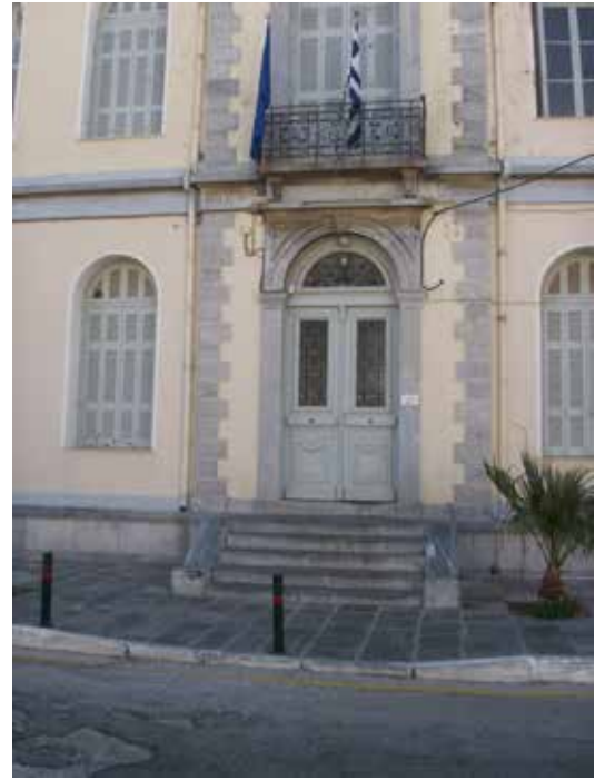
Εικ. 71 Κύρια θύρα που οδηγεί στο ισόγειο.
