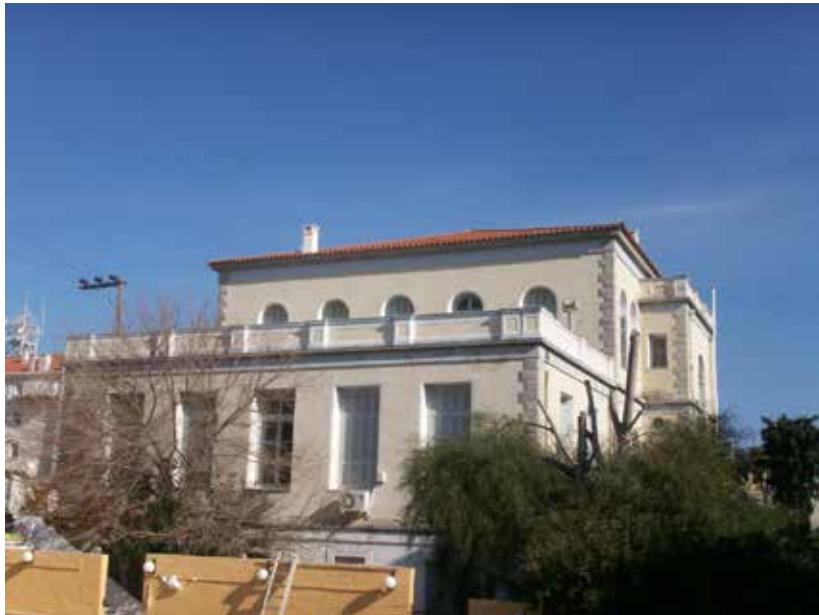
Εικ. 84 Δυτική όψη του κτιρίου.
