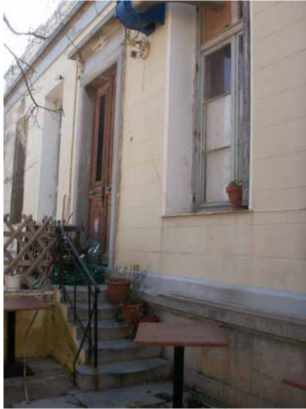
Εικ. 83 Σκάλα που οδηγεί στην μπαλκονόπορτα ισογείου ανατολικής όψης.
