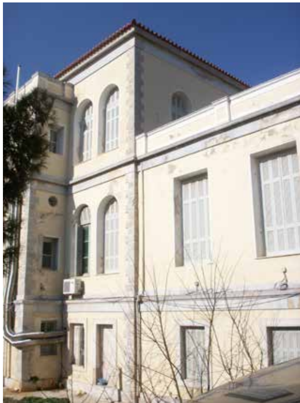
Εικ. 74 Πίσω όψη του κτιρίου.
