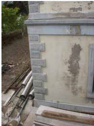
Εικ. 34 και 35 Φθορές στην ανατολική όψη.
