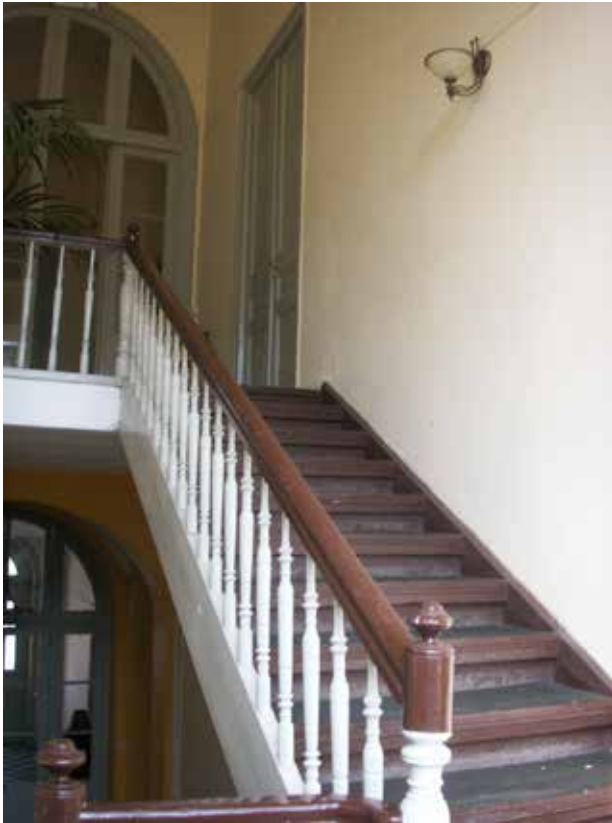
Εικ. 95, 96 Ξύλινη σκάλα με κουπαστή
