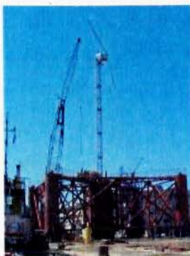
Εικόνα 5.10 Βοηθητικός γερανός Ανύψωση ατράκτου
