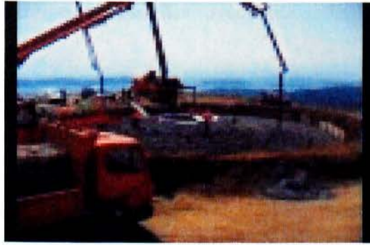
Εικόνα 5.3: Τοποθέτηση σκυροδέματος
