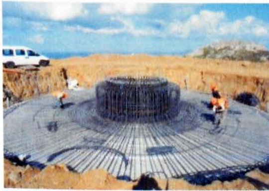
Εικόνα 5.2:Κατασκευή θεμελίων
