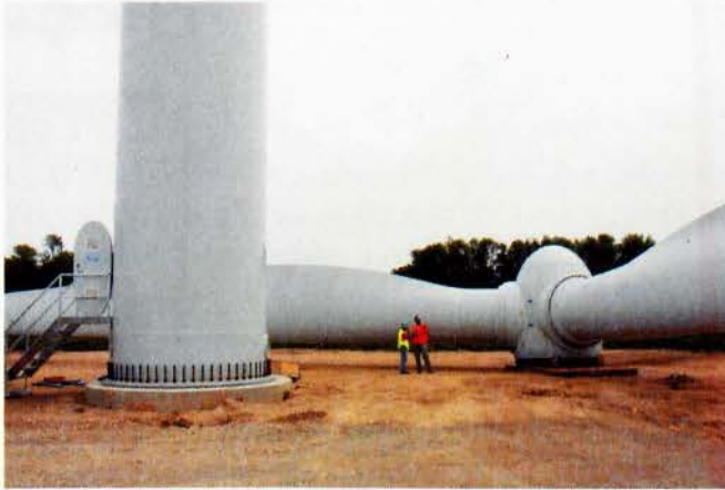
Εικόνα 5.5: Τοποθέτηση κεντρικής βάσης
