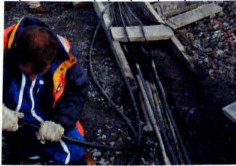
Εικόνα 5.4: Διάνοιξη τάφρων διέλευσης καλωδίων.
