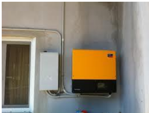
Σχήμα 2.12. Inverter (Μετατροπέας) σε οικιακό φωτοβολταϊκό σύστημα
