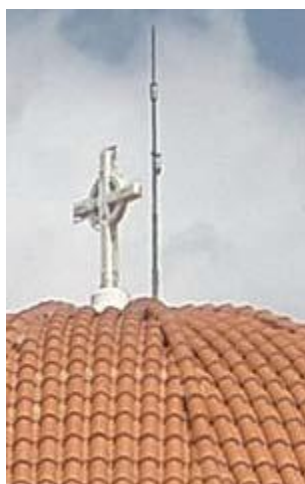
Εικόνα 6.1: Αλεξικέραυνο ραδιενεργού τύπου
