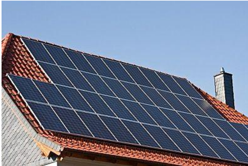
Σχήμα 2.11. Τοποθέτηση φωτοβολταϊκών πλαισίων σε σκεπή
