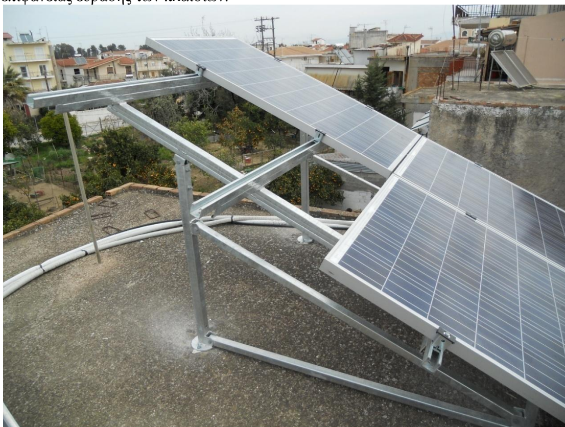
Σχήμα 2.10. Τοποθέτηση φωτοβολταϊκών πλαισίων σε μεταλλική κατασκευή
