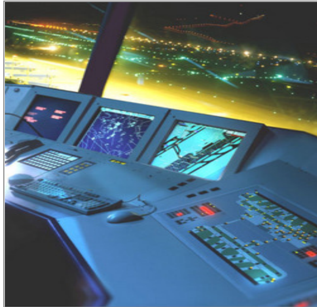
(Σύστημα ελέγχου φωτισήμανσης σε πύργο ελέγχου)
