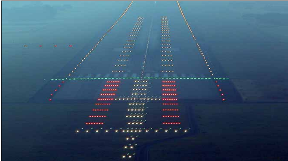
(Διάδρομος με ολοκληρωμένο σύστημα ακριβούς προσέγγισης II, III)
