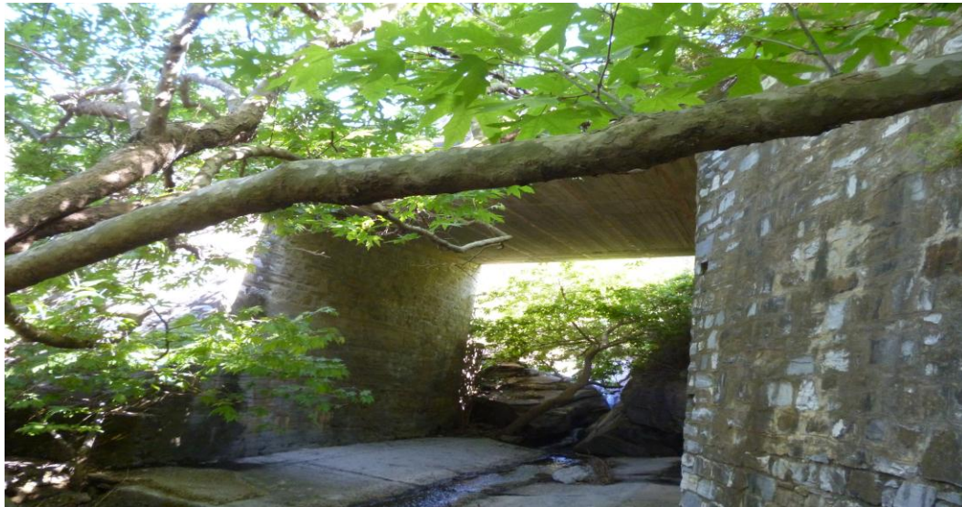
Εικ.18 Γεφύρι στο Μυλιώντα
