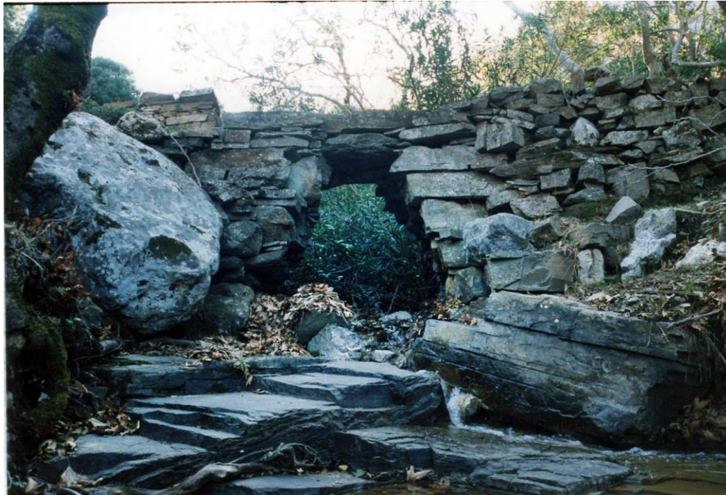
Εικ.24 Γεφύρι στην Πλατανοπή
