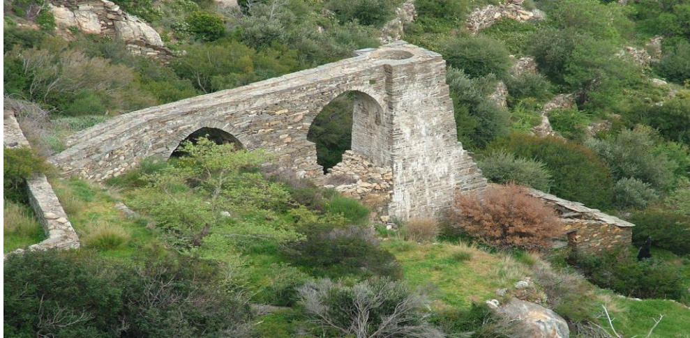
Εικ.23 Υδατογέφυρα του Ξυλοσύρτη
