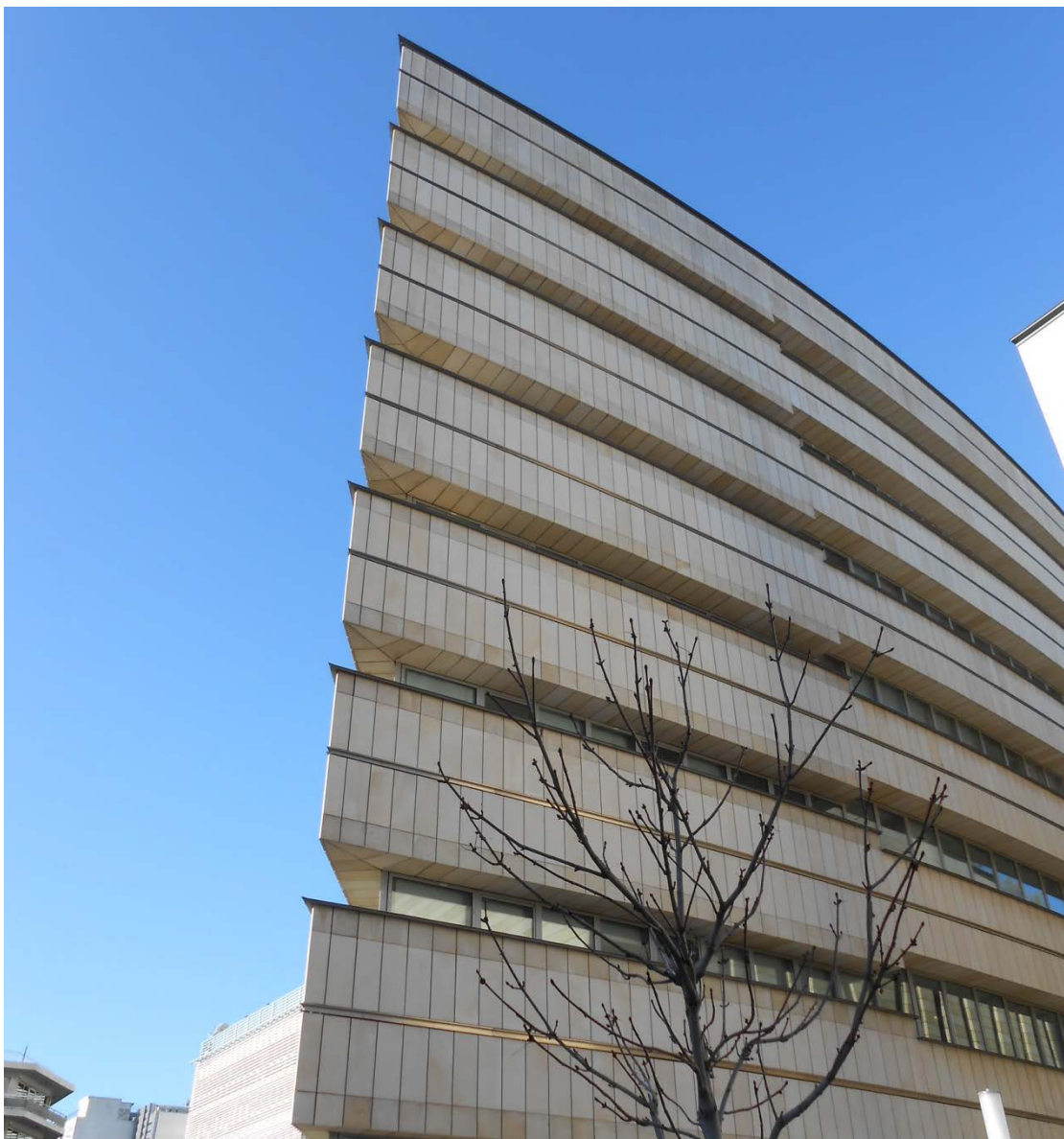
Εικόνα 71 Ταυτότητα του κτιρίου αποτελούν τα δύο συμμετρικά τόξα που σχηματίζονται
