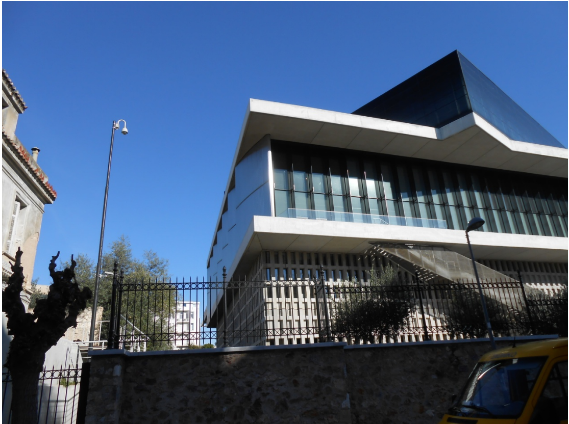
Εικόνα 52 Η βορειοανατολική πλευρά του κτιρίου
