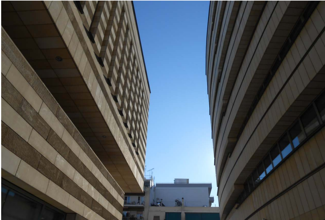
Εικόνα 72 Η μικρή απόσταση των δύο κτιρίων δημιουργούν την αίσθηση του κλειστού χώρου, το οποίο ενισχύεται λόγω των ίδιων υφών και χρωμάτων
