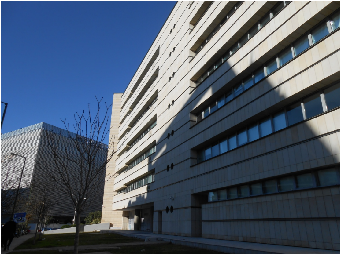
Εικόνα 74 Η πίσω πλευρά του κτιρίου, χαρακτηρίζεται απο συμμετρία
