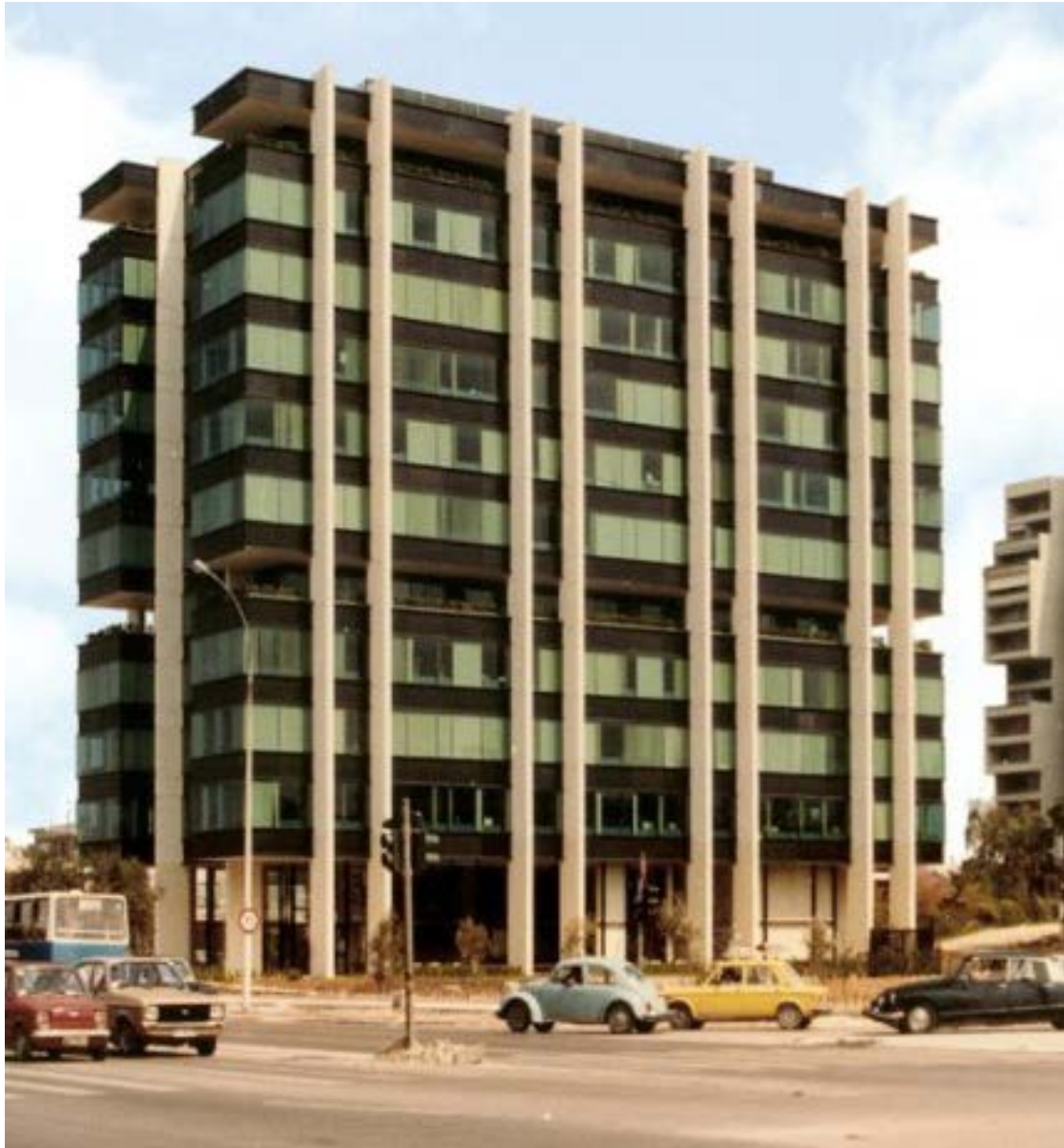
Εικόνα 32 Πράσινο κτίριο της Κηφισίας (1970)
