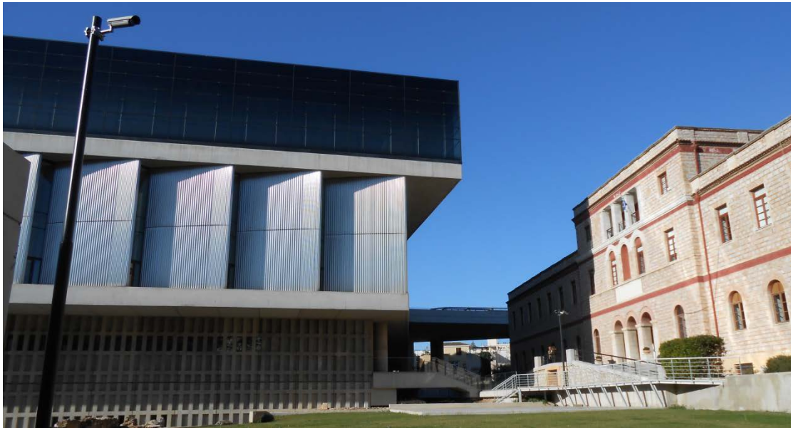
Εικόνα 42 Η δυτική πλευρά του κτιρίου
