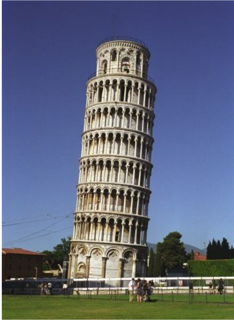
Εικ. 5 Πύργος της Πίζας [23]
