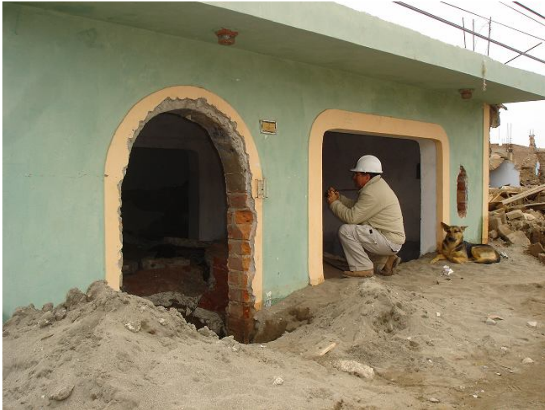
Εικ. 6 Καθιζήσεις λόγω ρευστοποίησης εδάφους από σεισμό στο Περού [12]
