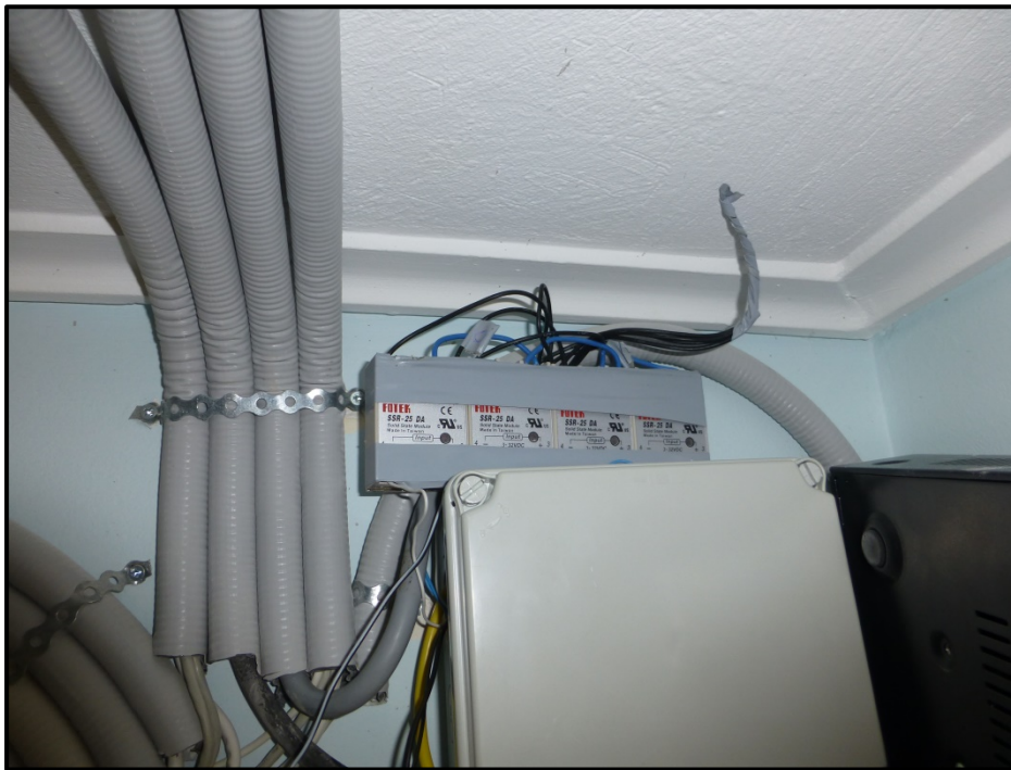
Εικόνα 54. Η τελική εγκατάσταση με τα Solid State Relay
