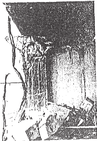
Πλήρης ἀστοχία τῶν βραχέων περιμετρικῶν υποστυλωμάτων Ἐργοστάσιο ΚΕΡΑΦΙΝΑ. Σεισμός Ἀλκυονίδων 1981. Ἴσομια
