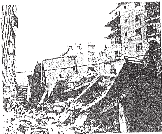
Όψη καταρρεύσεως από ΝΑ Κατασκευή 1957-1959, Β 120x160/Στ Ι, ΑΕΠΚ. Κακή μορφολογία. Έλλειψη έλαρκοῦς και κατάλληλου όπλισμοῦ κόμβων κατάρρευση 1x2μήν μετά τό τέλος τοῦ σεισμοῦ. 36 νεκροῦ
