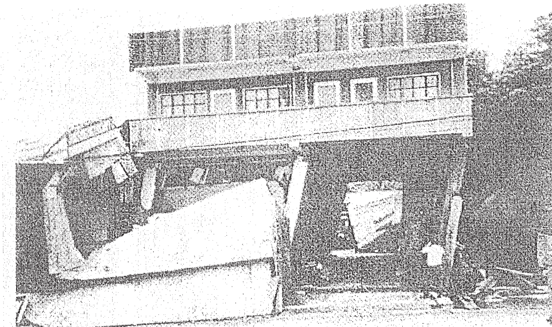
Σχήμα 1.1. Μηχανισμός μαλακού ορόφου , σεισμός Φιλιππίνων 1990.
