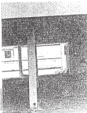
(3) Pilotis. Βλάβες στο έσόγειο. Μόνιμη κλίση υποστυλοματών έσογείου. Σεισμός 'Αλκυονίδων 1981. Λουτράκι
