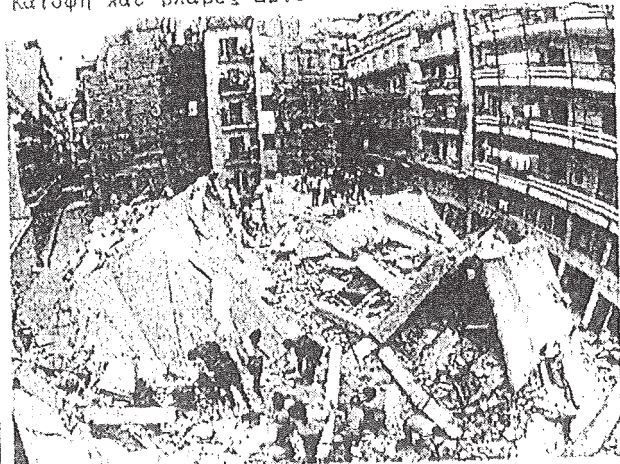
Όψη καταρρεύσεως από ΒΑ Πλήρης
