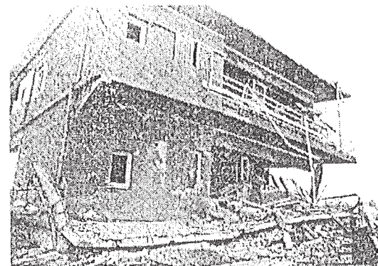
(γ) 3/όροφη!! κατοικία στο Κιάτο. Θεμελίωση σε ιλυώδες έδαφος με ύψηλό φρεάτιο όρίζοντα. Πλήρης κατάρρευση ίσογειού
