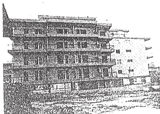
(3) Pilotis. Βλάβες στο έσόγειο. Μόνιμη κλίση υποστυλοματών έσογείου. Σεισμός 'Αλκυονίδων 1981. Λουτράκι
