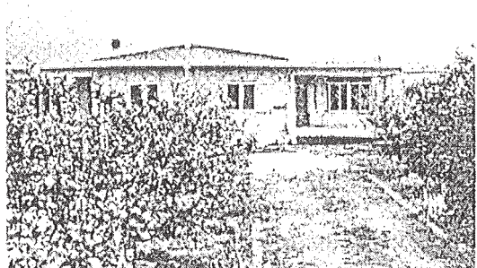
(β) 2/όροφο!!! κατοικίες στον Χγένο. Θεμελίωση σε αμιβάλες έδαφος με ύψηλό φρεάτιο όρίζοντα. Πλήρης κατάρρευση ίσογειού.
