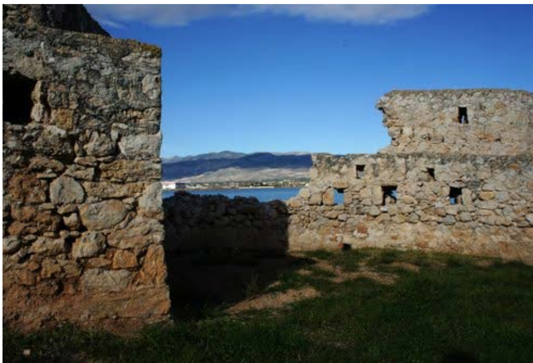
Εικόνα 69 Ημιλαξευτή λιθοδομή συνθέτει το κύριο κορμό του τείχους
