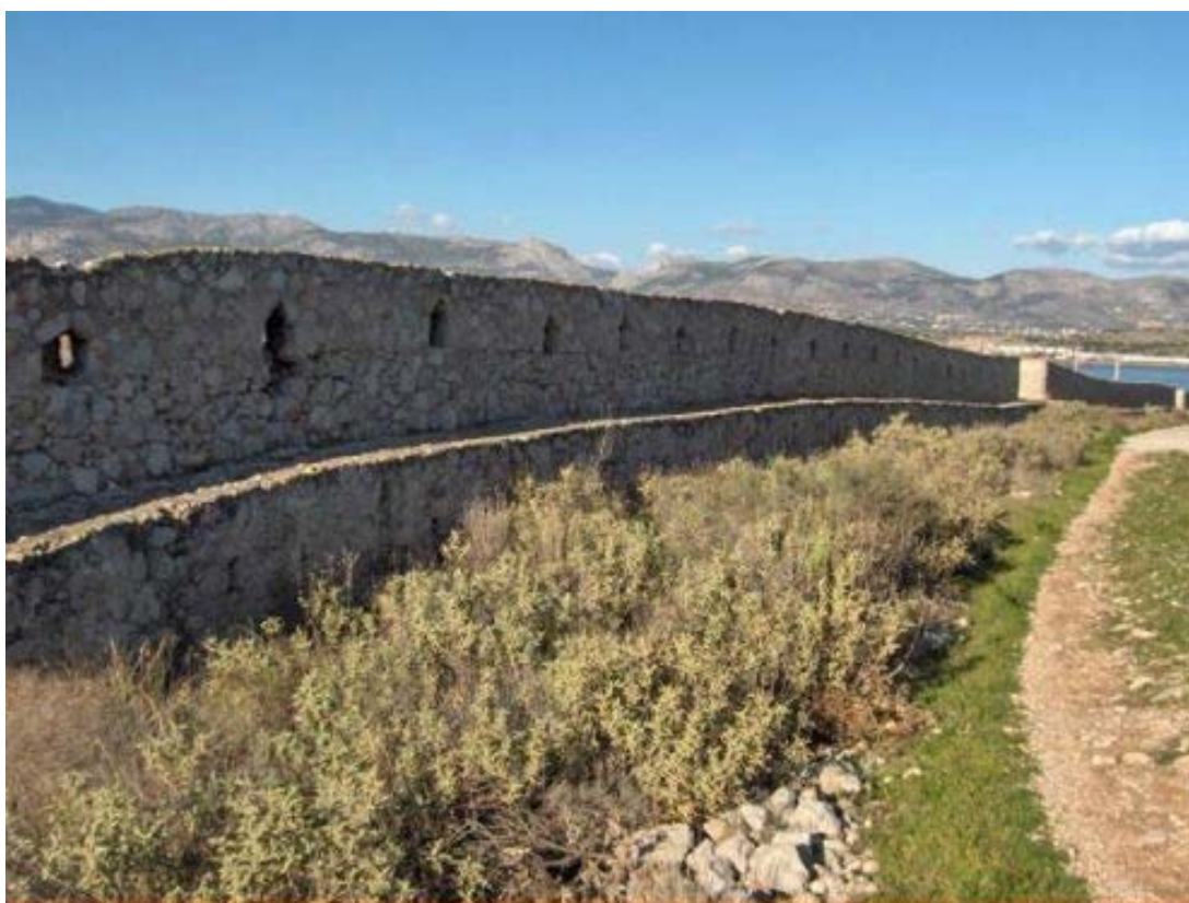
Εικόνα 70 Περιμετρικά του τείχους υπάρχει πυκνή βλάστηση η οποία θα πρέπει να απομακρυνθεί
