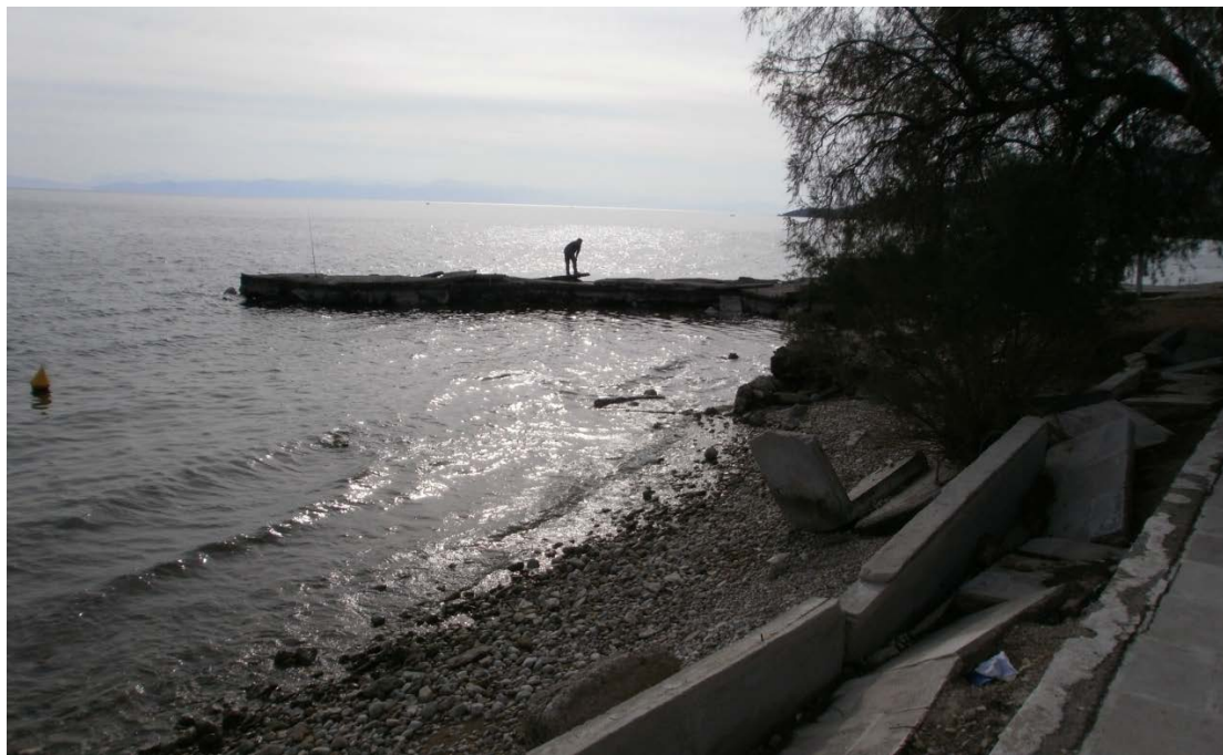
Εικόνα 80 Η περιοχή έχει κριθεί ακατάλληλη για κολύμπι
