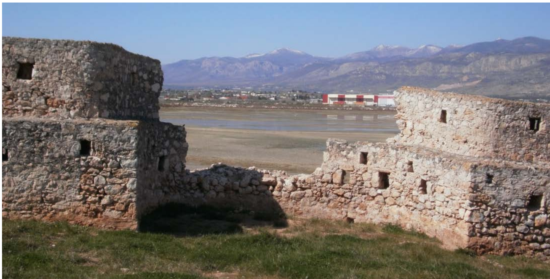
Εικόνα 39 Η ανέγερση βιοτεχνικών και βιομηχανικών μονάδων στην περιοχή του υγροτόπου που έχει οπτική επαφή με το Τείχος αλλοιώνει το Πολιτιστικό περιβάλλον της περιοχής.
