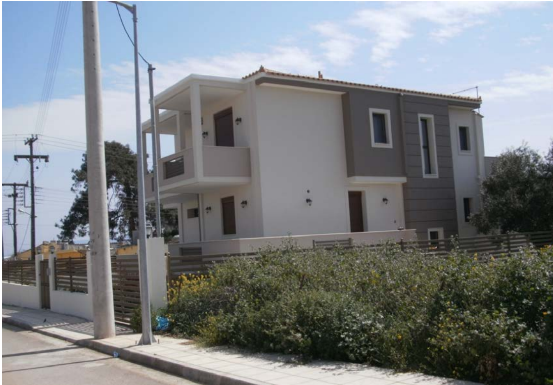
Εικόνα 45 Μέχρις στιγμής θεωρείται αραιοκατοικημένη περιοχή. Όπως φαίνεται και στις εικόνες συνεχίζεται να οικοδομούνται κατοικίες.
