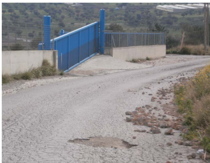
Εικόνα 31 Κακοτεχνία στο οδικό δίκτυο οι οποίες έχουν δημιουργηθεί από το σπάσιμο της ασφάλτου
