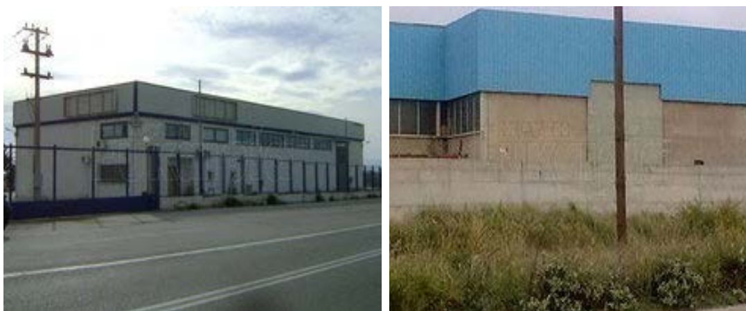
Εικόνα 29 Υπάρχουν και βιομηχανικά κτήρια κατασκευασμένα από οπλισμένο σκυρόδεμα, μικρότερα σε όγκο και παλαιότερα χρονολογικά από τα μεταλλικά κτήρια
