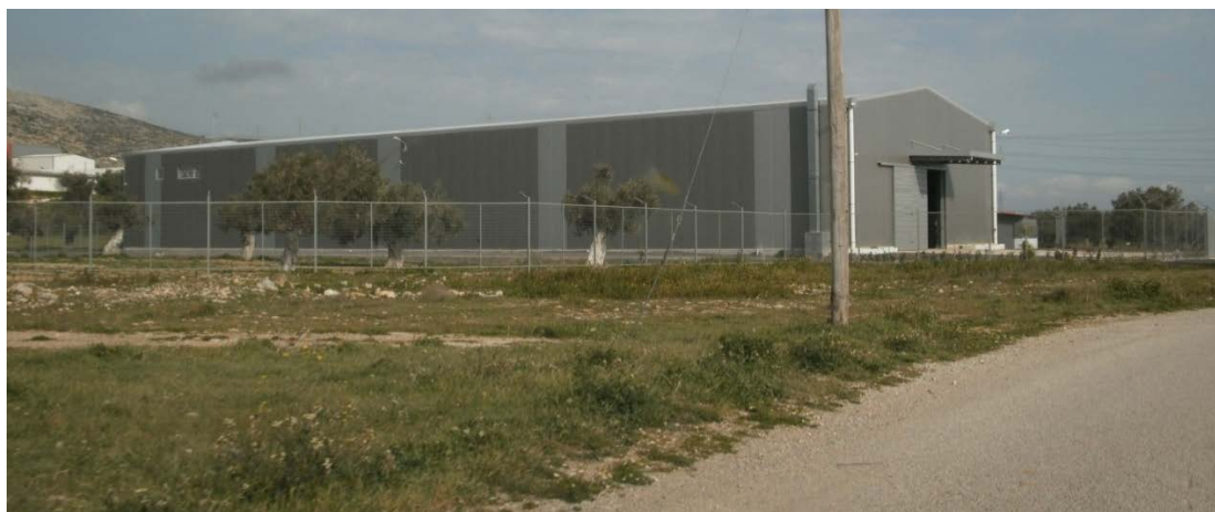
Εικόνα 28 Τα περισσότερα βιομηχανικά κτήρια είναι κατασκευασμένα από μεταλλικό σκελετό
