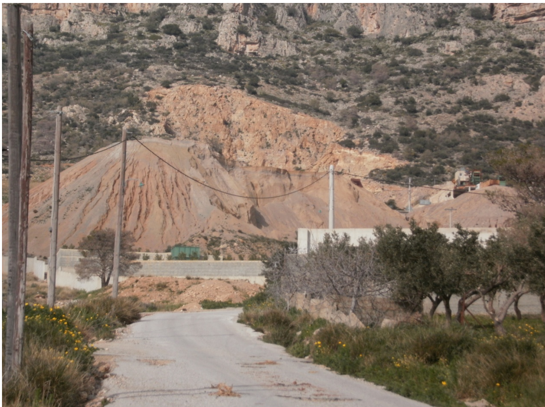
Εικόνα 97 Το οδικό δίκτυο της περιοχής έχει κακοτεχνίες, έλλειψη συντήρησης και δεν υπάρχει πρόβλεψη φωτισμού του δρόμου
