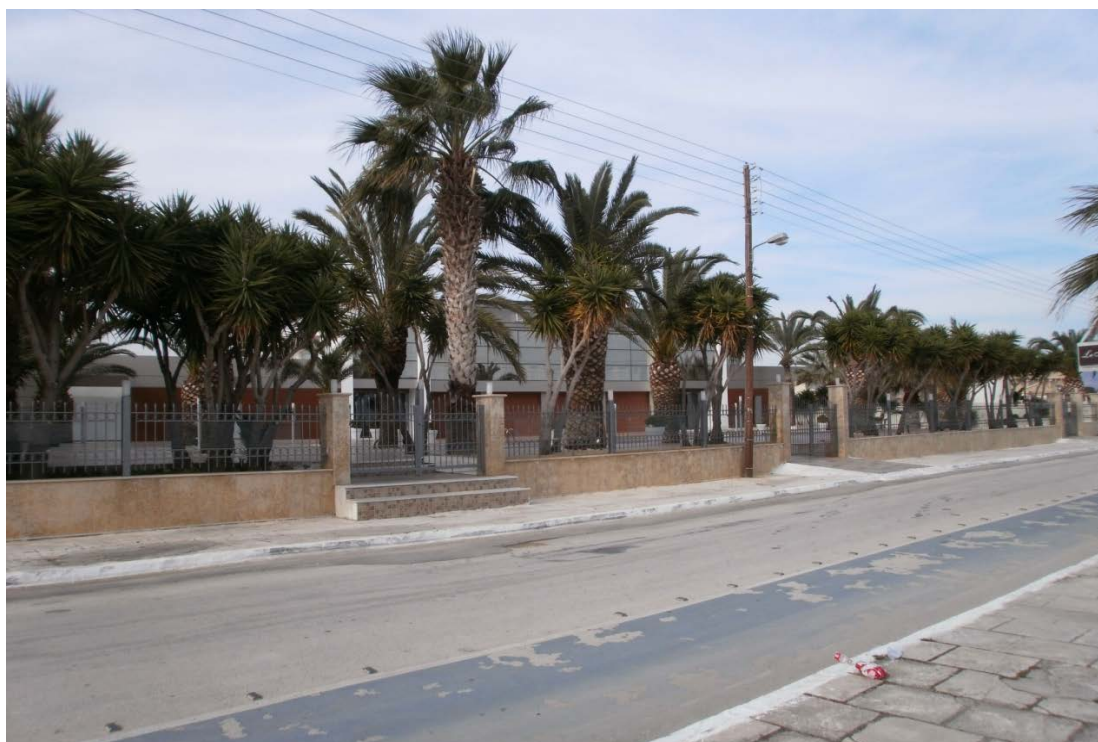
Εικόνα 74 Στα πλαίσια ανάπτυξης της παραλιακής ζώνης ένα από τα έργα που υλοποιήθηκε ήταν η κατασκευή ποδηλατοδρόμου σε όλο το μήκος της
