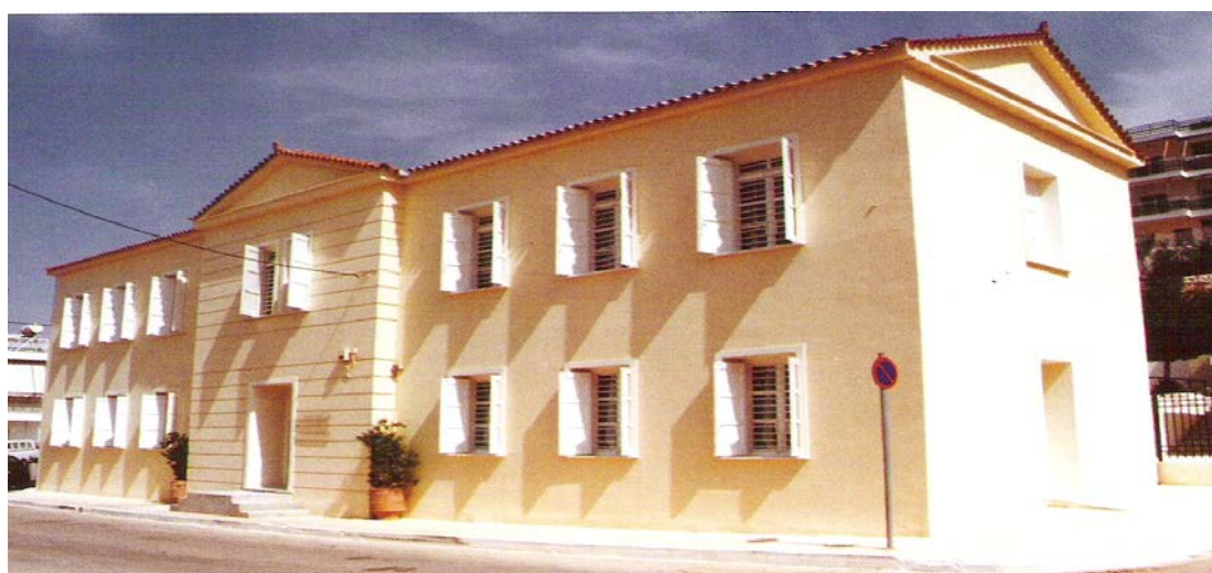
Εικόνα 117 Το νεοκλασικό κτίριο του παλαιού Δημαρχείου κατασκευής 1873 στο οποίο στεγάζεται σήμερα το αρχαιολογικό μουσείο Μεγάρων. (Πηγή: Τα Μέγαρα της Αρχαιότητας).
