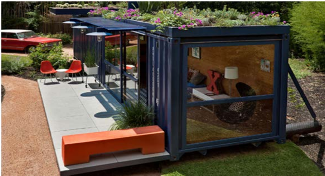
Εικόνα 6 Κατασκευαστικά είναι διακριτό ότι το container δεν έχει θεμελιωθεί στο έδαφος.
