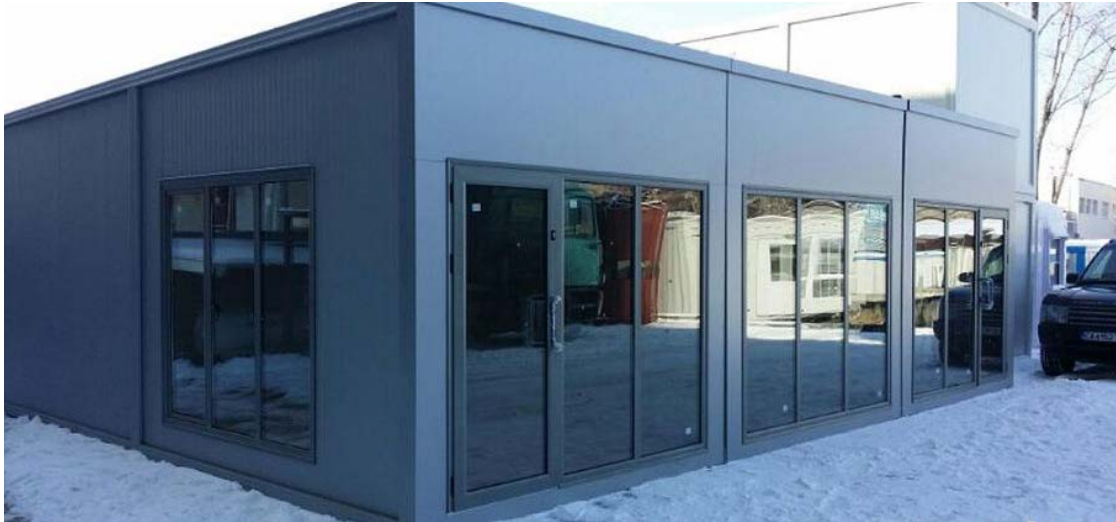
Εικόνα 5 Κοντέινερ τοποθετημένο πάνω σε πλάκα καθαριότητας
