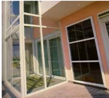
136 Θερμοκήπιο προσαρτημένο σε κτίριο.
