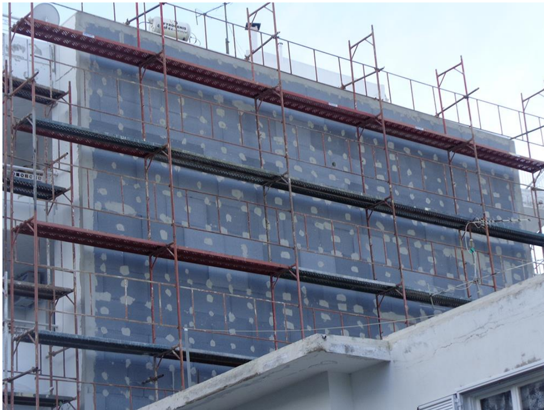
Τοποθέτηση εξωτερικής θερμομόνωσης σε κτίριο. 162
