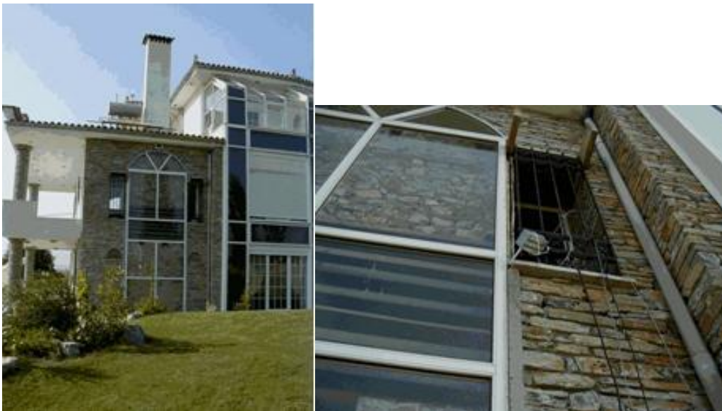
Κατοικία στη Λάρισα με ηλιακούς τοίχους Trombe και θερμοσιφωνικά πάνελα. 125
