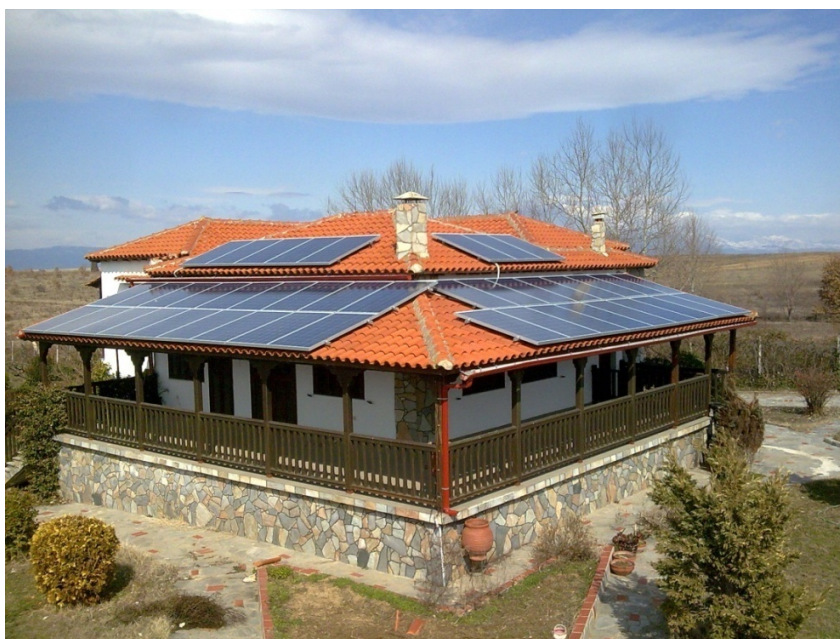
Σχήμα 3.3. Εγκατάσταση φωτοβολταϊκού συστήματος σε στέγη οικίας
