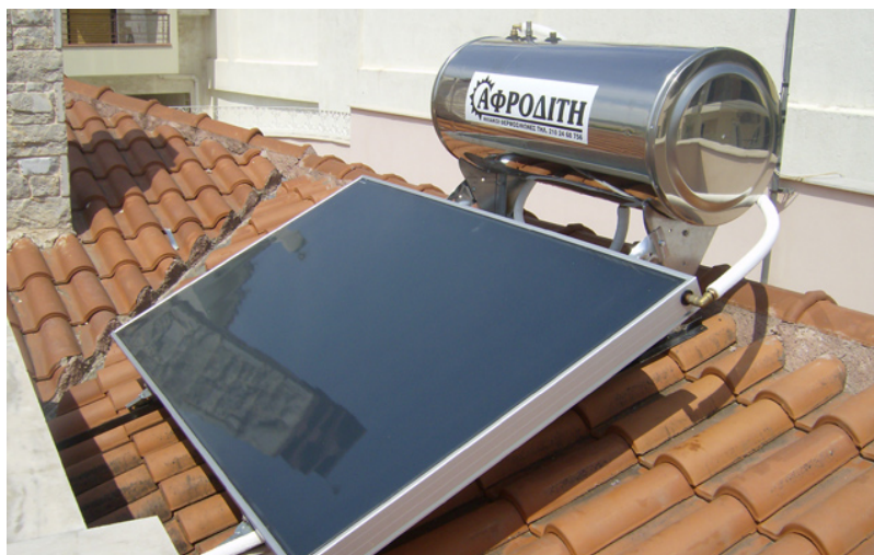
Σχήμα 3.5. Ηλιακός θερμοσίφοντας
