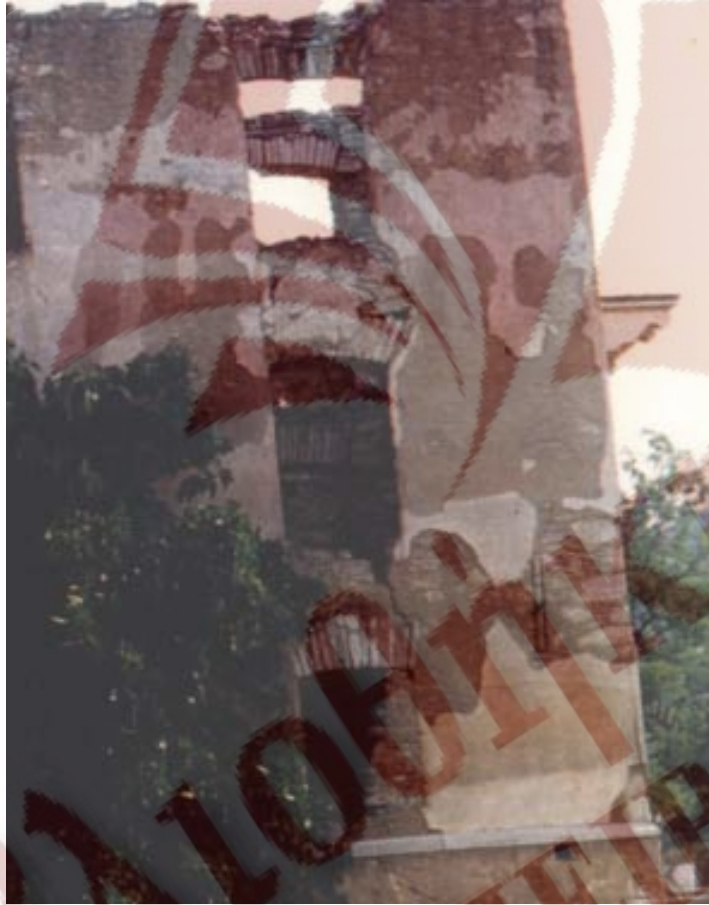
εικόνα 3: Παράθυρα με εμφανή προβλήματα στατικότητας στις καμάρες στην δυτική όψη
