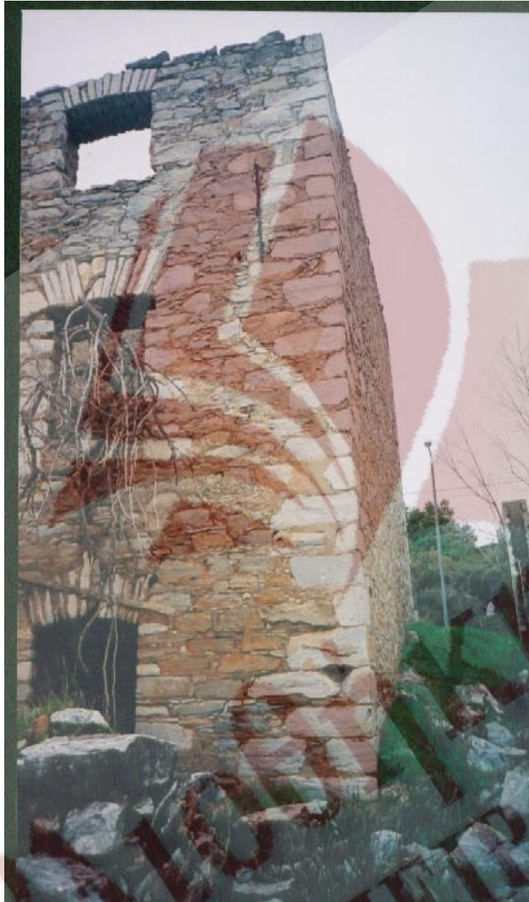
εικόνες 15,16 : Ακρογωνιαίοι λίθοι και σφηνώματα
