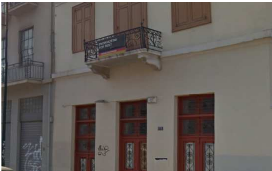
Εικόνα 68 Μαρμάρινο ορθογώνιο μπαλκόνι με ξύλινη μπαλκονόπορτα που παρέχει στους κατοίκους τη δυνατότητα πρόσβασης σε αυτό
