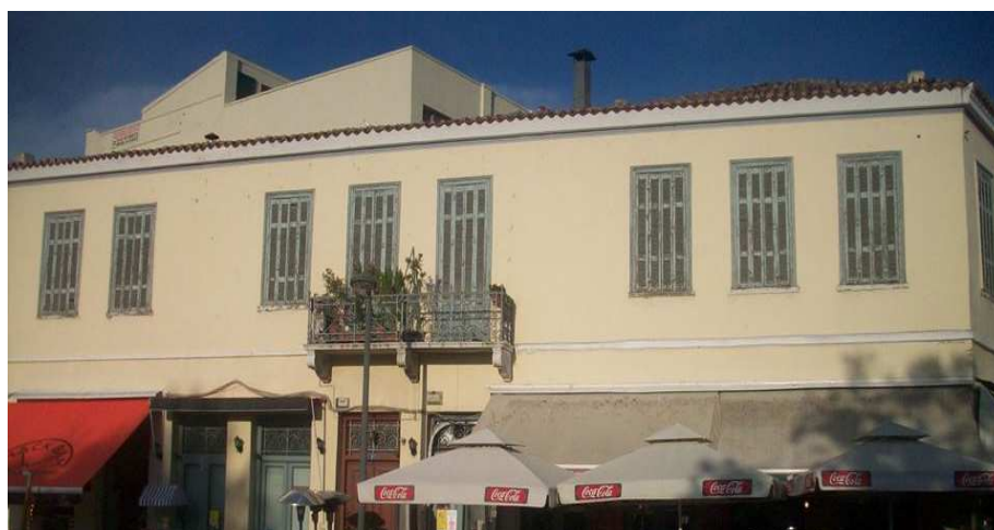
Εικόνα 35 Το κτίριο στη συμβολή των οδών Αγίων Ασωμάτων & Αδριανού
