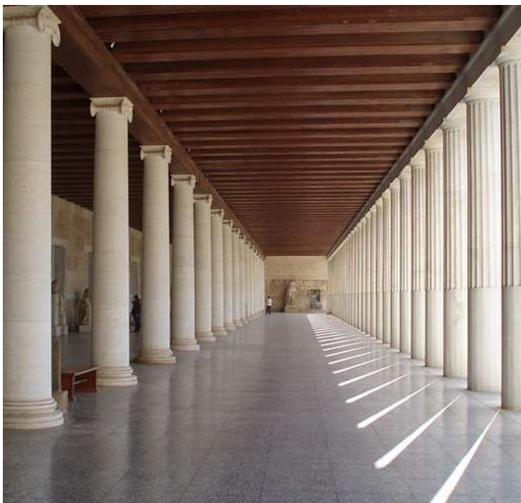
Εικόνα 30 Εσωτερικά της στοάς προς το νότο
