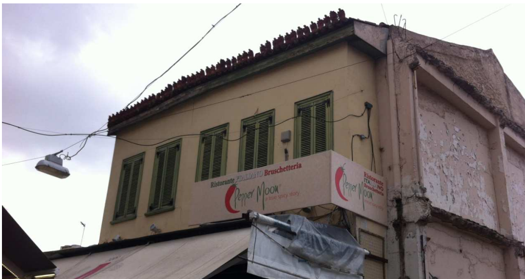
Εικόνα 72 Δίρρυχη στέγη
