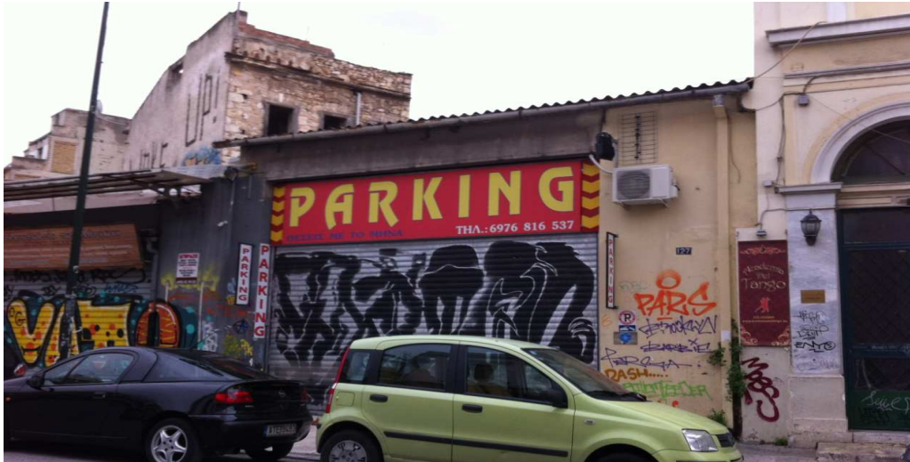
Εικόνα 51 Ισόγειο κτίσμα, που λειτουργεί ως χώρος στάθμευσης
