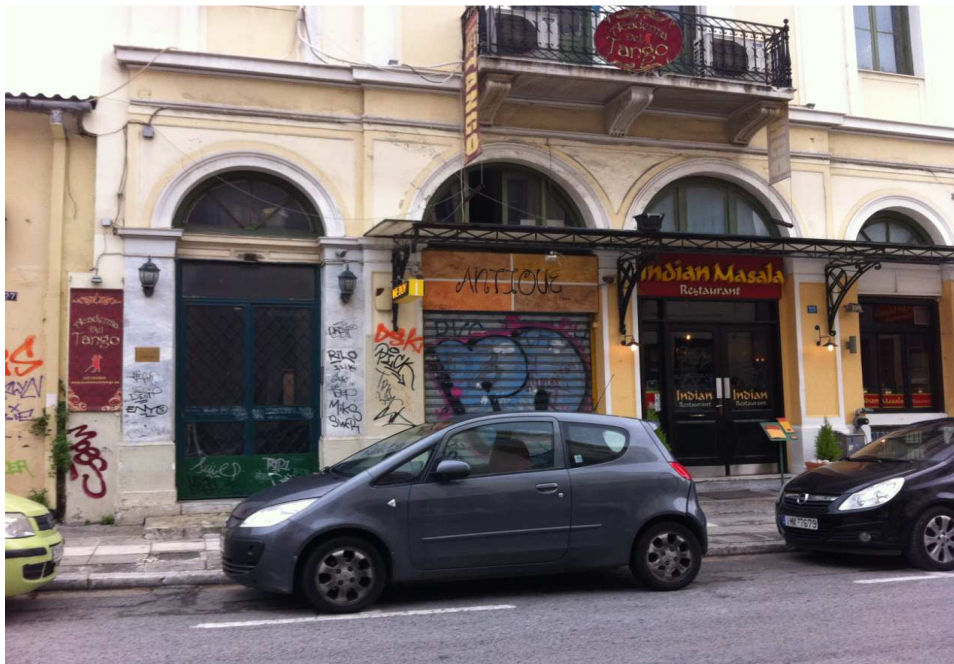
Εικόνα 56 Τα εξωτερικά κουφώματα του κτιρίου είναι ανοιγοανακλινόμενα, από διατομές αλουμινίου, κατασκευασμένα σύμφωνα με τις σύγχρονες τεχνικές προδιαγραφές
