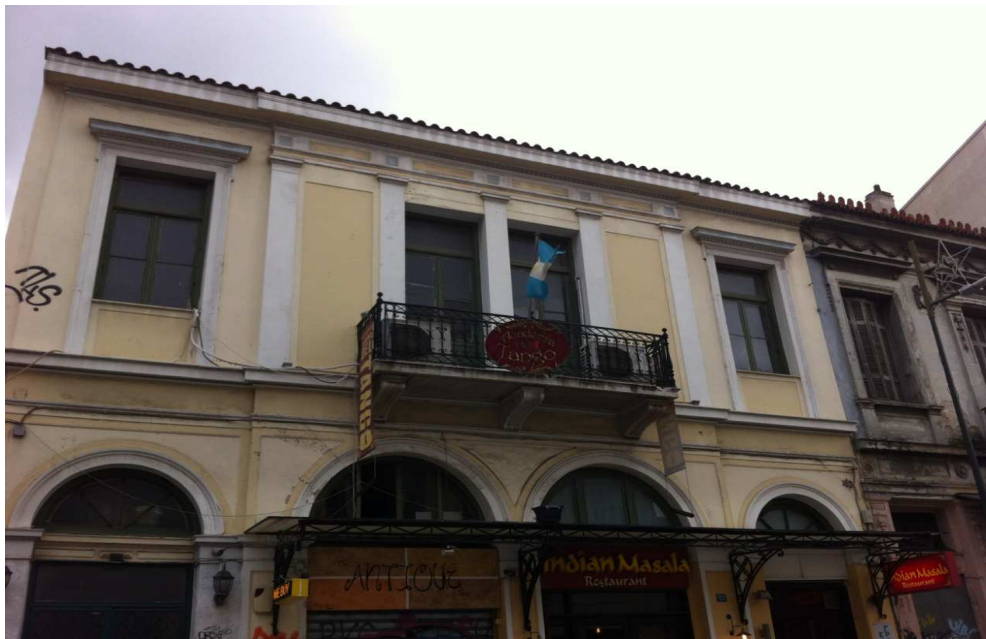
Εικόνα 61 Το κτίριο διαθέτει ένα στενό μπαλκόνι που έχει τη μορφή προβόλου. Διαμορφώνεται ως επέκταση της πλάκας μεταξύ δύο διαδοχικών επιπέδων
