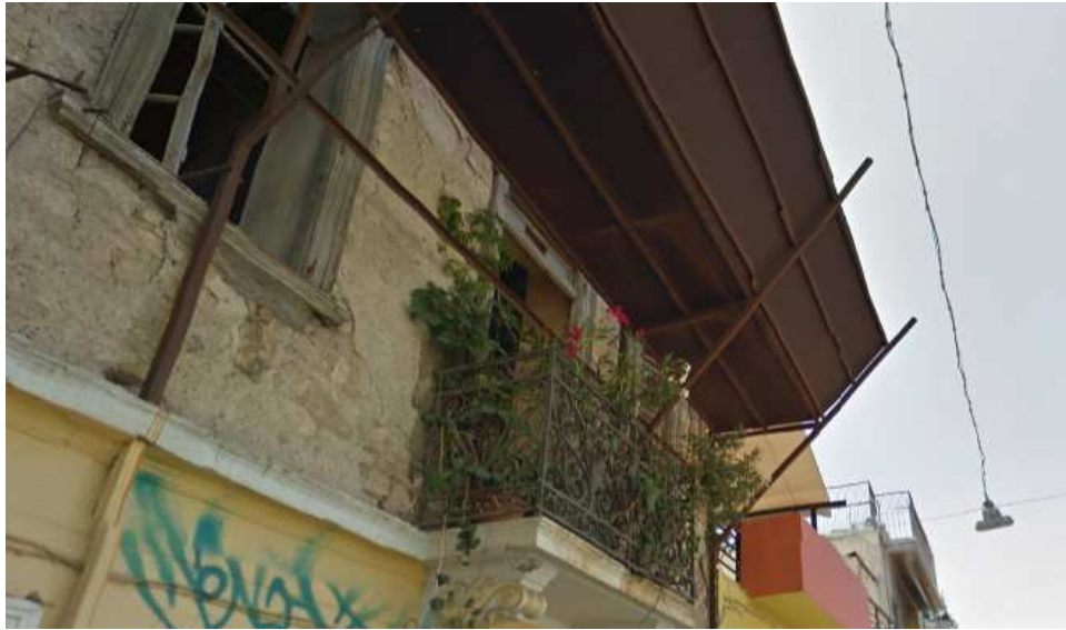
Εικόνα 67 Οι σιδεριές του μπαλκονιού είναι σφυρήλατες με απλά αλλά εξαιρετικής κατασκευής σχέδια
