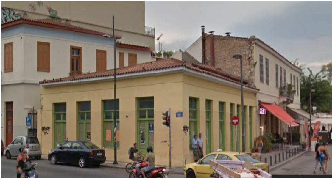
Εικόνα 71 Τετράριχη στέγη. Όταν η κατασκευή της στέγης είναι καλή και πληρούνται οι απαραίτητες προϋποθέσεις, τότε η στέγη λειτουργεί διαφραγματικά, συδέοντας τους τοίχους μεταξύ τους και προσδίδοντας ακαμψία στη συνολική κατασκευή
