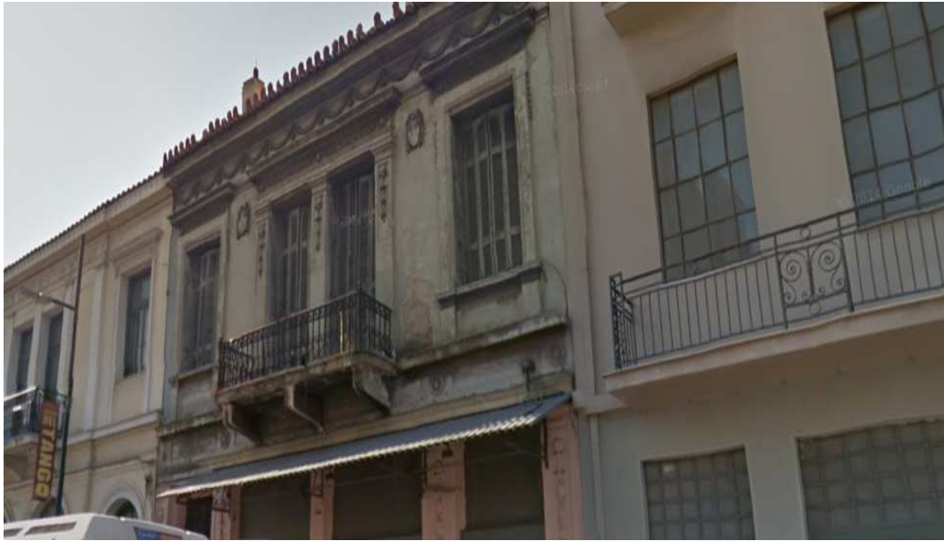
Εικόνα 59 Τα εξωτερικά δίφυλλα θυρόφυλλα χωρίς τζάμια χρησίμευαν για να προστατεύουν το εσωτερικό της κατοικίας απο τον αέρα και το κρύο τον χειμώνα
