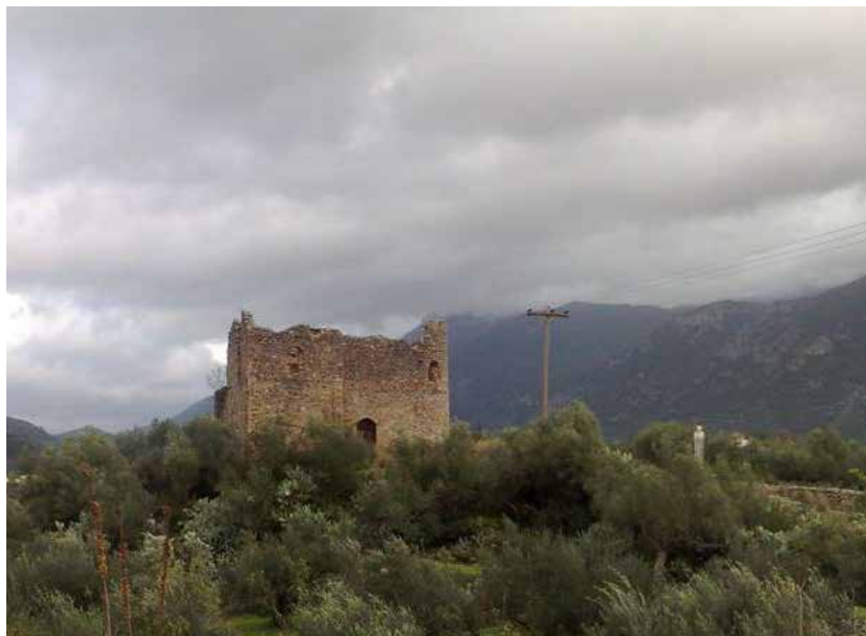
1. Νοτιοδυτική όψη του πύργου Κουμουνδούρου.
