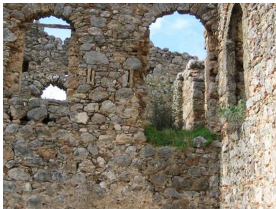
Ανοιγματα του Α' ορόφου.
