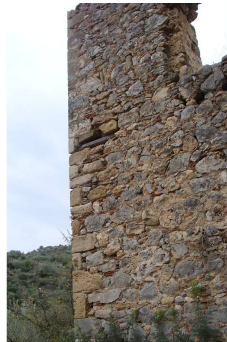
Εμφανή ξυλοδεσιά στον εξωτερικό Νοτιοανατολικό τοίχο του μικρού Νότιου χώρου.
