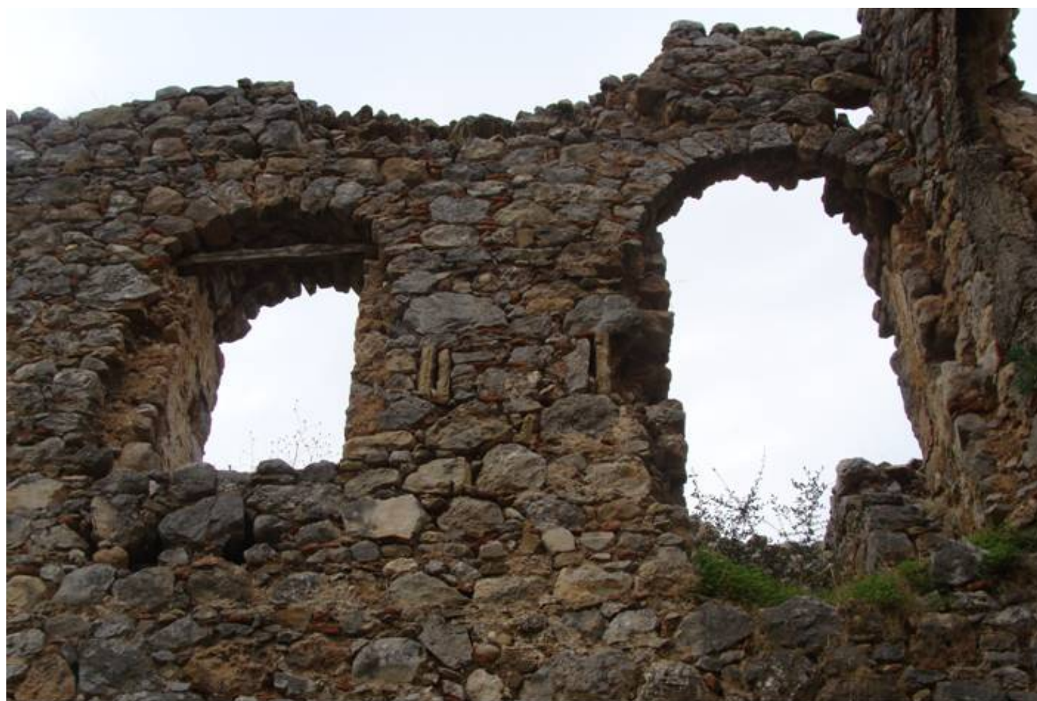
β.Ανοίγματα στον Α' όροφο, στα οποία φαίνονται οι πεσσοί (λαμπάδες) και οριζόντιο ξύλινο δοκάρι, το οποίο λειτουργούσε ως στήριγμα για το γέμισμα του «τυμπάνου» στο ανώφλι.
