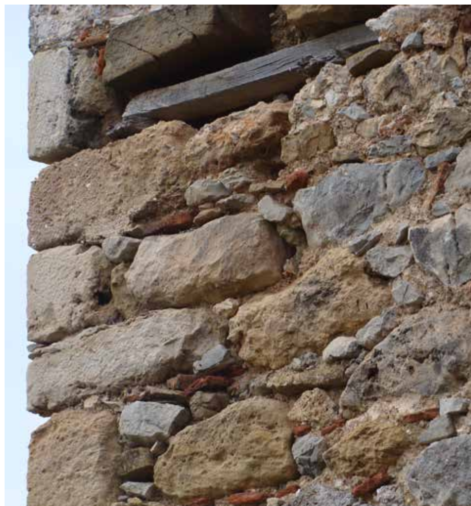
29. Ξυλοδεσιά που έχει αποκαλυφθεί στη νοτιοανατολική εξωτερική γωνία του μικρού νοτίου χώρου.
