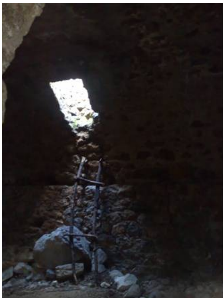
«Καταρράχτης» που εξυπηρετεί την επικοινωνία ισογείου και Α' ορόφου του πύργου.
