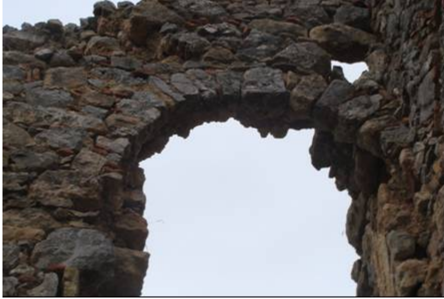
Λεπτομέρεια ανωφλιού ανοίγματος.
