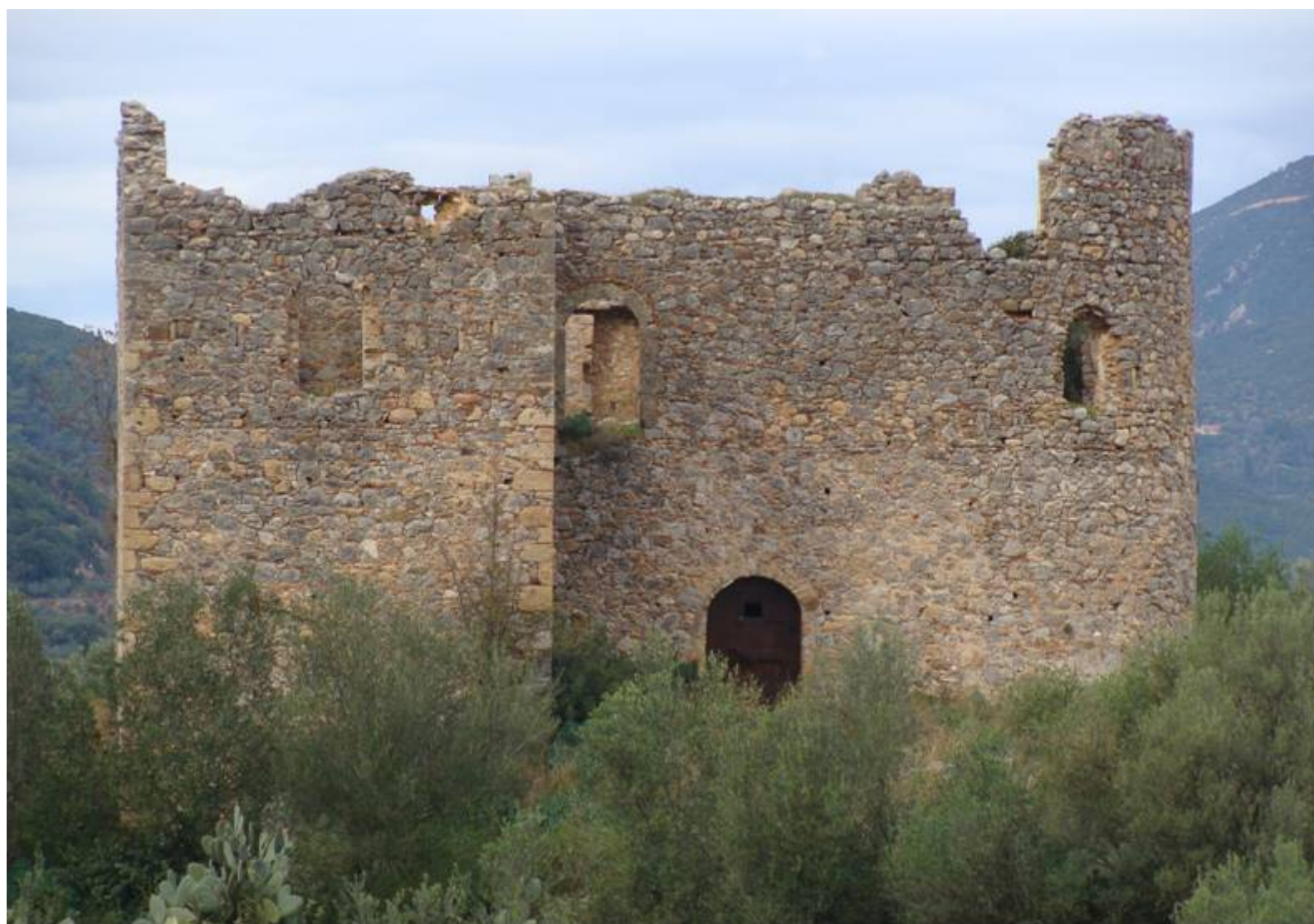
2.Πρόσοψη πύργου Κουμουνδούρου.(Νότια όψη)
