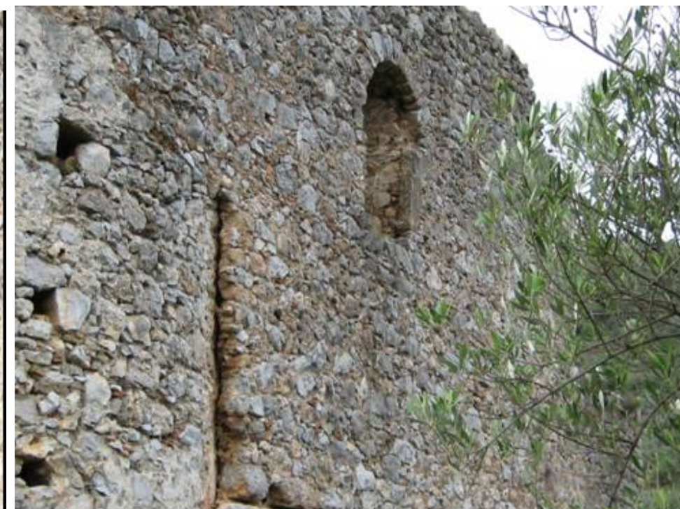
Άνοιγμα στη βόρεια όψη.
