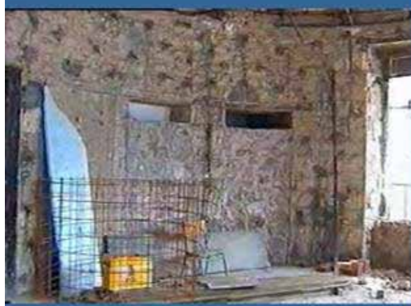
26. Παράδειγμα μεθόδου έγχυσης συνδετικού κονιάματος σε λιθοδομη.
