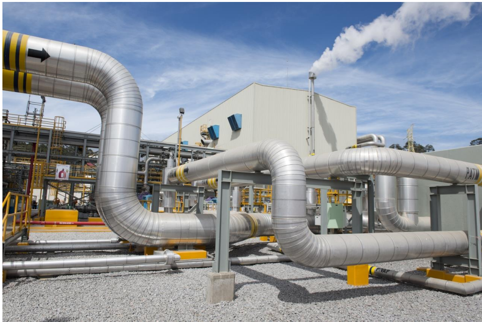
Εικόνα 3.4-3 : Σωληνώσεις Γεωτρήσεων
