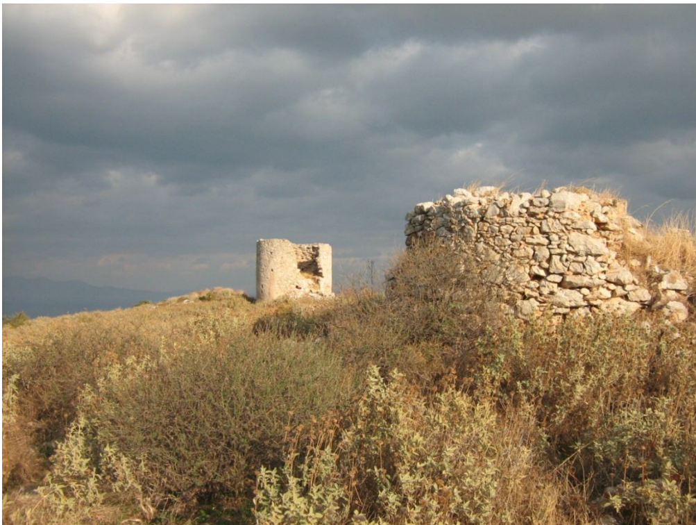
Εικόνα 77: Άποψη από την δεύτερη βίγλα από την Νότια πλευρά της, διακρίνουμε και την πρώτη βίγλα στο βάθος.
