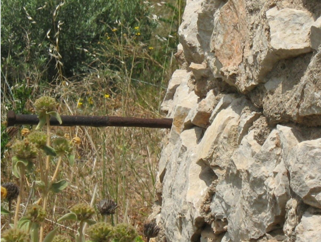
Εικόνα 13 : Λεπτομέρεια ( μεταλλικό στοιχείο) από το εξωτερικό της Βίγλας
