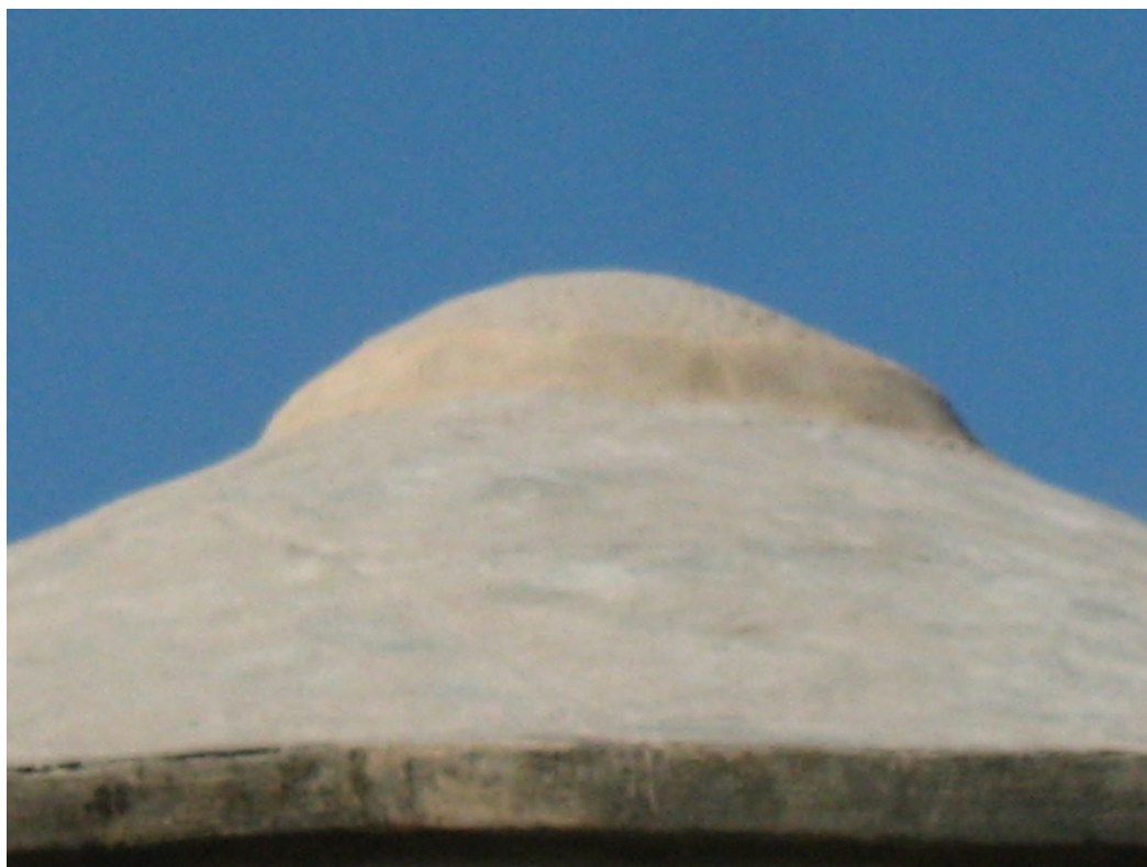
Εικόνα 35 : Η στέγη της βίγλας, παρατηρούμε την λείανση που έχει υποστεί.
