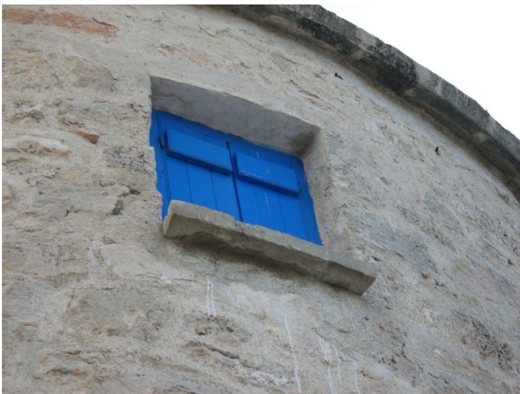
Εικόνα 45: Άνοιγμα στην Δεξιά όψη της βίγλας
