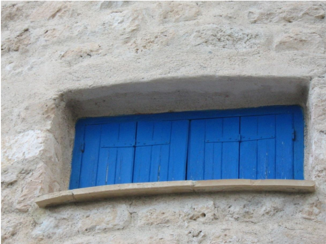
Εικόνα 41: Ανοιγμα στην μέση της Β.Α. πλευράς της βίγλας.
