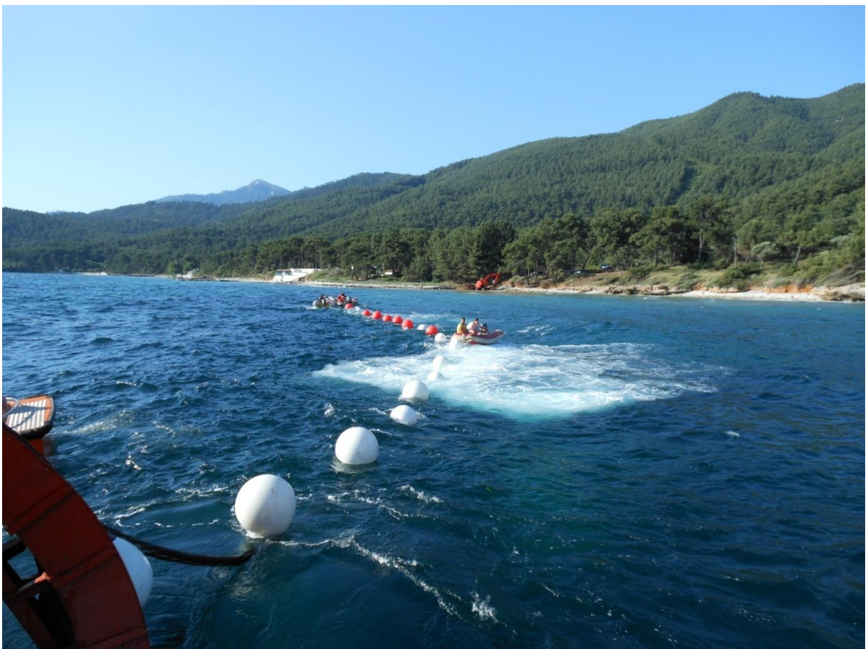
Εικόνα 7. Καλώδιο με συσκευές πλεύσης κατά την προσγείωση του στο νερό.
