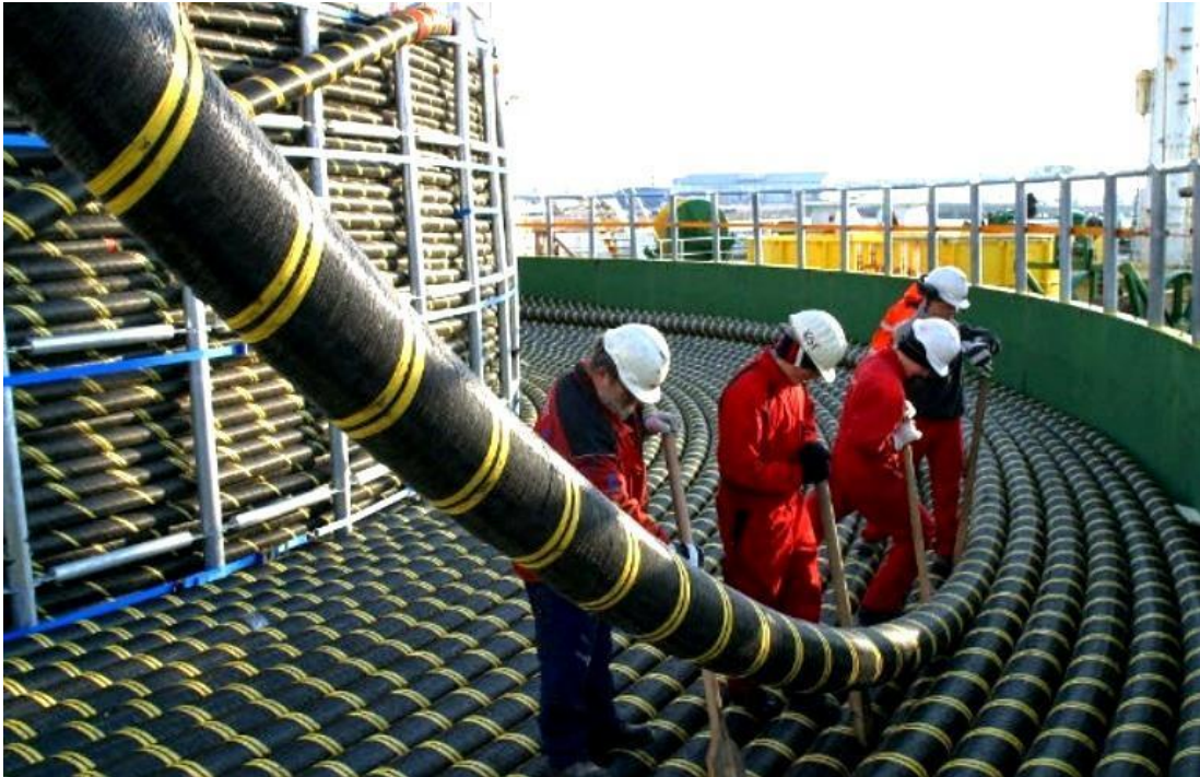
Εικόνα 9. Προετοιμασία βύθισης του καλωδίου
