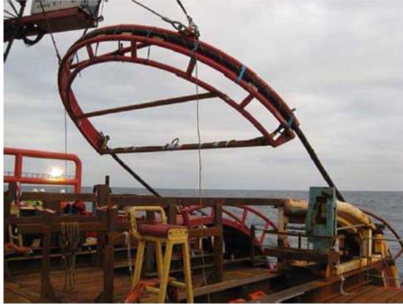
Εικόνα 18. Η γωνία του καλωδίου πριν το τελικό στάδιο της βύθισης του.
