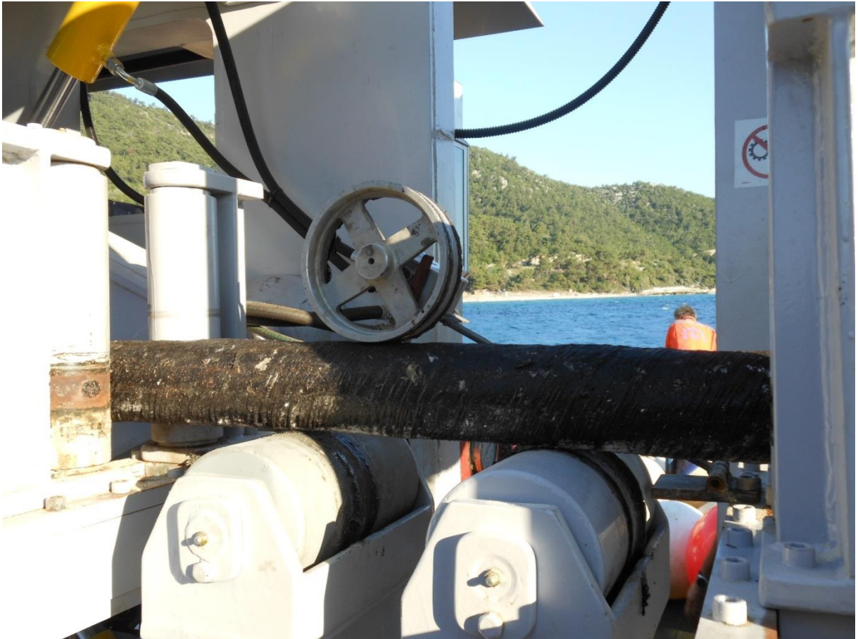
Εικόνα 6. Τροχαλία με την οποία γίνεται η προσγείωση του καλωδίου.
