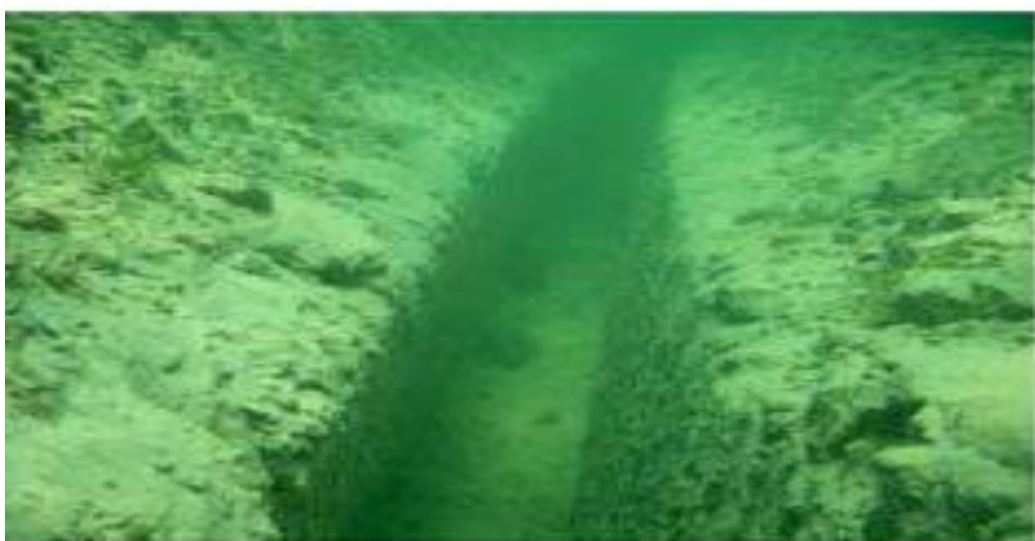
Εικόνα 13. Χαρακώμα για την ταφή του καλωδίου στον βυθό.
