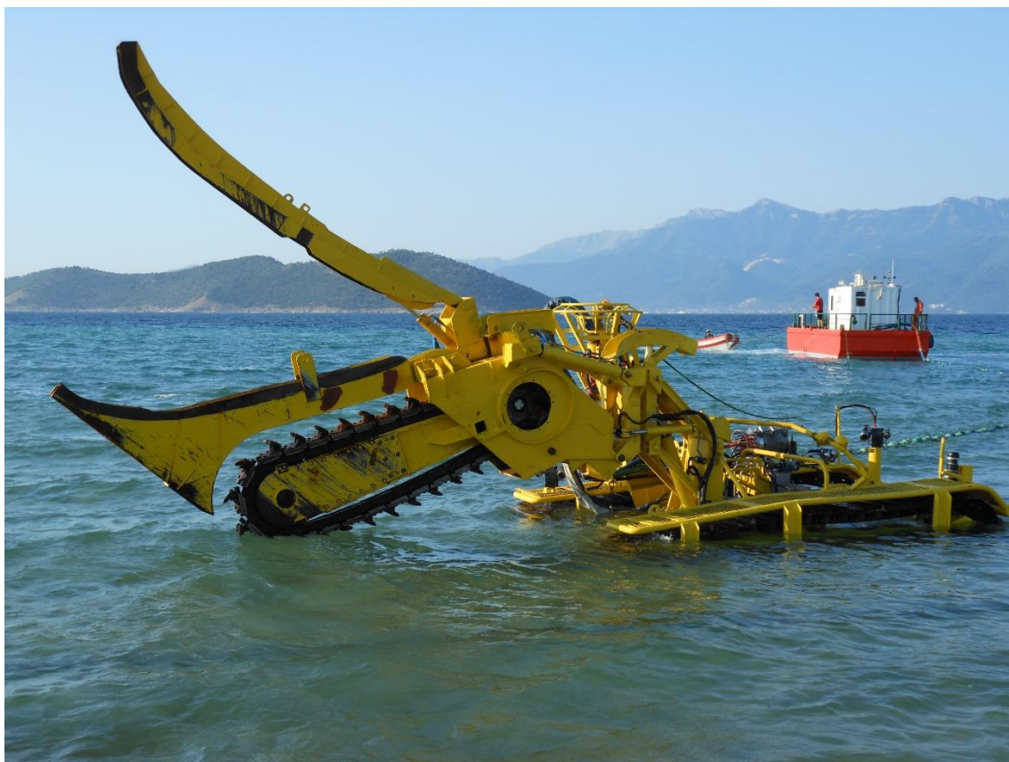
Εικόνα 14. Μηχάνημα εκσκαφής σε ρηγά νερά.
