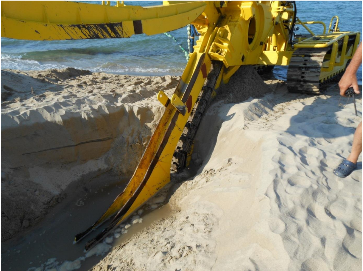
Εικόνα 15. Εκσκαφή σε παραλιακό χώρο.
