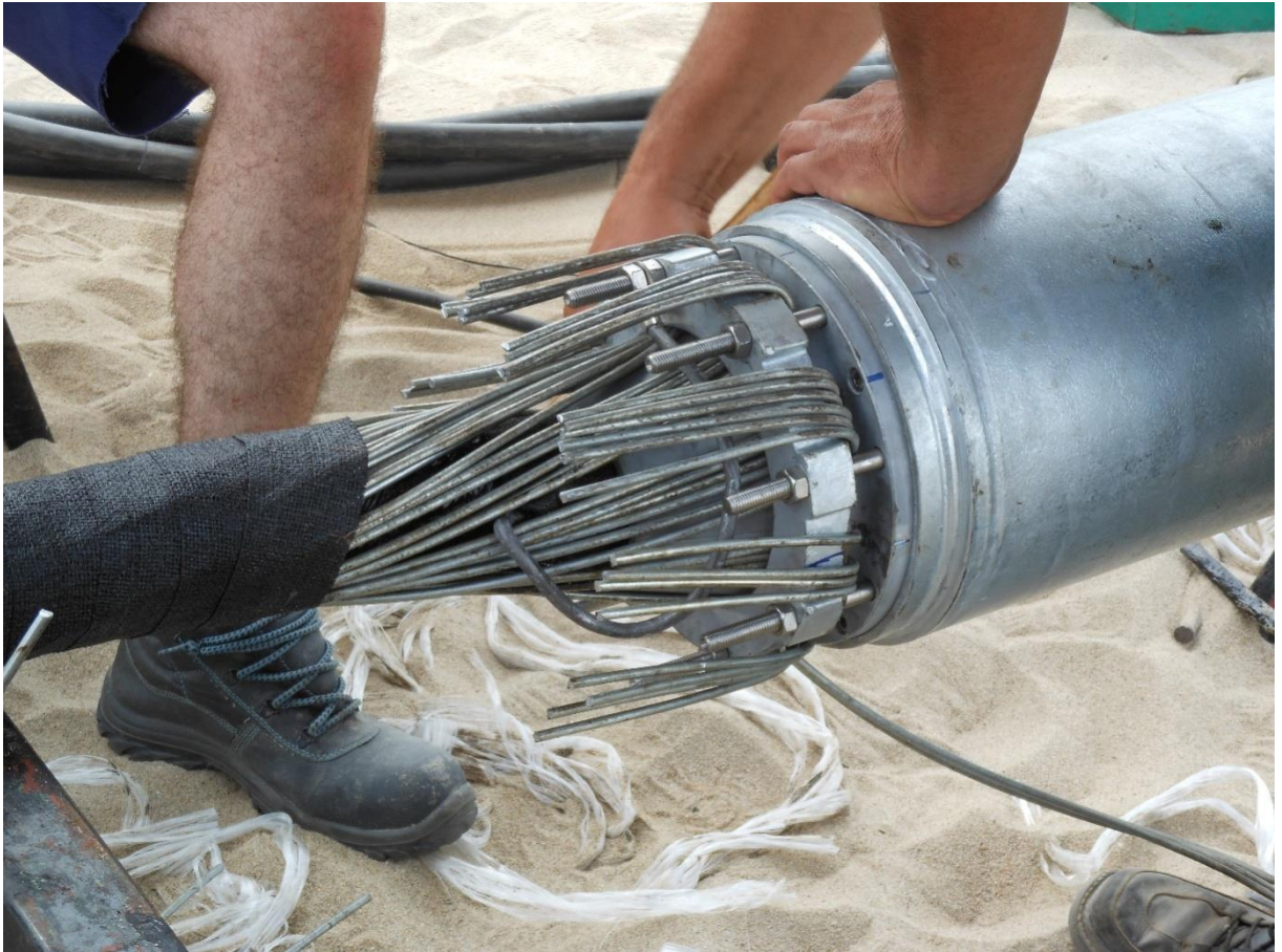
Εικόνα 11. Σύνδεση υποβρυχίων καλωδίων.
