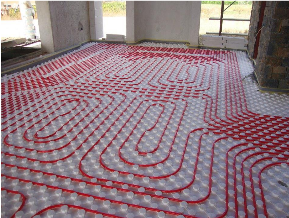
Σχήμα 5.1- Εγκατάσταση ενδοδαπέδιας θέρμανσης
