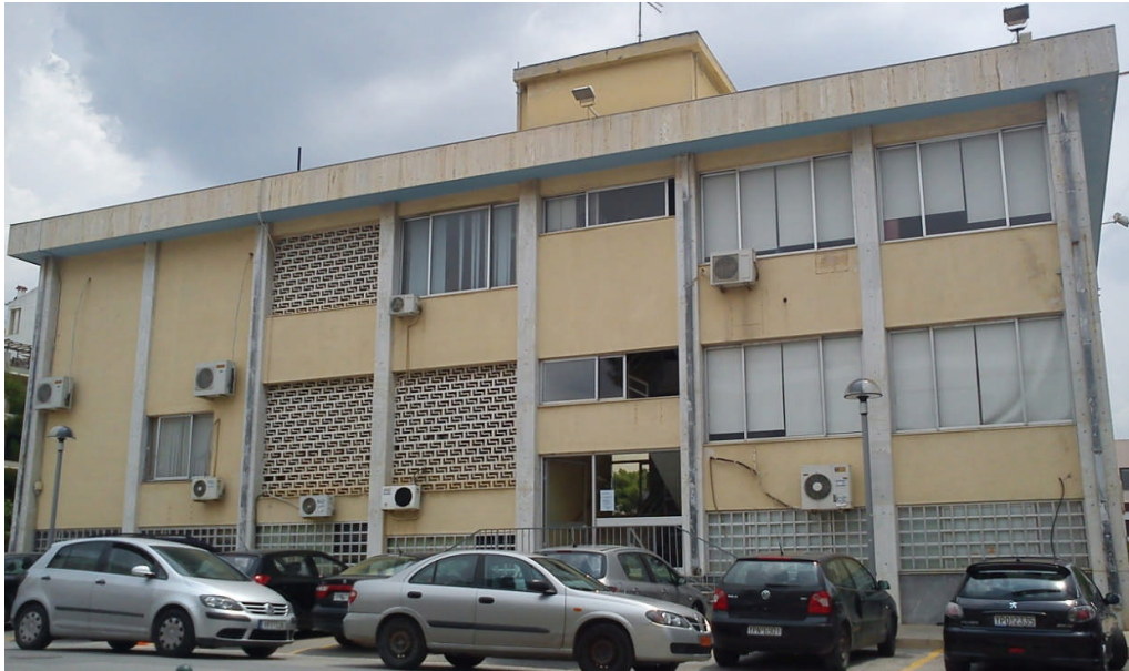
Εικόνα 23. Δυτική πλευρά του Δημαρχείου, δεύτερη είσοδος του κτιρίου. Υποδεικνύουμε κατάλληλο την τοποθέτηση του θερμοκηπίου
