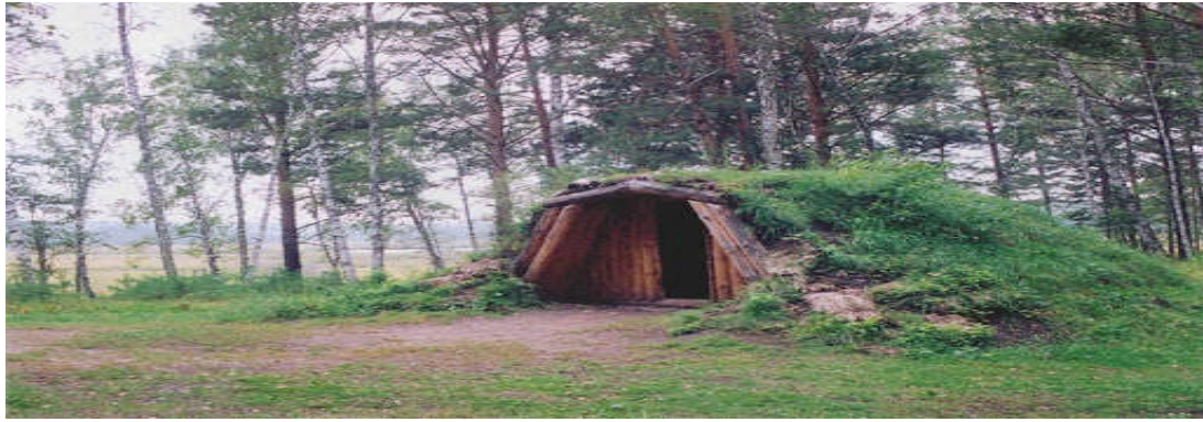
Εικόνα 13. Κέλυφος κτιρίου για περιορισμό της θερμικής απώλειας
