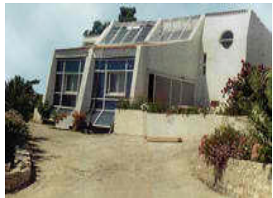
Εικόνα 33. Σύστημα θερμοσιφωνικό πάνελο σε μια κατοικία
