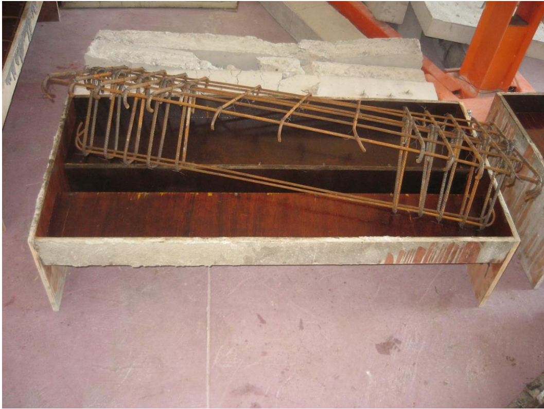
Εικόνα 4. Κλωβός έτοιμος να τοποθετηθεί μέσα στο καλούπι
