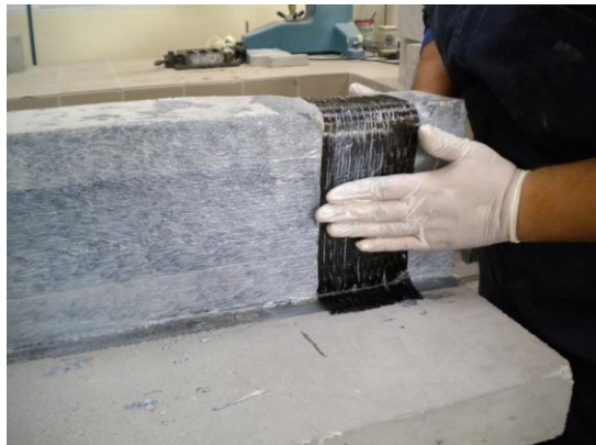
Εικόνα 11. Σωστή τοποθέτηση, αγκύρωση U τενωμένου υφάσματος
