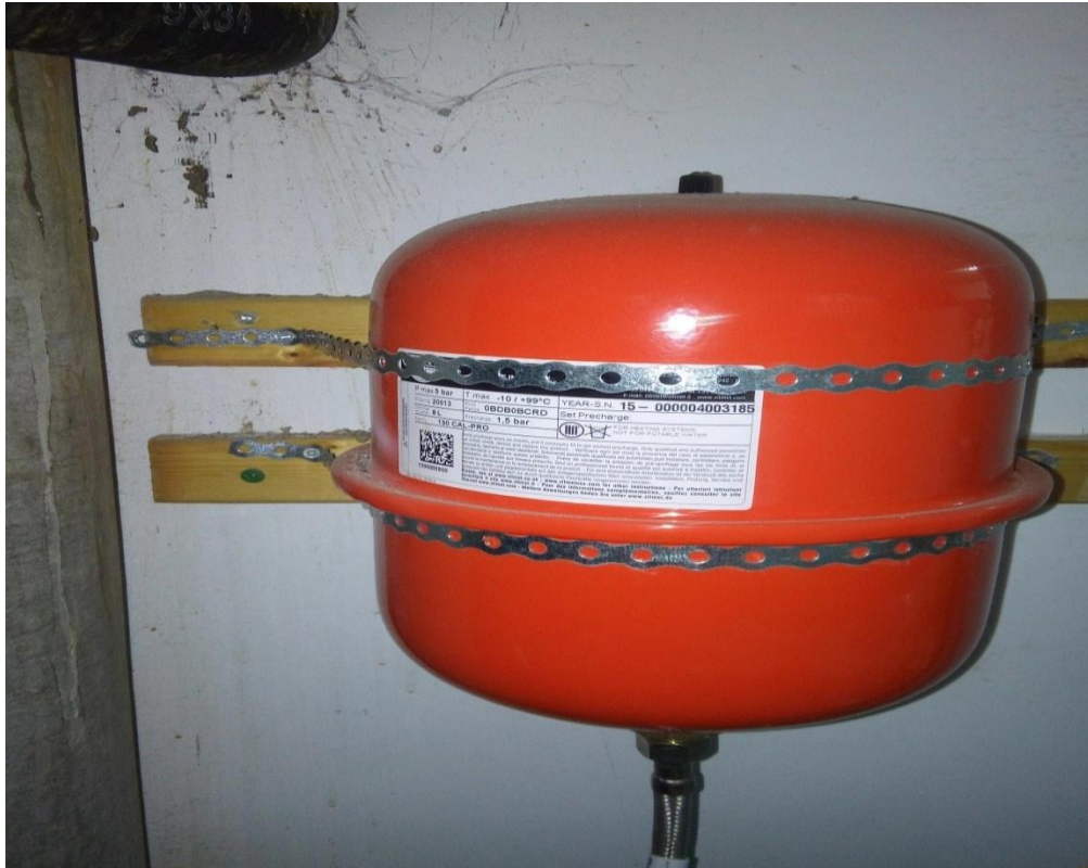
Σχήμα 10.9 Δοχείο διαστολής.
