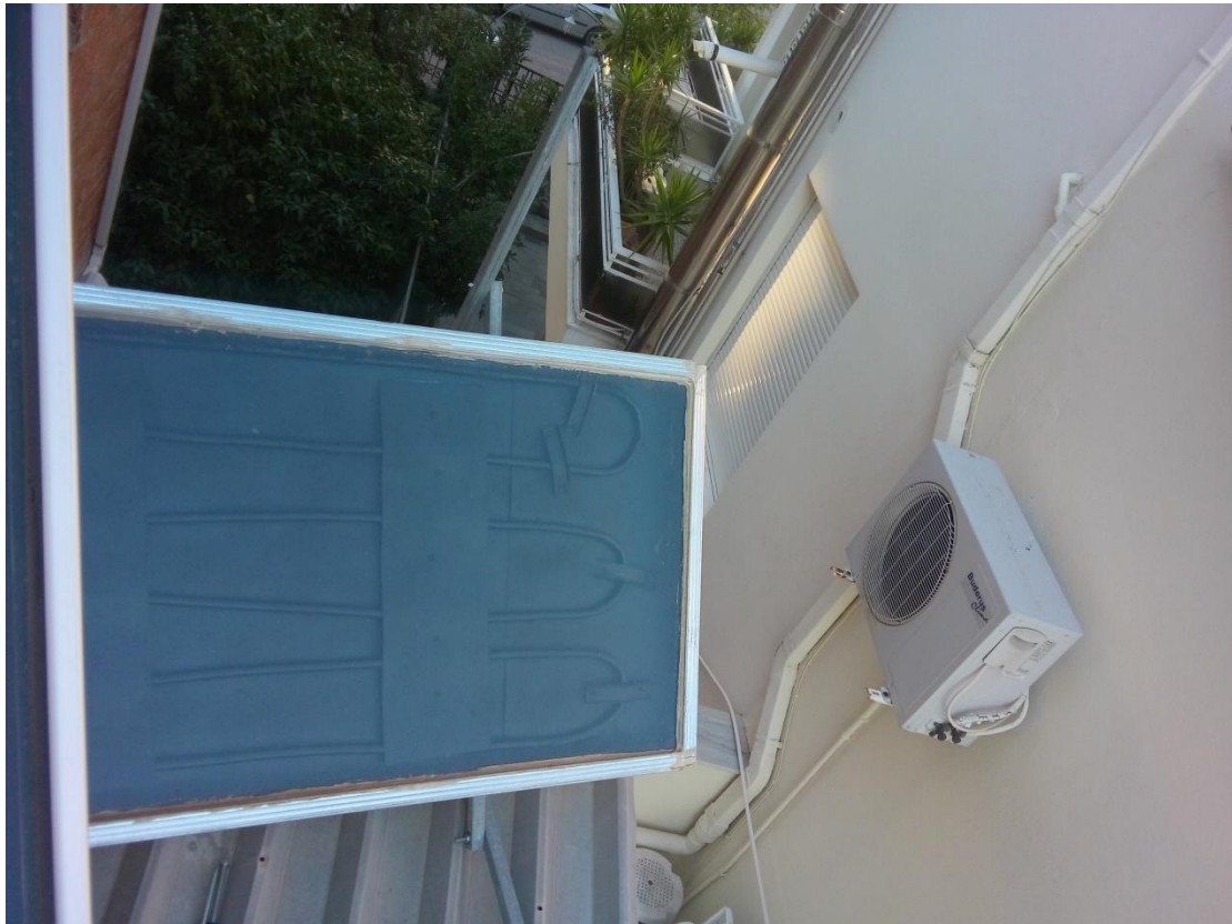
Σχήμα 10.5 ολοκλήρωση των εργασιών με τοποθέτηση υαλοπίνακα.
