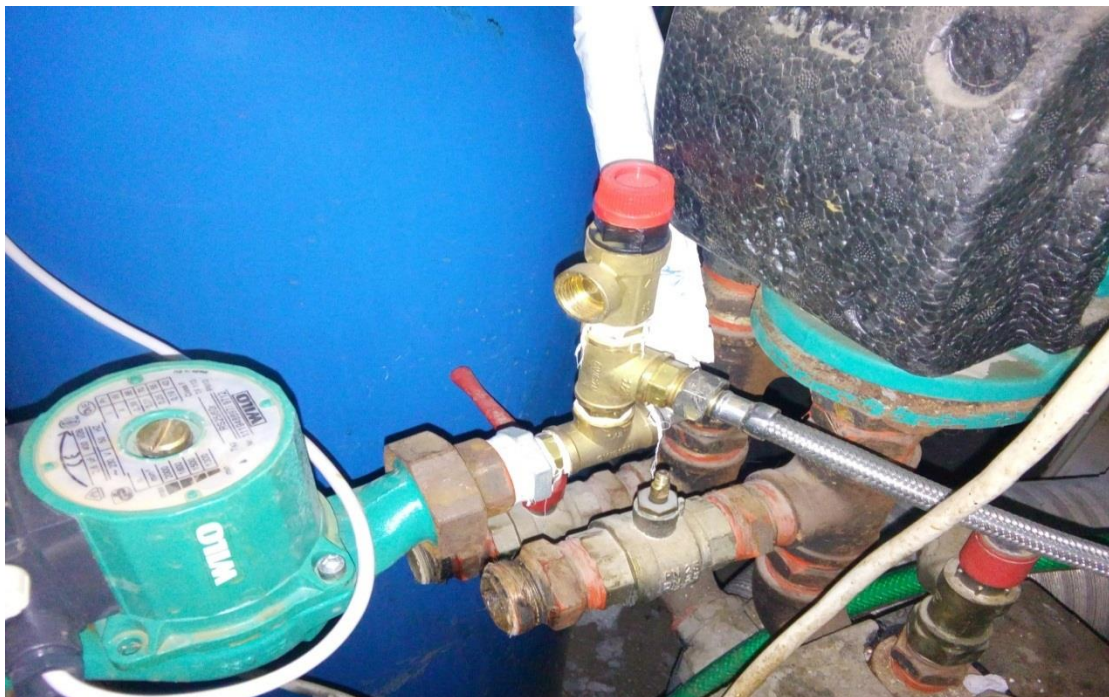
Σχήμα 10.8 Η βαλβίδα ασφάλειας, ο σωλήνας τύπου σπирάλ για σύνδεση με το δοχείο διαστολής καθώς επίσης η σύνδεση της πολυστροματικής για σύνδεση με τους συλλέκτες.
