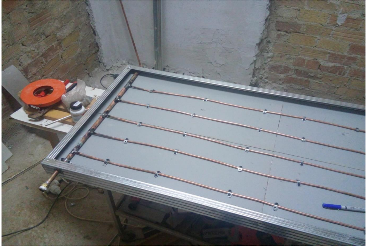
Σχήμα 10.1 Στάδιο κατασκευής –κόλληση των σωληνώσεων πάνελ.
