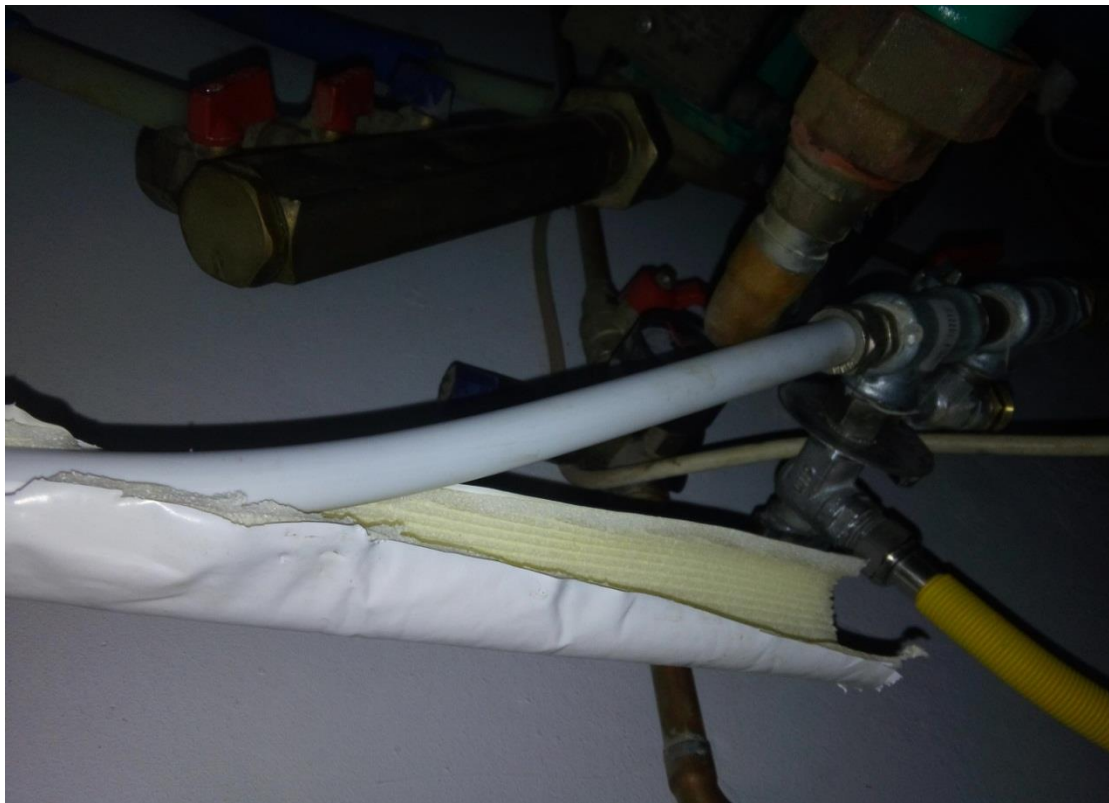
Σχήμα 10.10 Η έξοδος από δοχείο και όδευση προς τα ηλιακά πάνελ.
