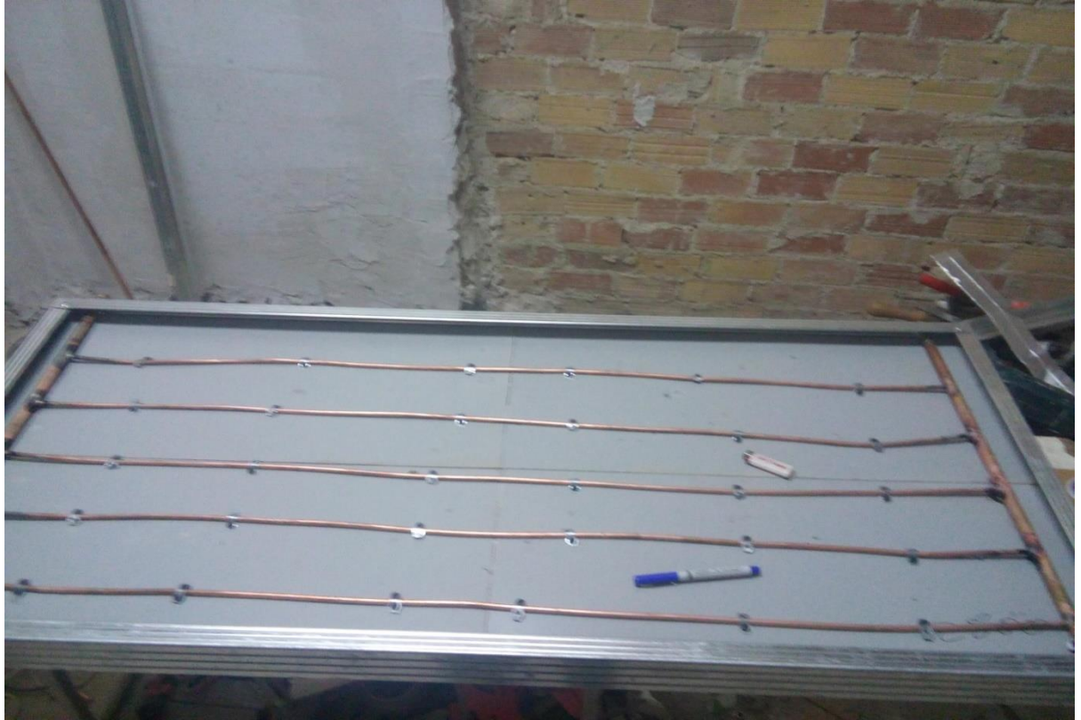
Σχήμα 10.2 ολοκλήρωση των κολλημάτων στο πάνελ.
