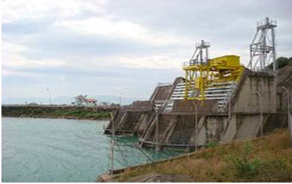
Σχήμα 2.1.10.2.: Το υδροηλεκτρικό εργοστάσιο της Στράτου
