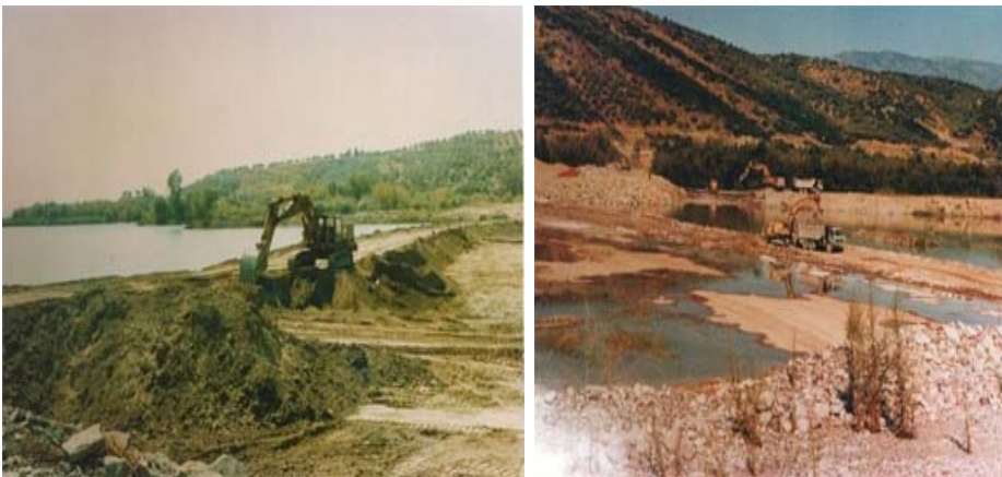
Σχήμα 2.1.10.3.: Εργασίες κατά την κατασκευή του Φράγματος Στράτου
