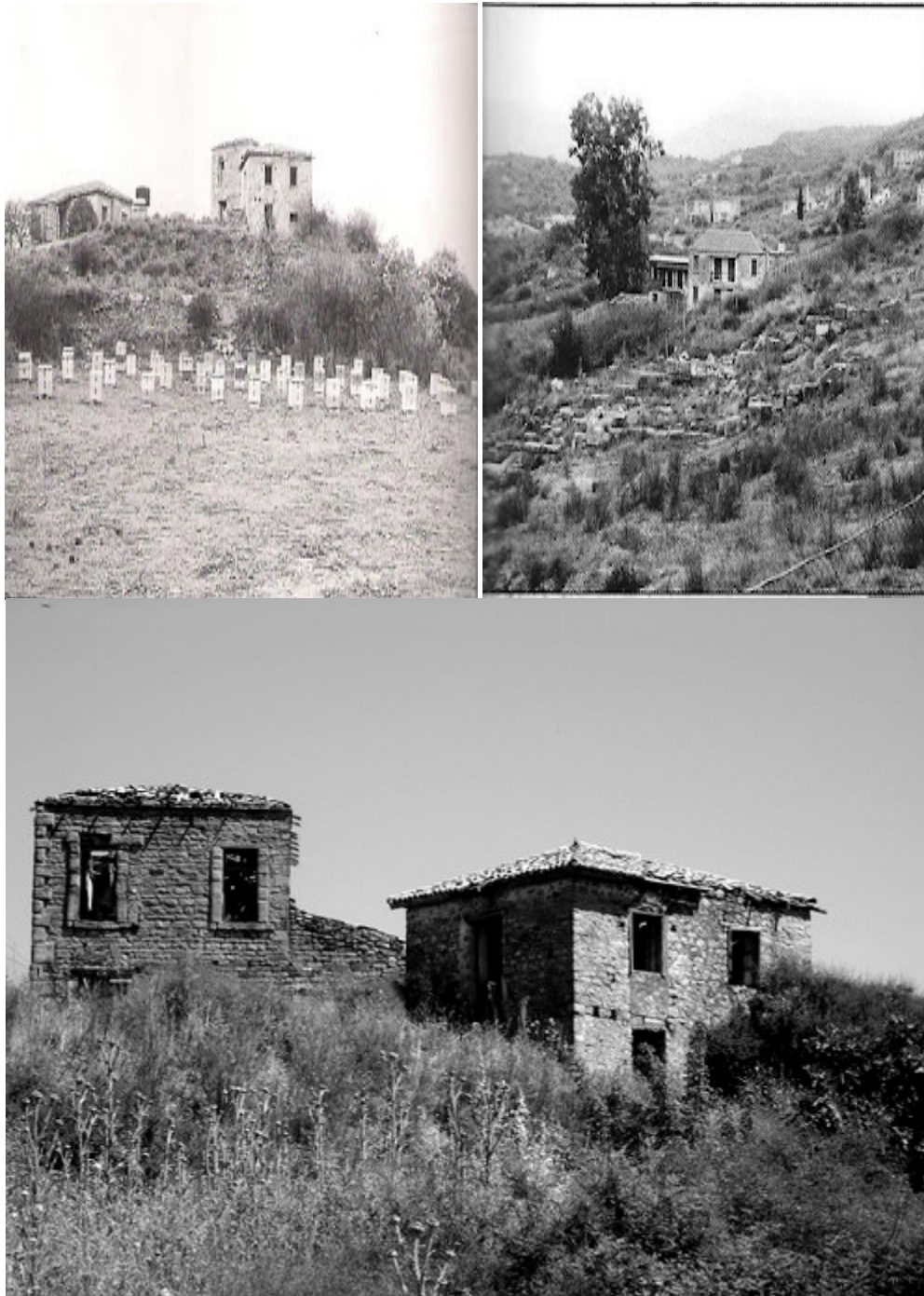
Σχήμα 2.1.9.3.: Παλαιές διώροφες λιθόκτιστες κατοικίες στην Στράτο
