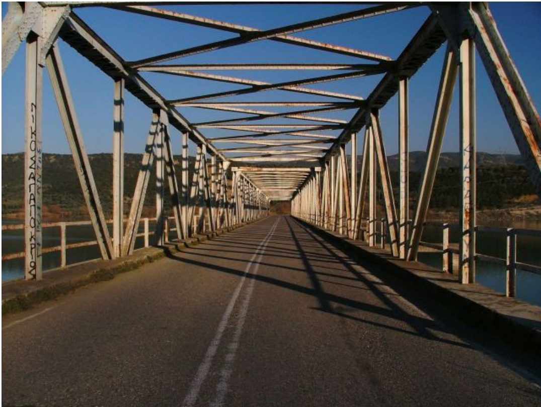
Σχήμα :2.3.2.1. Η Μεταλλική Γέφυρα Μτσουκίου στον Αχελώο
