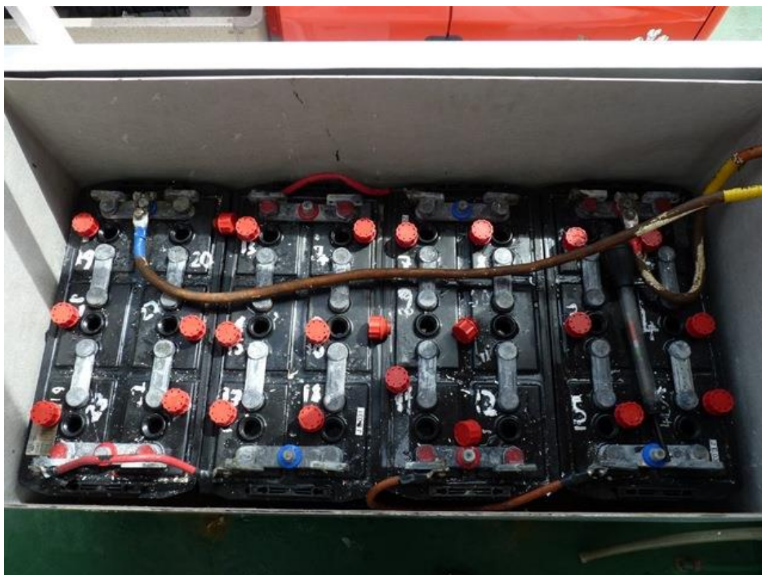
Εικόνα 10. Τμήμα του συσσωρευτή ανάγκης των πλοίων
