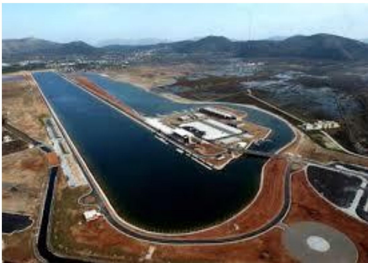
Εικόνα 1. Το Ολυμπιακό Κωπηλατοδρόμιο
