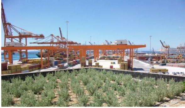
Εικόνα: Η πράσινη ταράτσα του νέου κτιρίου γραφείων στο Νέο Σταθμό Εμπορευματοκιβωτίων (Ν. ΣΕΜΠΟ) ΟΛΠ ΑΕ.
