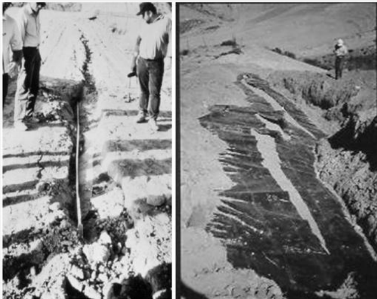
Εικόνα 5.57_ Σχισμές γεωμεμβράνης στην τομή: C1 - C1' (αριστερά) και στην τομή: D2 - D2' (δεξιά) του ΧΥΤΑ Chiquita Canyon [23]
