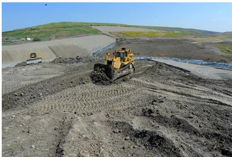
Εικόνα 3.10_ Πρωθητές και Ερπυστριοφόροι Φορτωτές [52]
