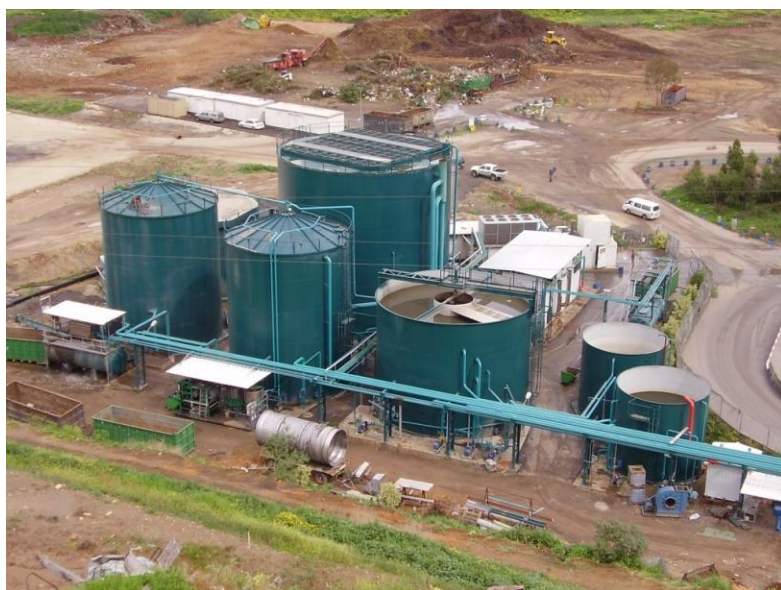
Εικόνα 2.12_ Εγκαταστάσεις Αναερόβιας Επεξεργασίας [46]
