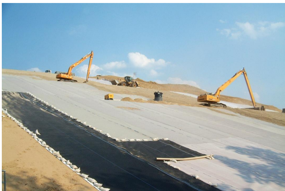
Εικόνα 3.2_Κατασκευή σύνθετης μόνωσης με Γεωμεμβράνες και γεωφάσματα [47]
