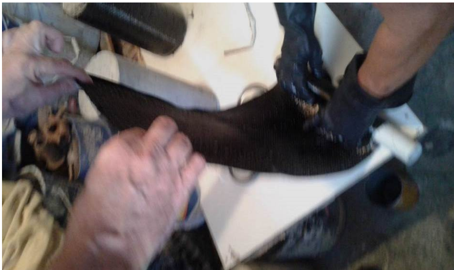
Εικόνα 6.31 Προετοιμασία υφάσματος CFRP για κυλινδρικό δοκίμιο
