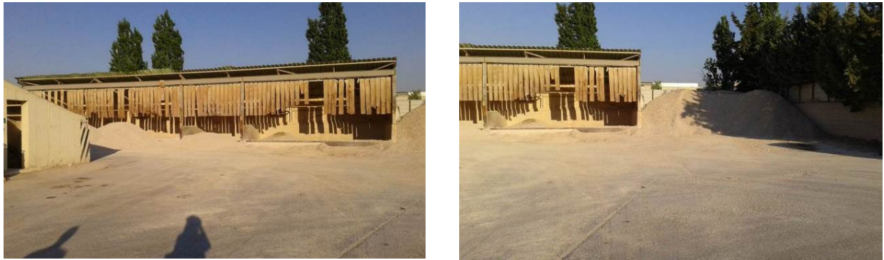
Εικόνα 5.3 Εγκαταστάσεις της 'ΤΣΟΥΜΑ ΜΠΕΤΟΝ Α.Ε', χώρος φύλαξης αδρανών υλικών
