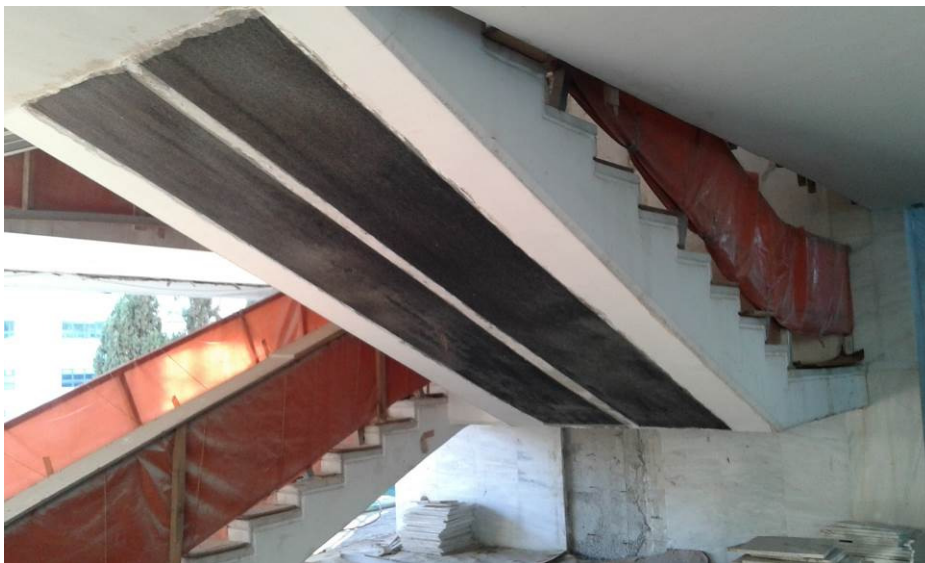
Εικόνα 4.11 Ενίσχυση κλίμακας της Εθνικής Πινακοθήκης Αθηνών με CFRP
