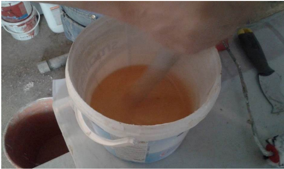
Εικόνα 6.20 Ανάμειξη εποξειδικής ρητίνης δύο συστατικών Sinmast S2WV
