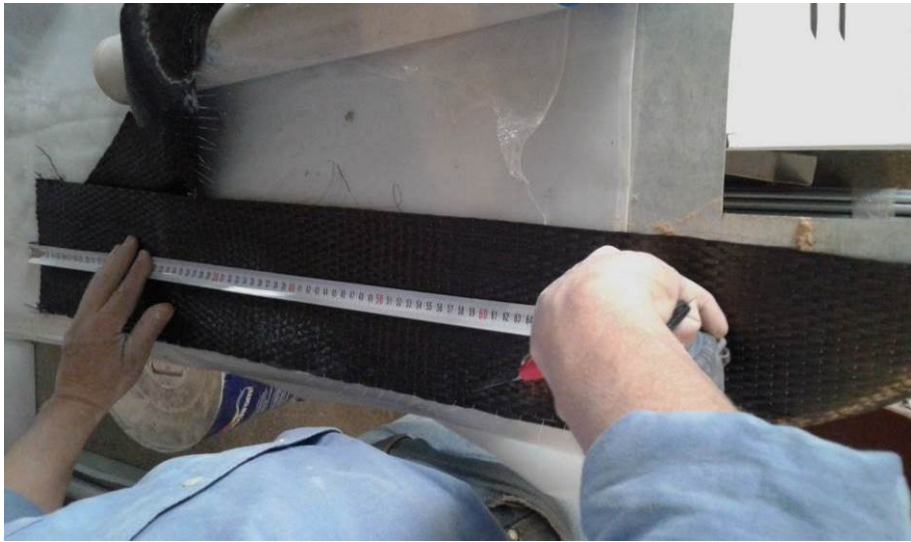
Εικόνα 6.22 Ύφασμα CFRP πριν την εφαρμογή του σε κυβικό δοκίμιο
