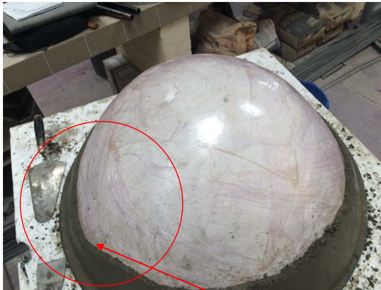
Εικόνα 51.Σταδιακή σκυροδέτηση και έλεγχος πάχους της διατομής του φορέα
