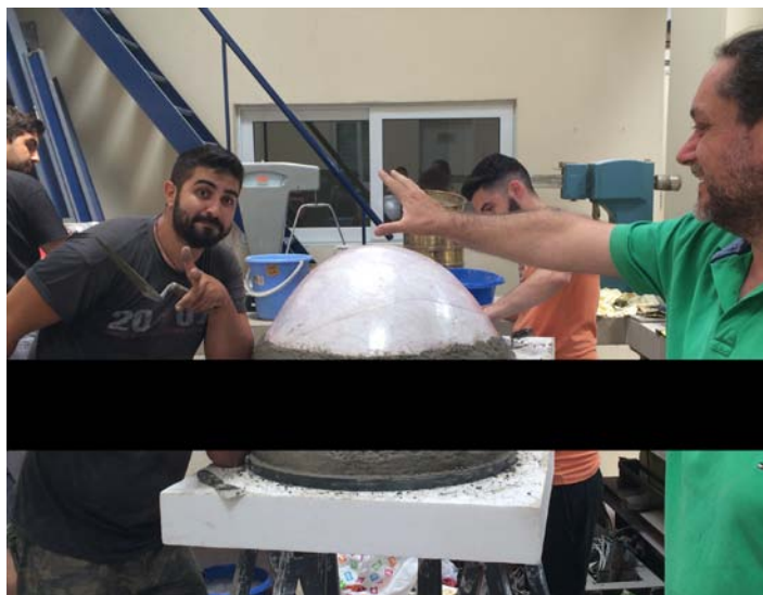
Εικόνα 49.Σταδιακή σκυροδέτηση του τρούλου από κάτω προς τα πάνω
