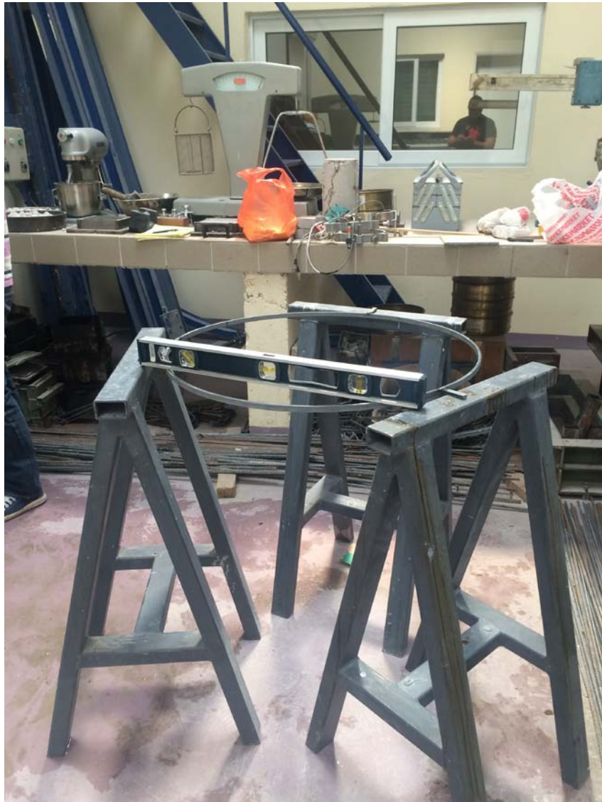
Εικόνα 31.Αλφάδιασμα τσερκιού βάσης του τρούλου
