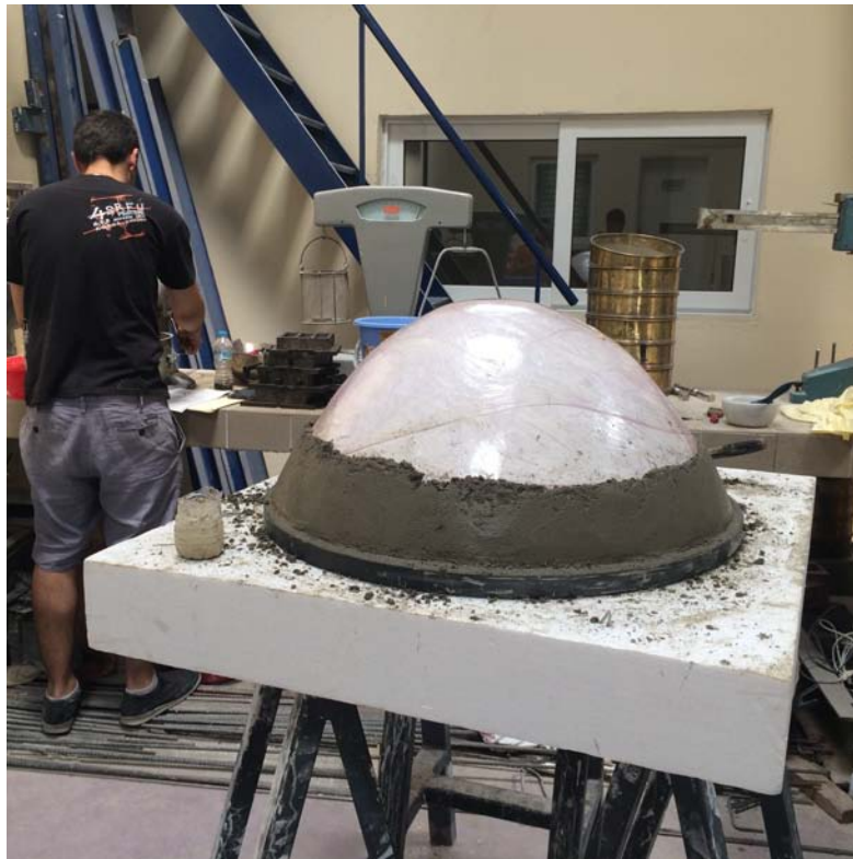
Εικόνα 50.Σταδιακή σκυροδέτηση του τρούλου
