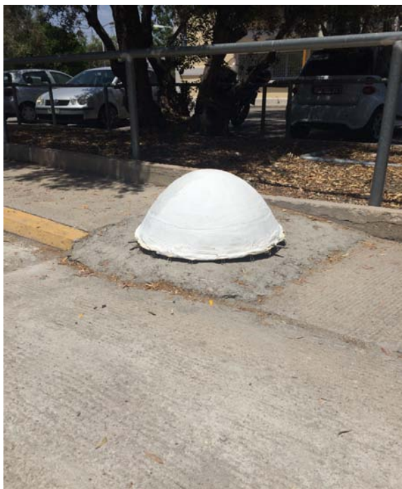
Εικόνα 44.Στέγνωμα ρητίνης στο καλούπι, πλέον σχεδόν ολοκληρωμένο
