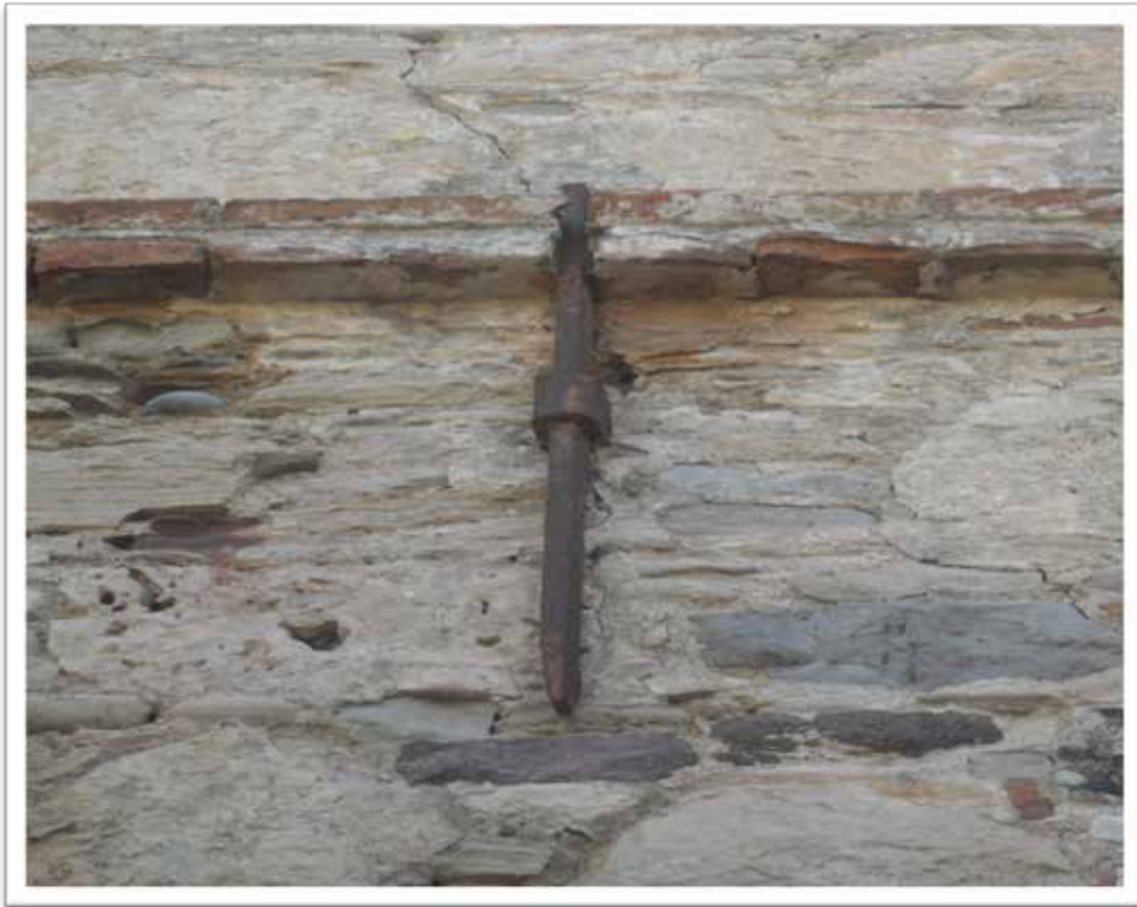
Εικόνα 18 Εξωτερική τοιχοποιία με αγκίστρωση για το πάτωμα του ορόφου σε Βυρσοδεψείο της Σάμου
