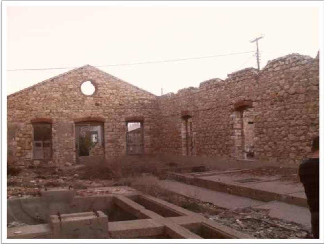
Εικόνα 15 Βυρσοδεψείο Νικολάου (Σημερινή κατάσταση)
