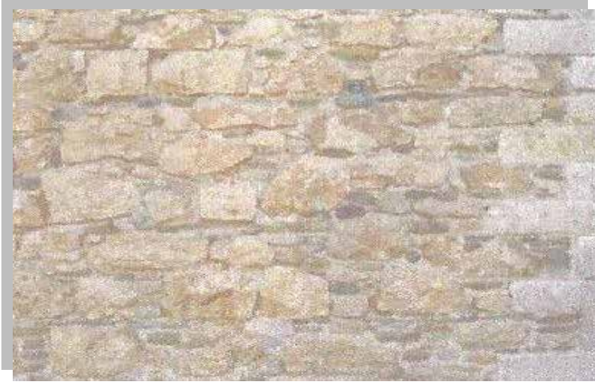
Εικόνα 17 Τοιχοποιία Βυρσοδεψείο Νικολάου
