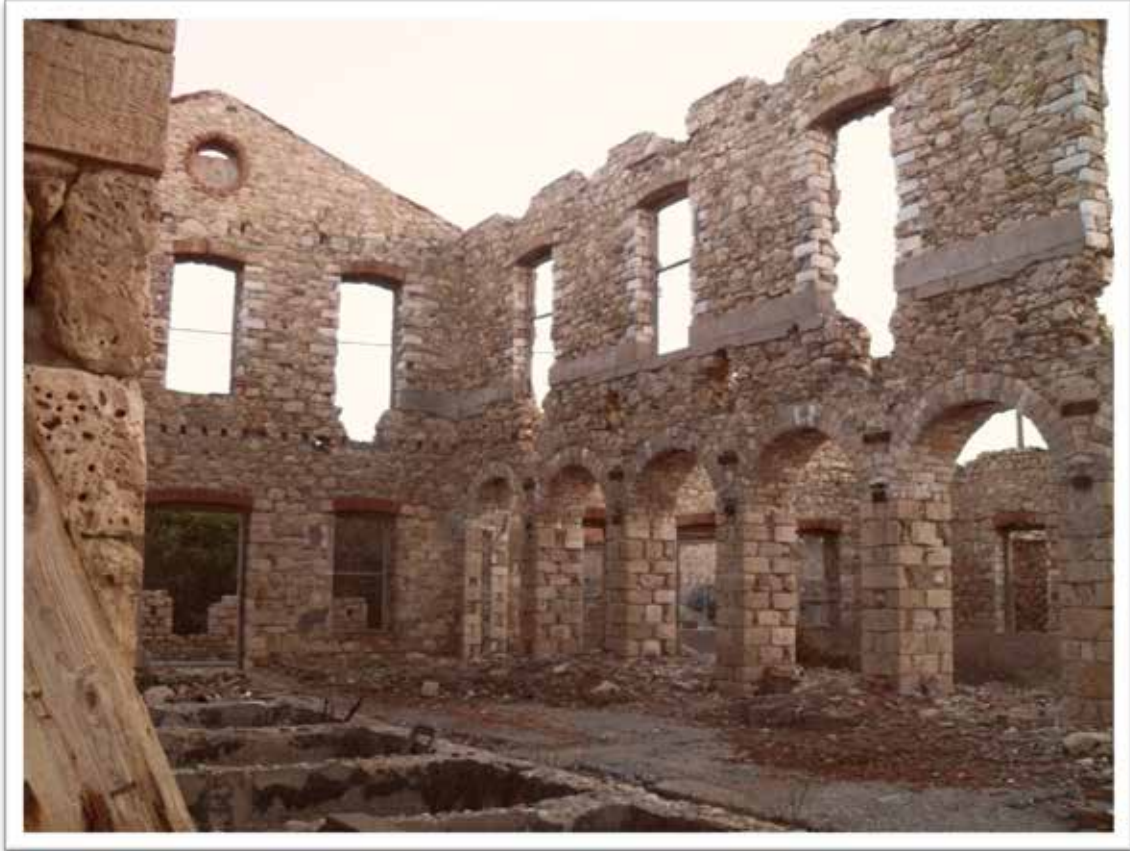
Εικόνα 14 Βυρσοδεψείο Νικολάου (Σημερινή κατάσταση)
