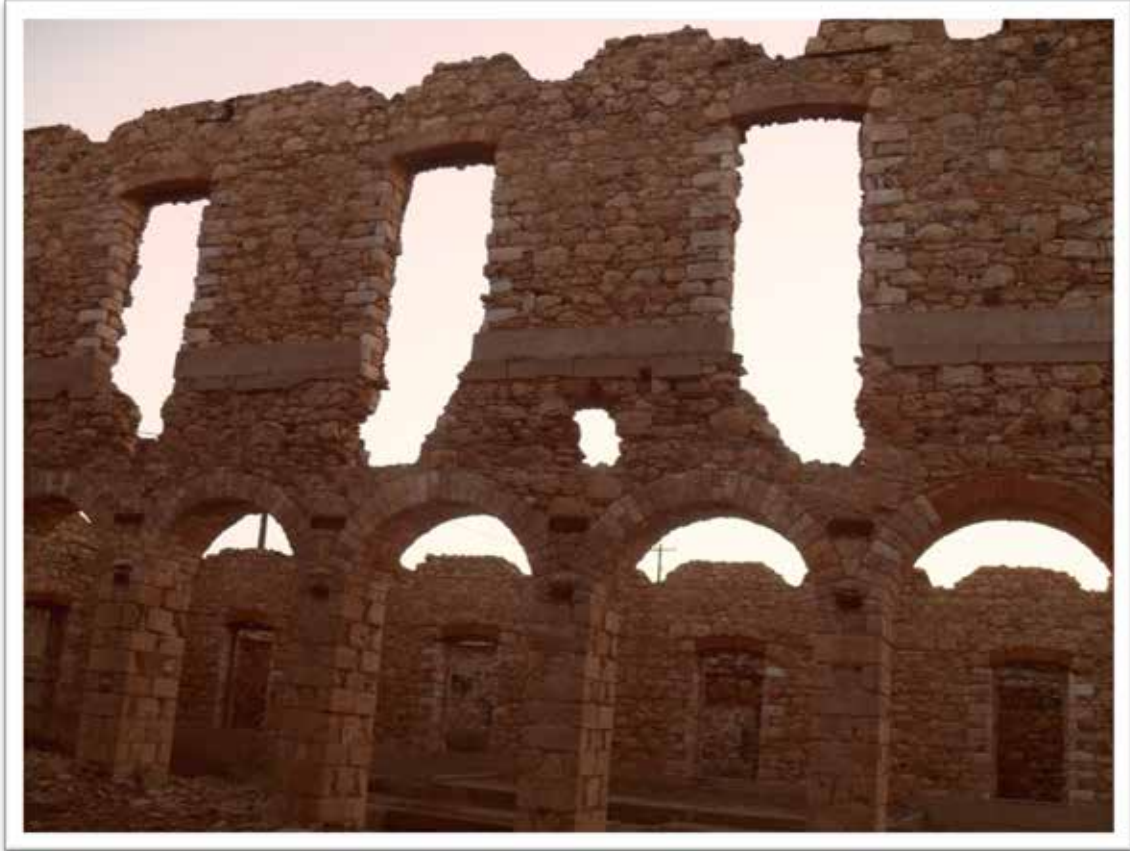
Εικόνα 27:Υπάρχουσα κατάσταση Βυρσοδεψείου Νικολάου
