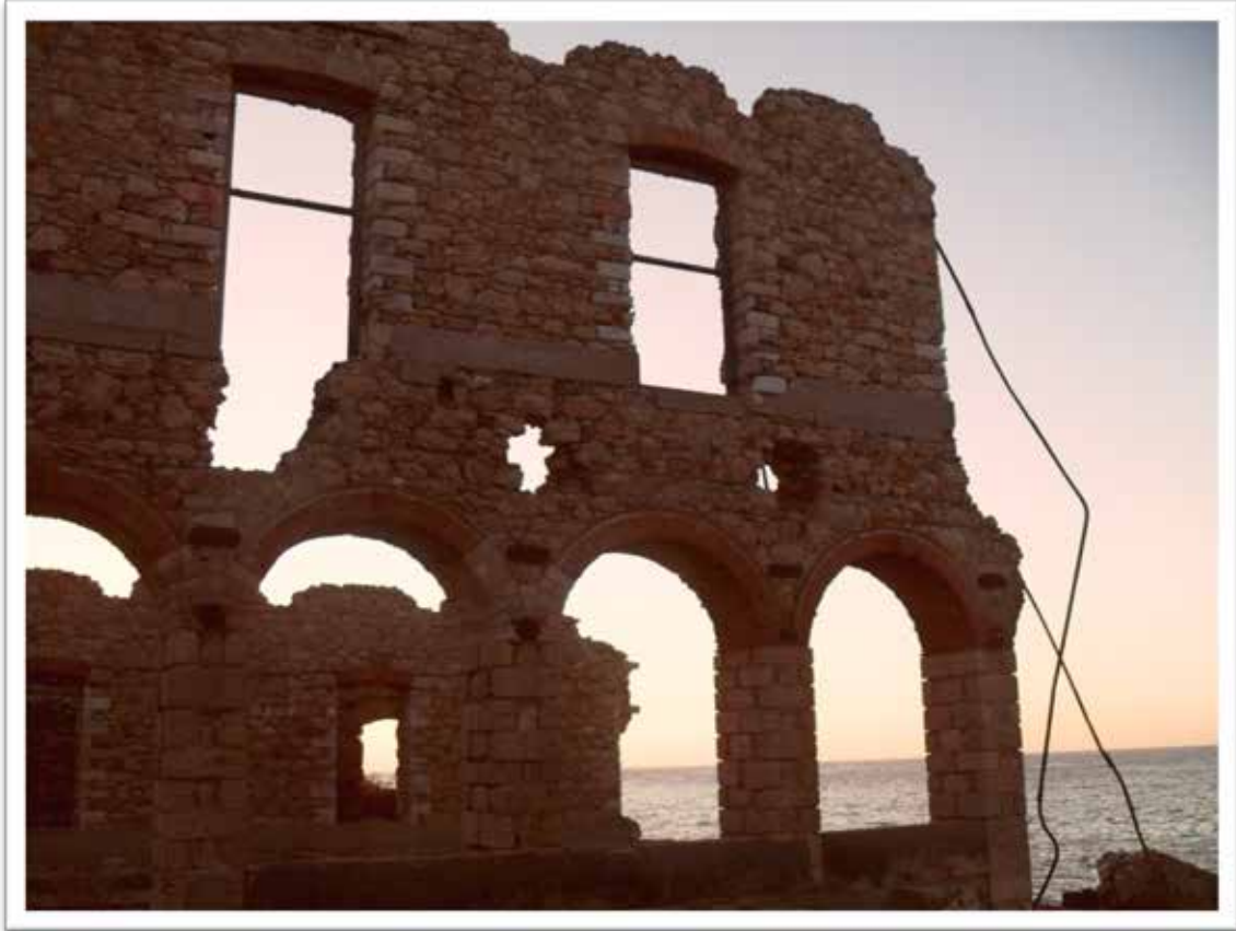
Εικόνα 28:Υπάρχουσα κατάσταση Βυρσοδεψείου Νικολάου
