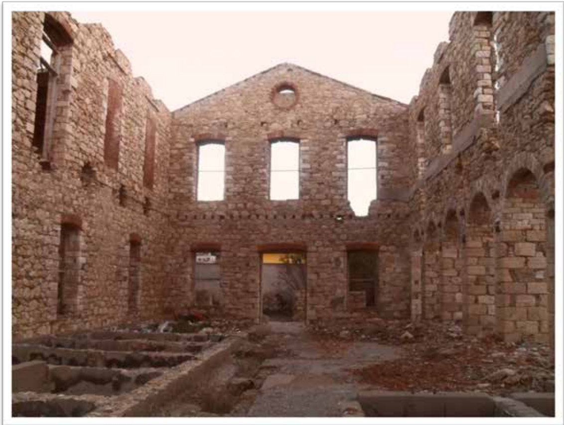
Εικόνα 13 Βυρσοδεψείο Νικολάου (Σημερινή κατάσταση)
