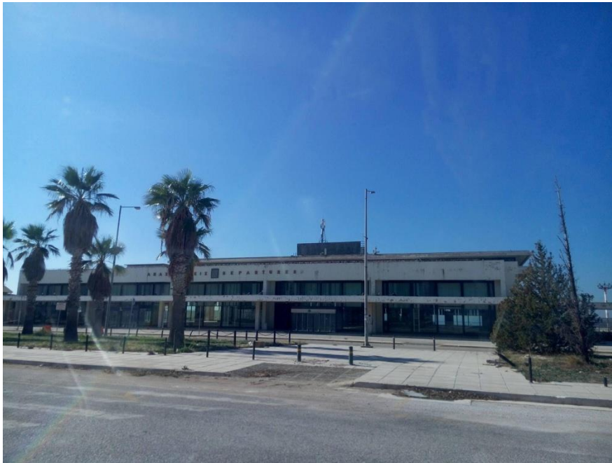
(φωτ.11&12&13) Απεικονίζεται η είσοδος του παλαιού αεροδρομίου
