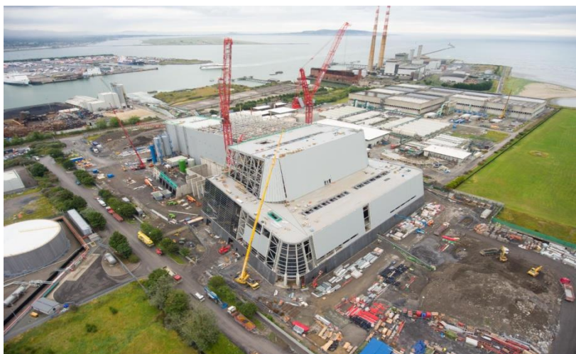
(Φωτ.6) Εργοστάσιο WtE που κατασκευάζεται στην Ιρλανδία από την Covanta.
