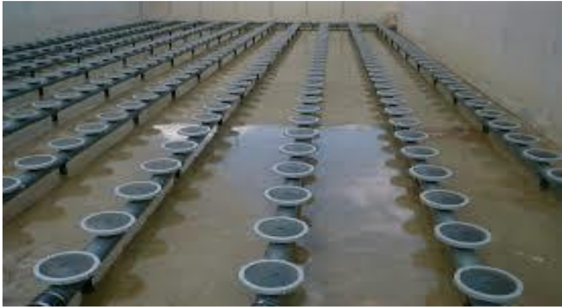
Εικόνα 2.5-2 : Μεμβράνες διάχυσης λεπτής φυσαλίδας.
