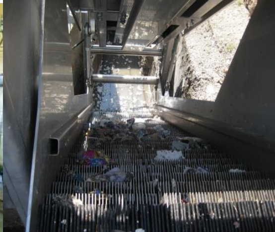
Εικόνα 2.2-2β:βηματική εσχάρα
