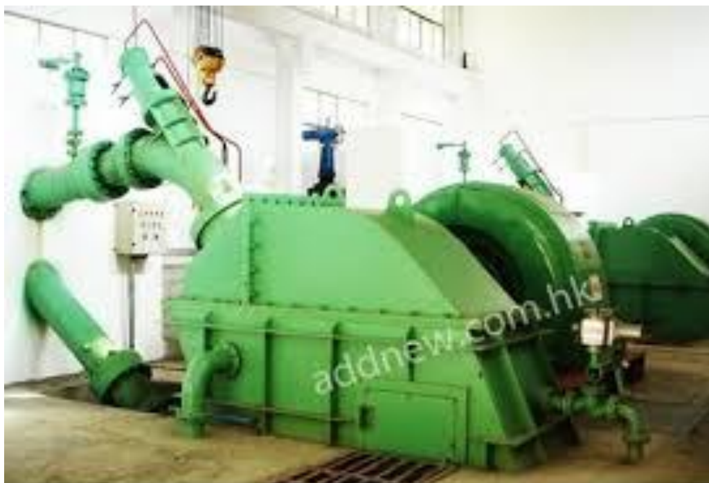
Εικόνα 4.3.1: Εγκατάσταση υδροστρόβιλων σε έξοδο βιολογικού.
