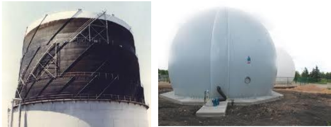
Εικόνα 2.13-1 :Αεριοφυλάκιο α)τύπου ανάστροφου κώδωνα , β) τύπου μπαλονιού.
