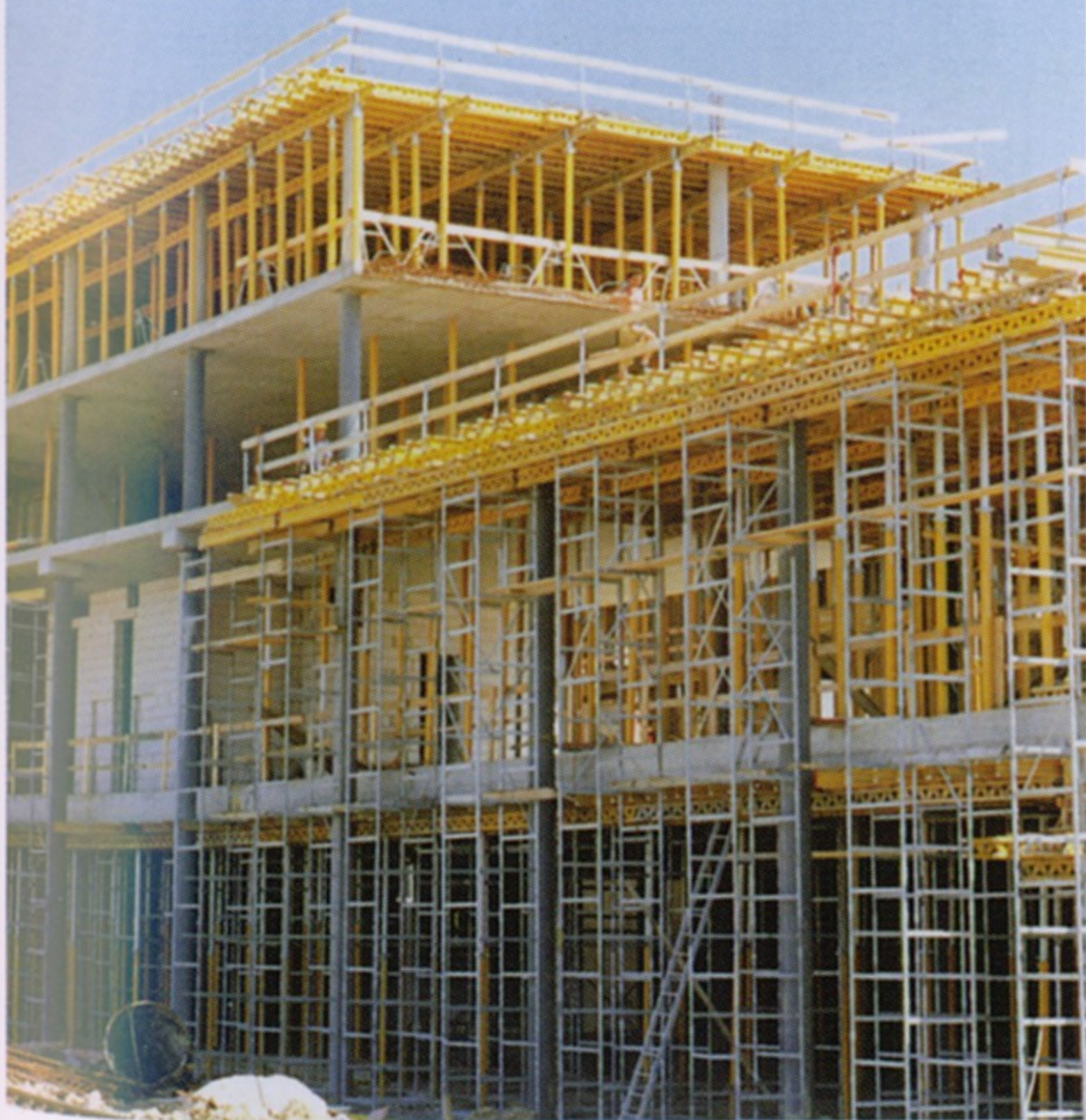
Οι δοκοί GT 24 σε χρήση στο σύστημα MULTIFLEX με πύργους υποστήλωσης ST 100.
