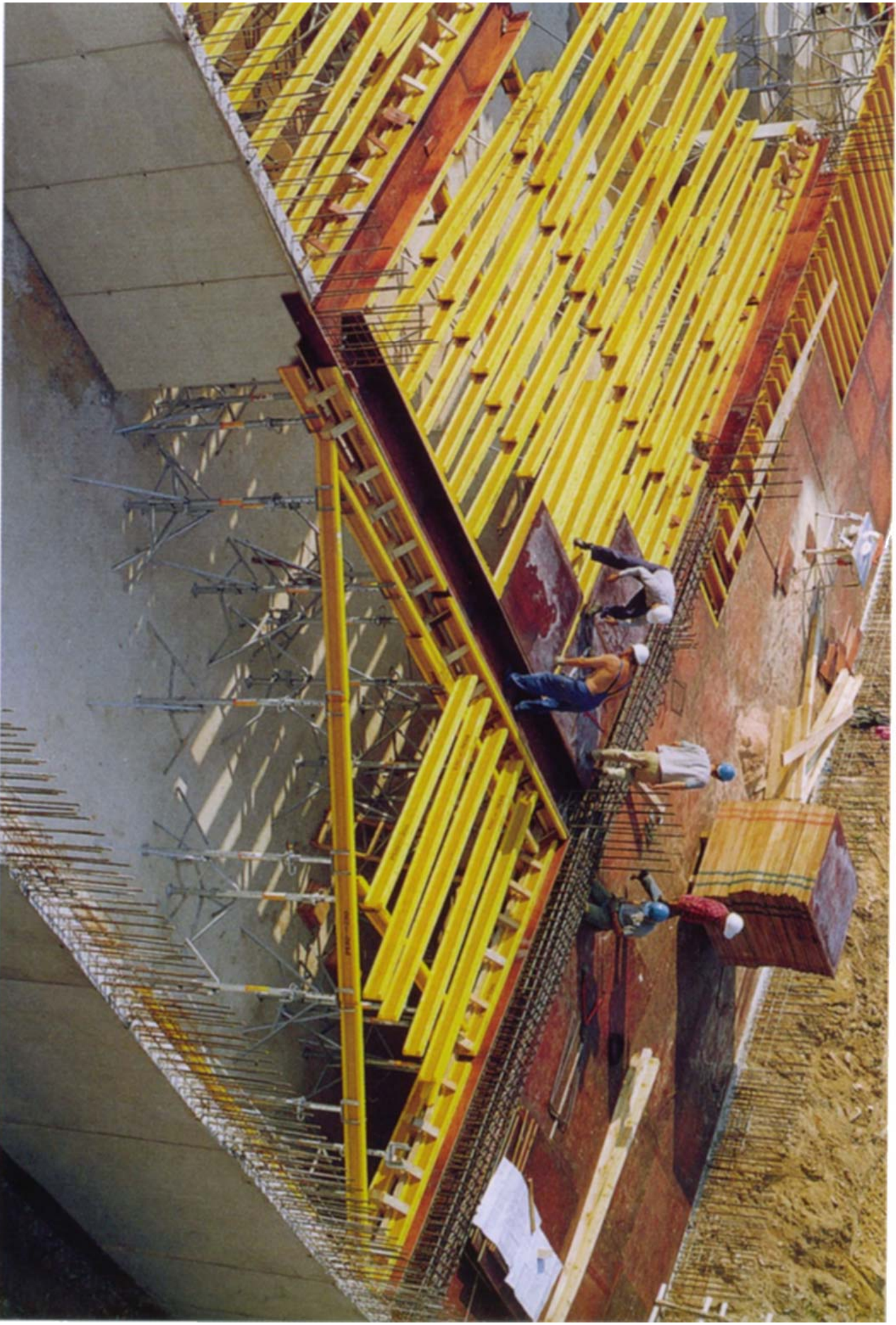
Η δοκός VT 20K σε καλούπωμα πλάκας βιομηχανικού έργου.
