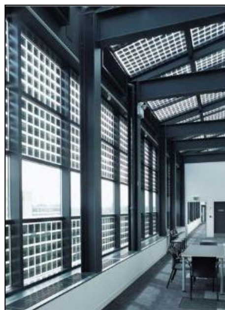
Σχήμα 2.89: α) κατασκευαστική δομή στεγανού υαλοπίνακα σε συνδυασμό με γυάλινο ημιδιαπερατό ΦΒ συλλέκτη β) τοποθέτηση γυάλινων ημιδιαπερατών ΦΒ συλλεκτών σε κτήριο
