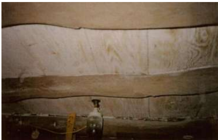
Εικόνα 19 Μεγάλα δοκάρια στήριζαν τις σανίδες του επάνω δώματος
