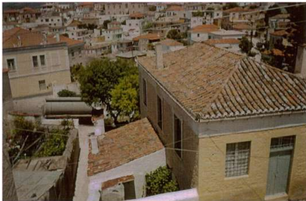
Εικόνα 14 Χαρακτηριστικές στέγες του Παραδοσιακού “Βυζαντινού” τύπου με ξεχωριστό λούκι καπάκι
