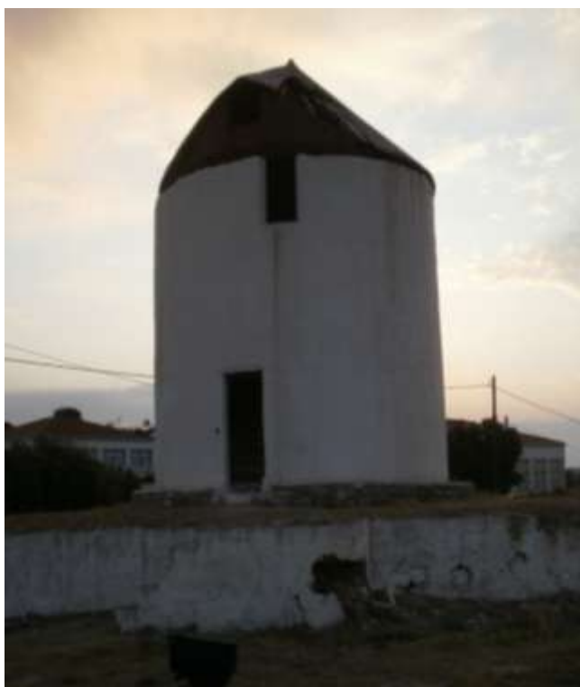
Εικόνα 33 Ο ανεμόμυλος Ντουνέτα είναι θεμελιωμένος σε βραχώδες έδαφος, με εξωτερικό περιφερειακό πέδιλο
