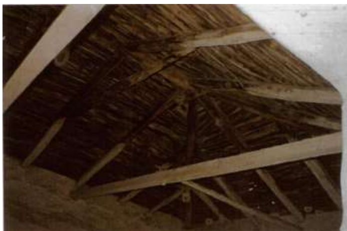
Εικόνα 20 Εμφανής ο σκελετός της στέγης σε διάταξη τριγώνου, καθώς και οι βέργες από βένιο
