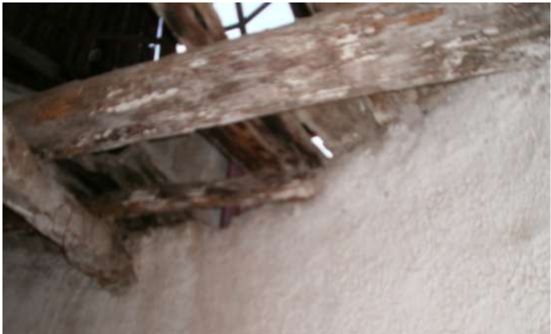
Εικόνα 47 Λεπτομέρεια στήριξης πατωμάτων
