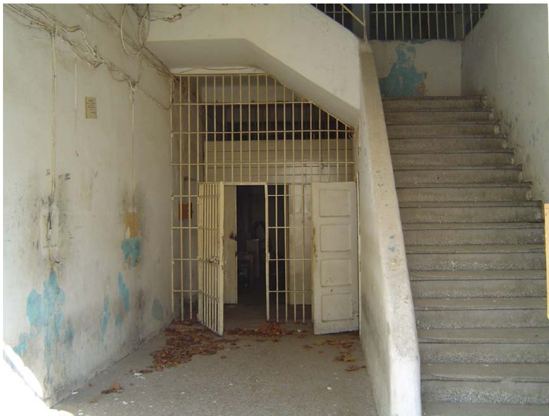
Εικόνα 1.19: Η σκάλα που οδηγεί στον όροφο
