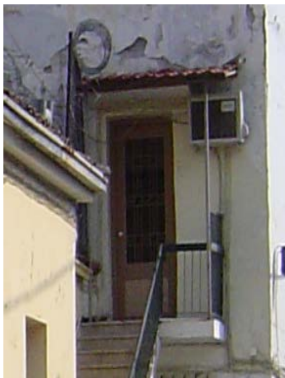
Εικόνα 1.37: Η εξωτερική θύρα του κτιρίου Β στον όροφο
