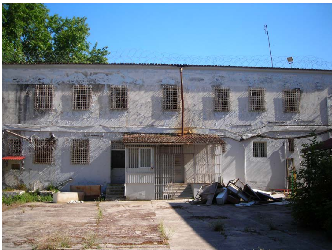
Εικόνα 1.16: Η έξοδος από το κτίριο Β στο προαύλιο των φυλακών
