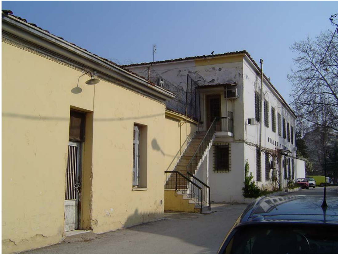
Εικόνα 1.30: Η εξωτερική σκάλα που οδηγεί στον όροφο
