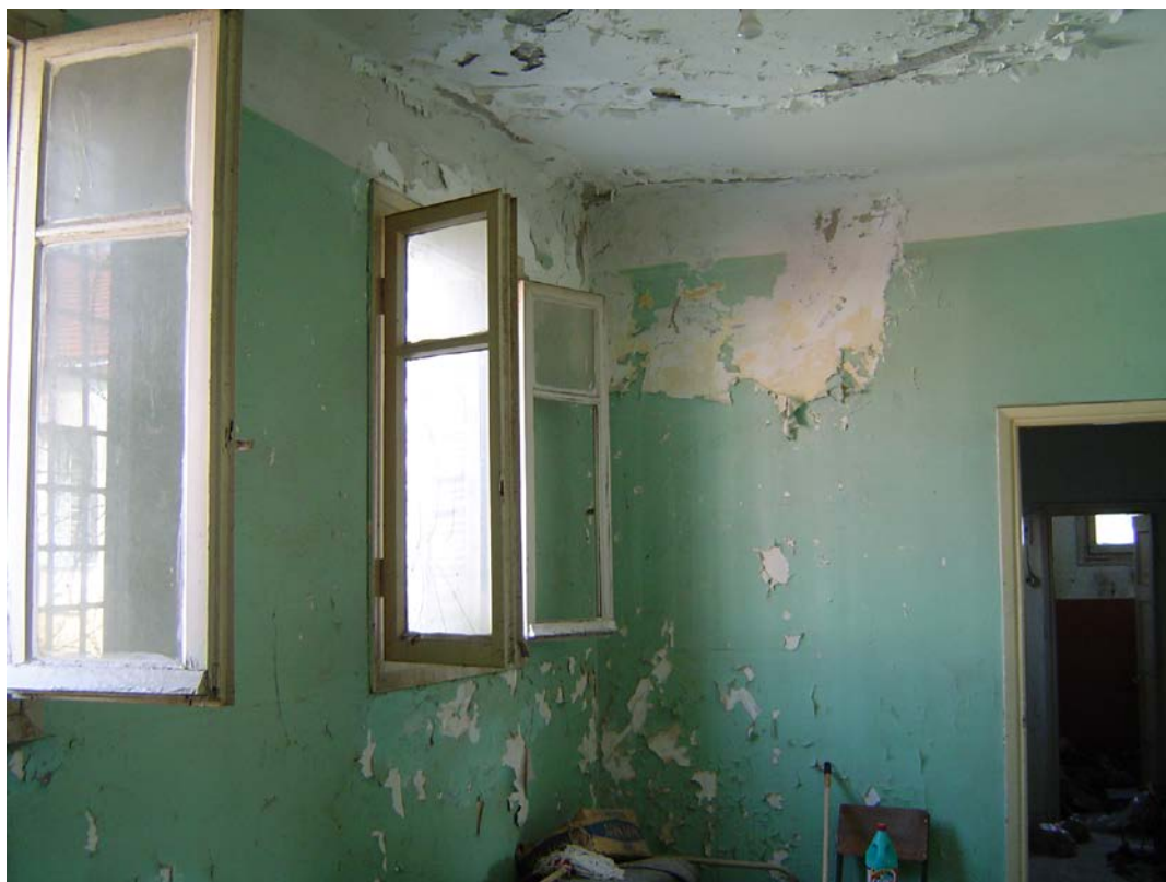
Εικόνα 1.40: Εσωτερικό άνοιγμα και κούφωμα παραθύρου των κτιρίων
