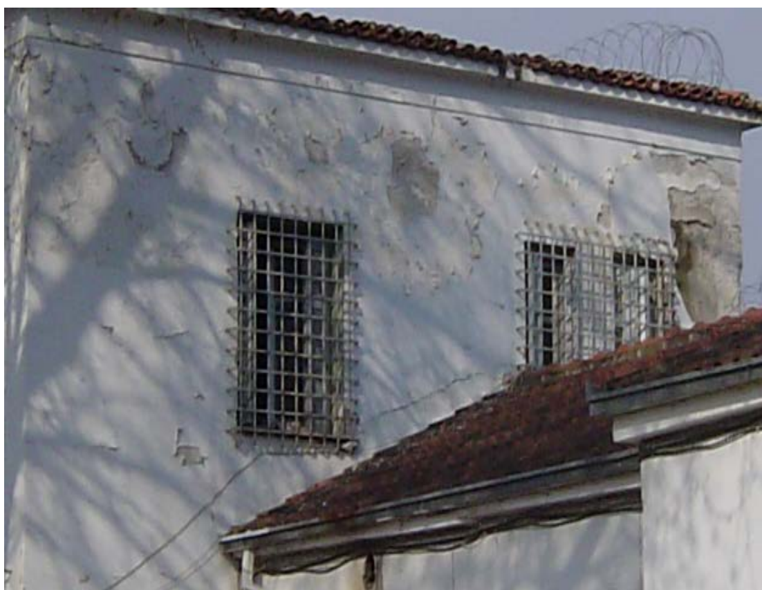
Εικόνα 2.2: Εξωτερική επιφάνεια τοίχου στο κτίριο Β
