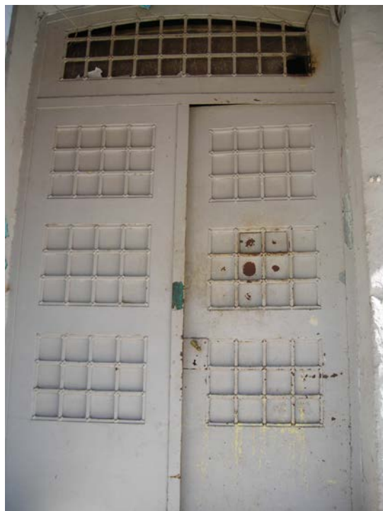
Εικόνα 1.36: Εξωτερική πόρτα κτιρίου Β στη νότια όψη του, και οδηγεί στο προαύλιο
