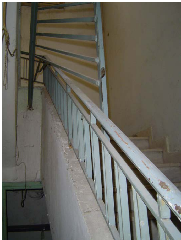
Εικόνα 1.39: Η σκάλα του Β κτιρίου
