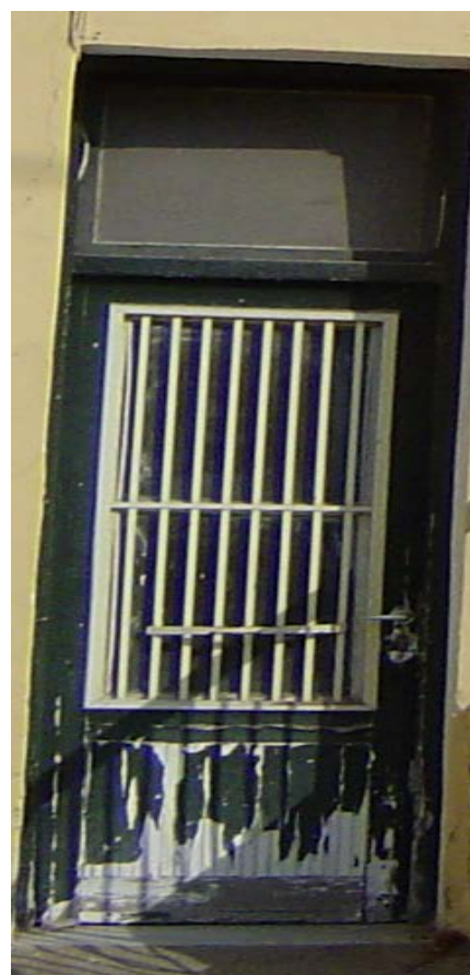
Εικόνα 1.38: Εξωτερική θύρα του κτιρίου Δ
