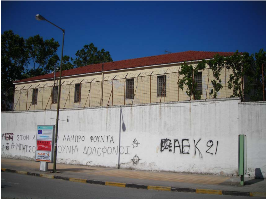
Εικόνα 1.9: Η δυτική όψη του τείχου
