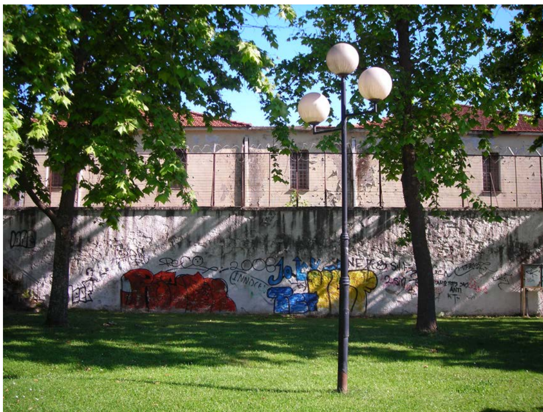
Εικόνα 1.8: Η βόρεια όψη του λίθινου εξωτερικού τοίχου που περιφράζει το κτίριο των φυλακών
