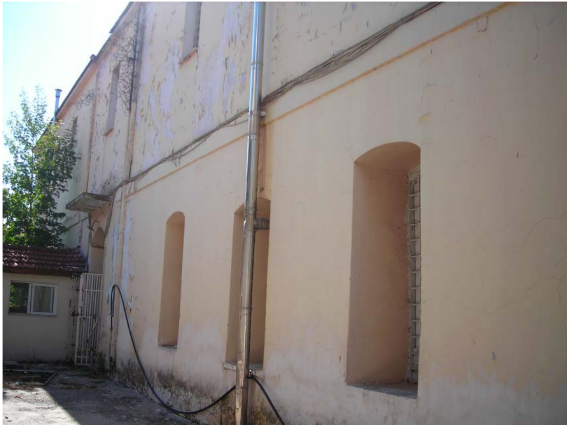
Εικόνα 1.32: Η βόρεια όψη του κτιρίου Α
