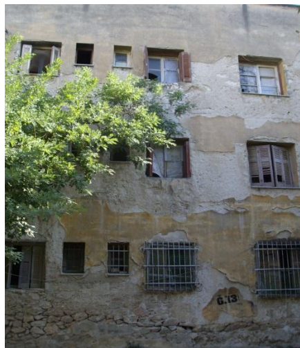
Εικόνα 7.ΒΟΡΕΙΑ ΟΨΗ ΚΤΙΡΙΟΥ 1.
