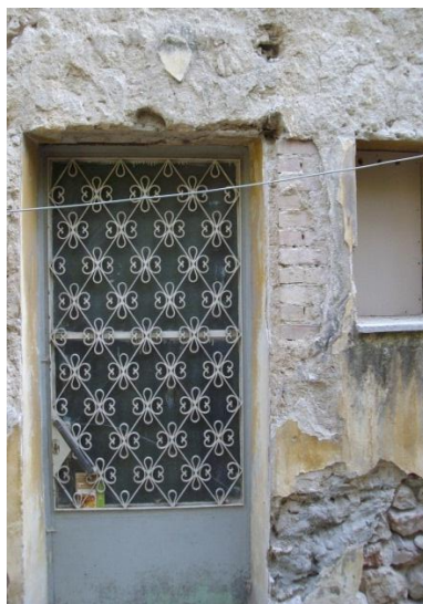
Εικόνα 18. ΒΟΡΕΙΑ ΟΨΗ ΚΤΙΡΙΟΥ 4 (ΔΙΑΝΟΙΞΗ ΘΥΡΑΣ)
