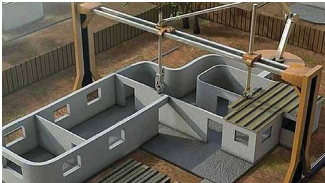
Σχήμα 4. 4 Κατασκευή κτιρίων με την βοήθεια ρομπότ και τη διαδικασία Contour Crafting
