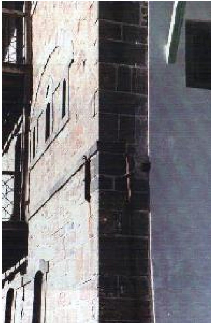
Μεταλλικοί ελκυστήρες (Ι.Μ. Σιμωνόπετρας)
